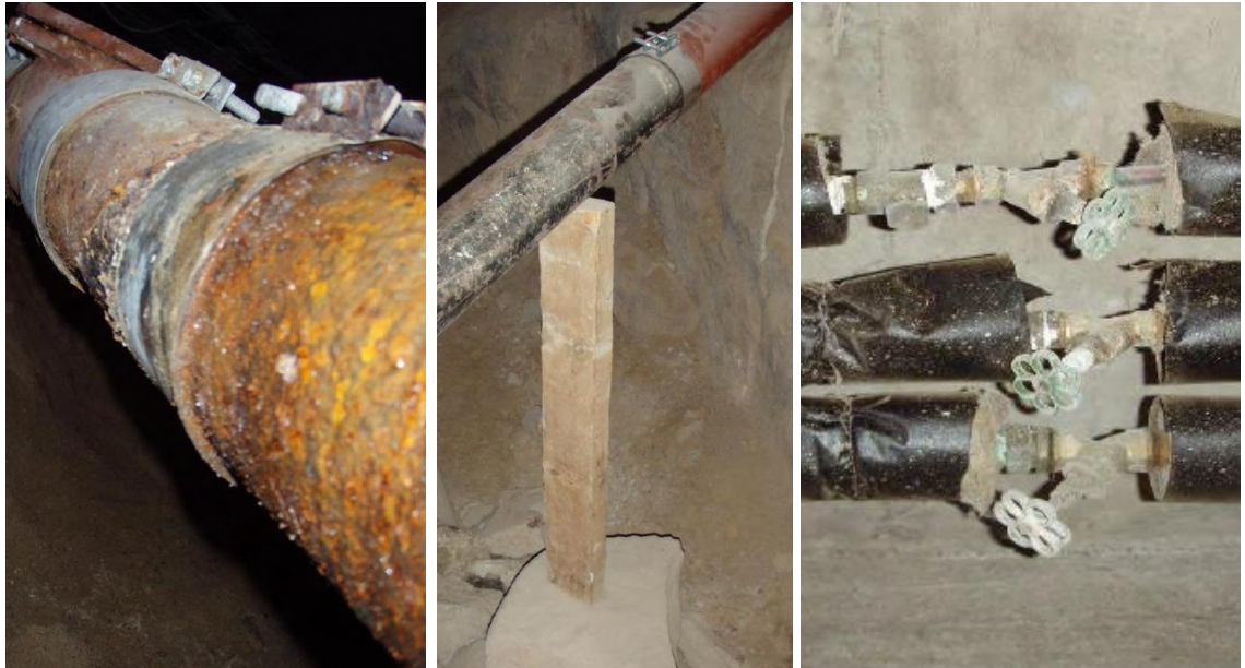
Kuva 18. Viemäriputkien kuntoa ja kannakointia sekä käyttövesiputkiston vanhat venttiilit.
