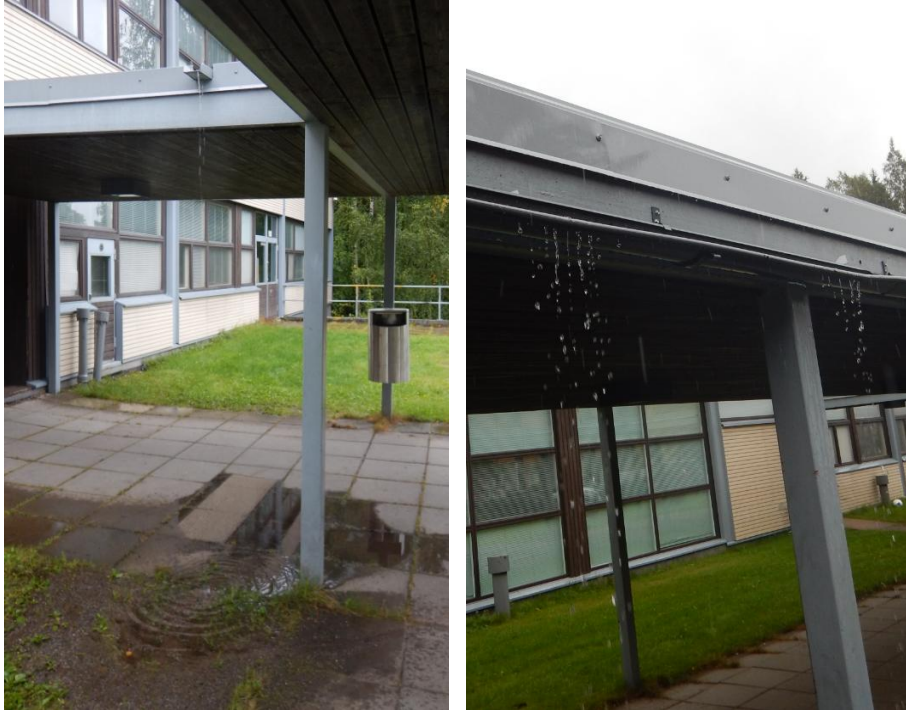
Kuva 15. Sisäänkäyntikatoksien heikko veden poisjohdatus.
