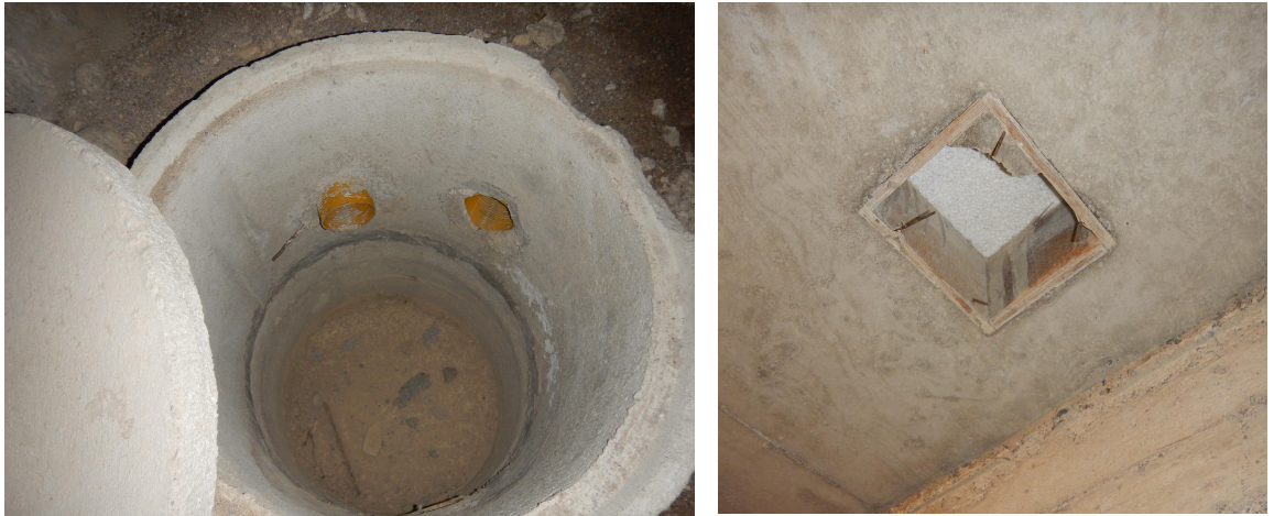
Kuva 7. Kuiva salaojien tarkastuskaivo sekä tiivistämätön läpivientivaraus ryömintätilan katossa.
