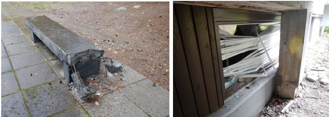
Kuva 16. Piha- ja aluerakenteissa havaittuja ilkeistä johtuvia vikoja.
