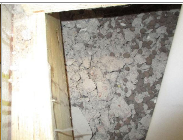
Kuva 5.2. Alapohjarakenteiden alla kulkee putkikanaali, mikä on täytetty betonimurskeella ja leca-soralla.
