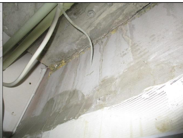
Kuva 5.16. Väliseinän rakenteissa ei veden valumajälkiä.
