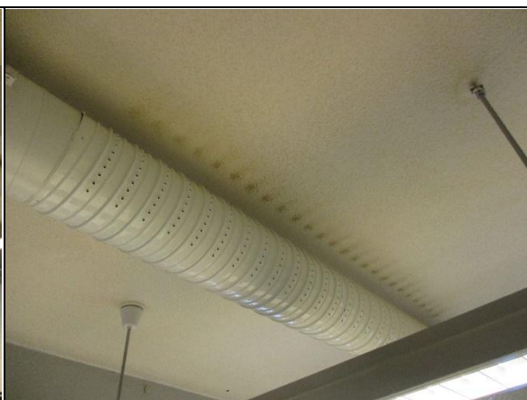
Kuva 5.19. Selluloosakuitupintaan jää tummentumia tuloilman mukana tulevista hiukkasista.
