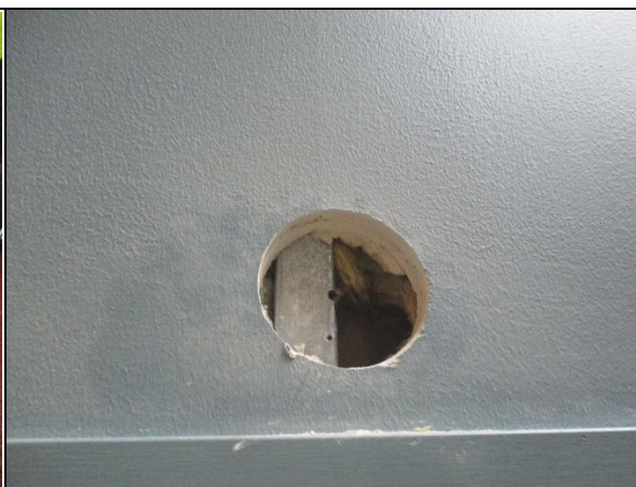
Kuva 5.16. Aulan väliseinä on toisen kerroksen osalta kevytrakenteinen.
