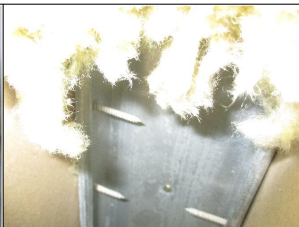
Kuva 5.12. Väliseinän rakenteissa ei havaittu merkkejä kosteudesta.
