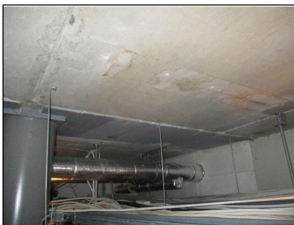
Kuva 5.17. Yleiskuva alakaton yläpuolisesta tilasta.
