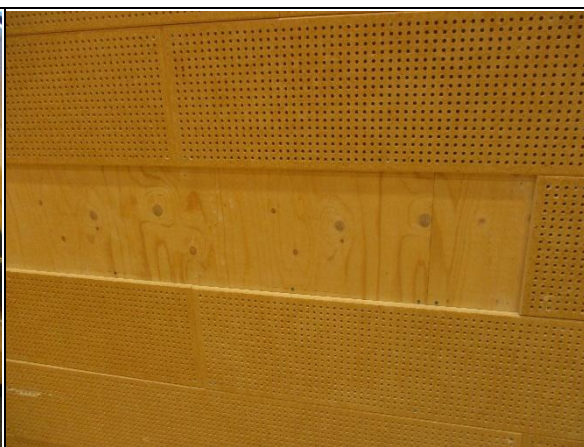
Kuva 5.8. Reikälevyn takana on vaneri.
