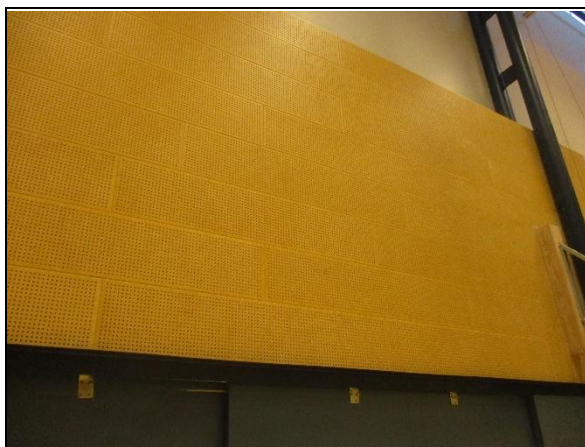
Kuva 5.7. Yleiskuva liikuntasalin akustiikka seinästä.
