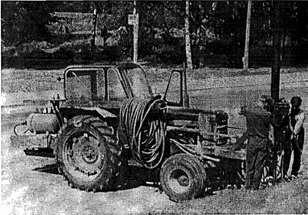
Kuva 2.1 Ensimmäinen maakairaukseen tarkoitettu porakonekaira vuodelta 1967
