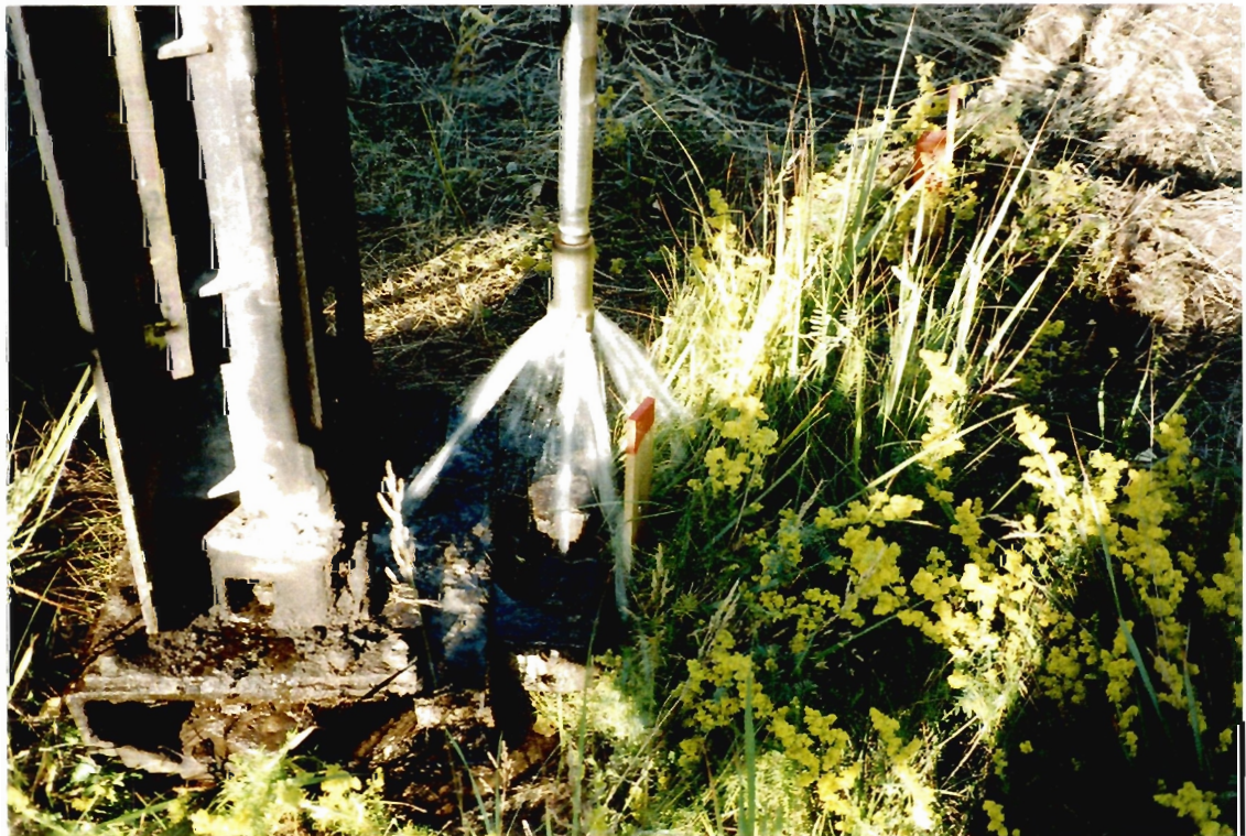
Kuva 1.1 Koeporauksissa käytettiin vesihuuhtelua
