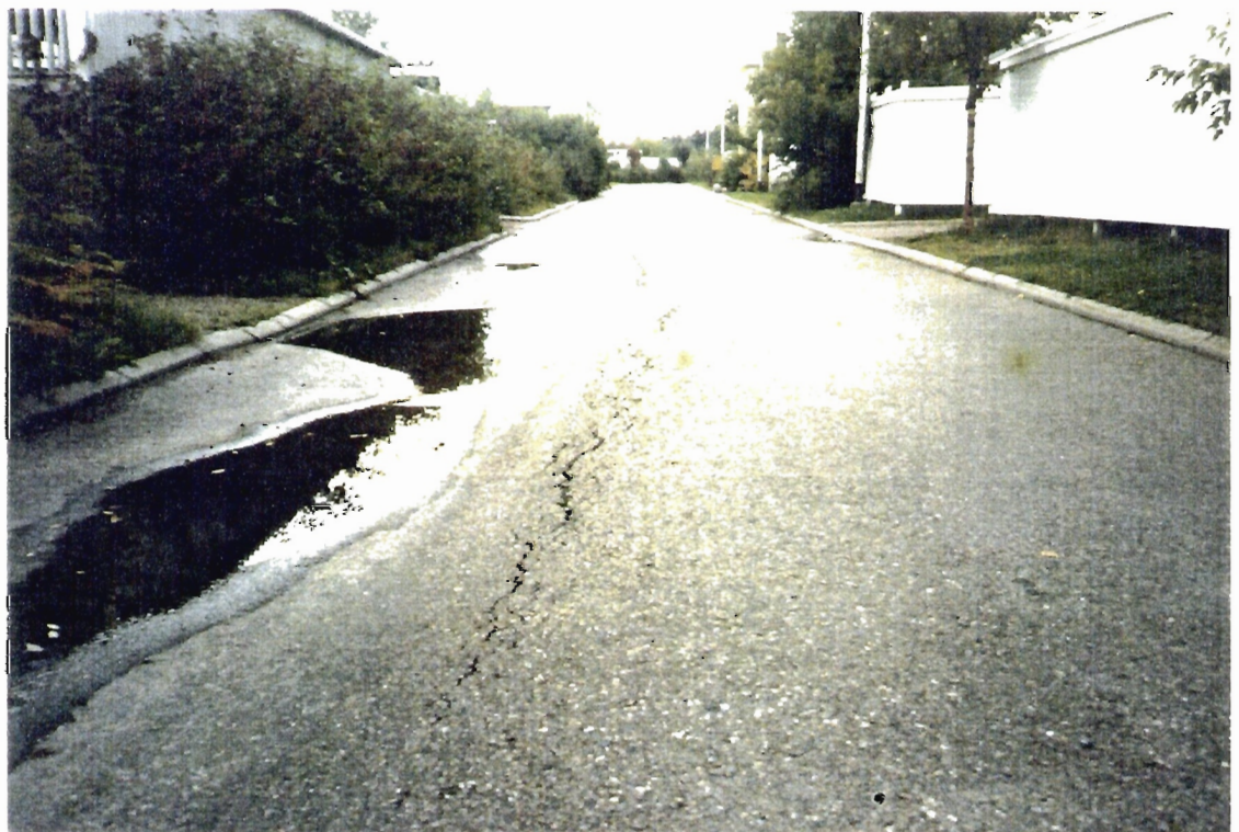
Kuva 15. Kesällä 1987 havaittuja sulamispainumia Helsingin Torpparinmäessä.
