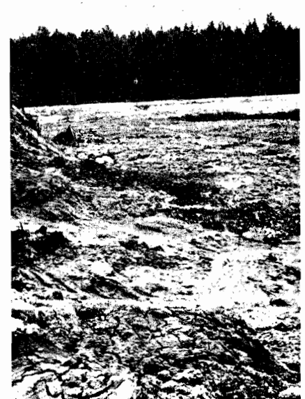
Kuva 3. Savimassa valuu täyttöpai-kalla nestemäisenä ja asettuu lähes vaakasuoraan tasoon.
