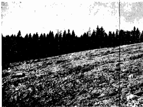
Kuva 7. Paloheinän täyttömäki v. 1970. Maapohja on kestänyt täyttömäen painon ja mäen luiskat (kaltevuus <math>< 30\%</math>) ovat pysyneet täytön jälkeen paikoillaan.
