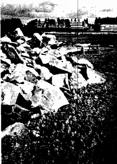
Kuva 1. Louhemassat painuvat saven sisään, jolloin paalujen lyönti on tällaisilla paikoilla erityisen vaikeata.
