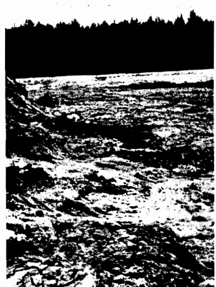
Kuva 3. Savimassa valuu täyttöpaiikalla nestemäisenä ja asettuu lähes vaakasuoraan tasoon.
