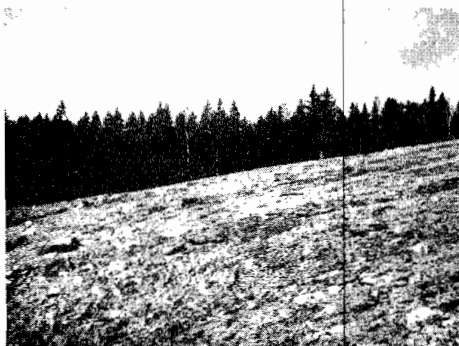
Kuva 7. Paloheinän täyttömäki v. 1970. Maapohja on kestänyt täyttömäen painon ja mäen luiskat (kaltevuus < 30 %) ovat pysyneet täytön jälkeen paikoillaan.
