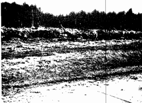
Kuva 5. Tattarisuon täyttöpaiikan murtunut savi"aalto" ulottui lähes lentokentälle asti.
