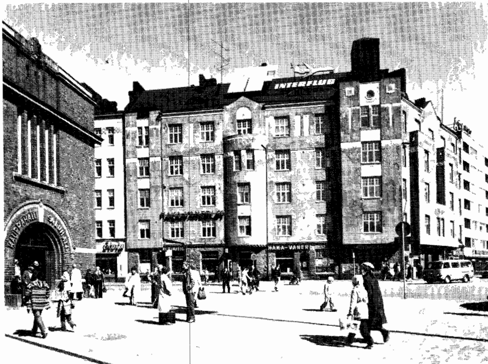
Kuva 62. Kuvan keskellä Sörnäisten rantatie 1, Hakaniementorin ja Sörnäisten rantatien kulmarakennus
