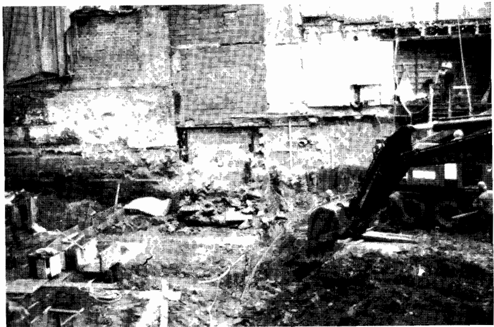
Kuva 31. Pohjatyöt käynnissä tontilla 9
