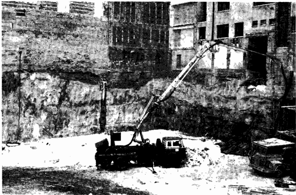
Kuva 36. Kellarikaivannon rakennustyöt käynnissä Lönnrotink. 8-10:ssä.
