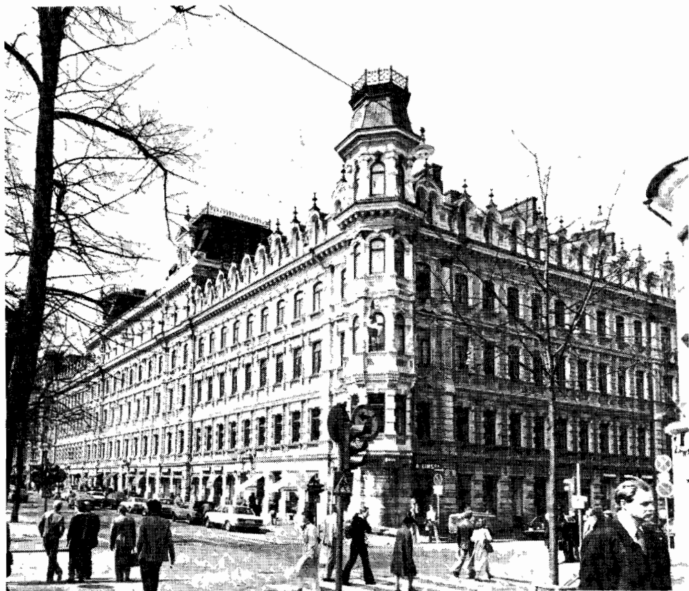
Kuva 21. Gröngvistin "kivimuurin" perustukset on vahvistettu vuonna 1973.
