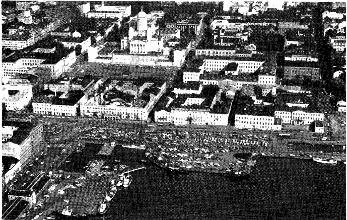
Kuva 60. Kuva Eteläsatamasta. Pohjoisesplanadin alkupään rakennuksia. Kaupungintalon rakennustyöt käynnissä kuvan ottohetkellä
