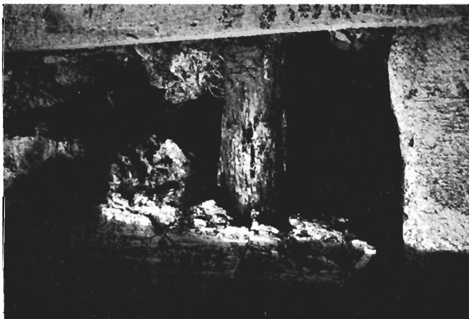
Kuva 14. Lahonnut puuperustuksen osa Aleksanterinkatu 11:n alla.
