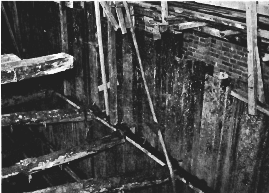
Kuva 90. Ponttiseinä 18.11.1958 rakennustyömaalla Kluuvikatu 4 (Helsingin kaupunginmuseon kuvakokoelmat).
