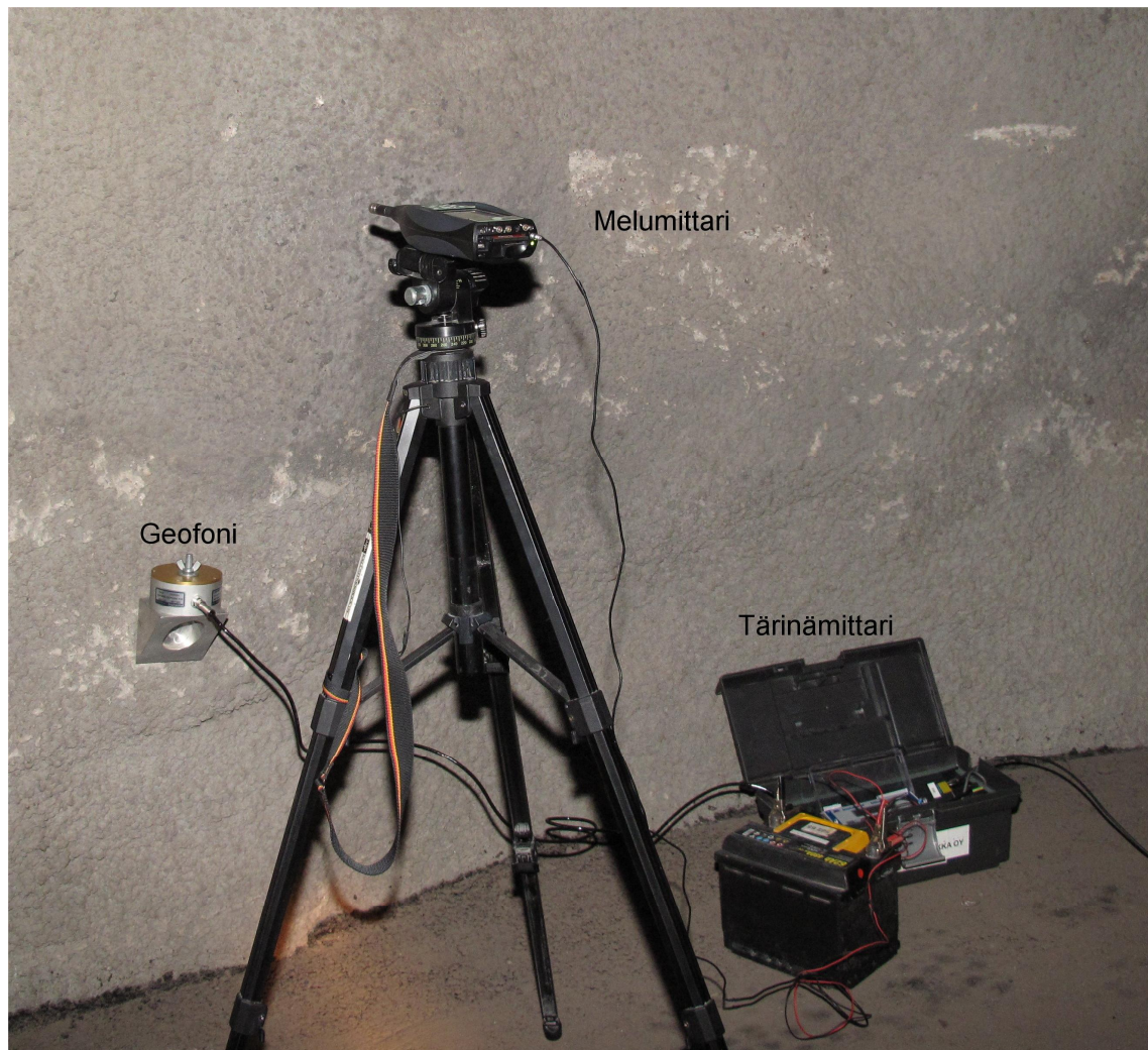
Kuva 22. Mittausjärjestely Tilkan ajotunnelissa.
