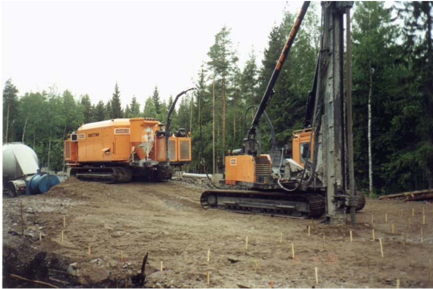
Kuva 5.3. Kivikko, ESS-koerakenteet. Stabilointiin käytetty pilaristabilointilaitteisto
