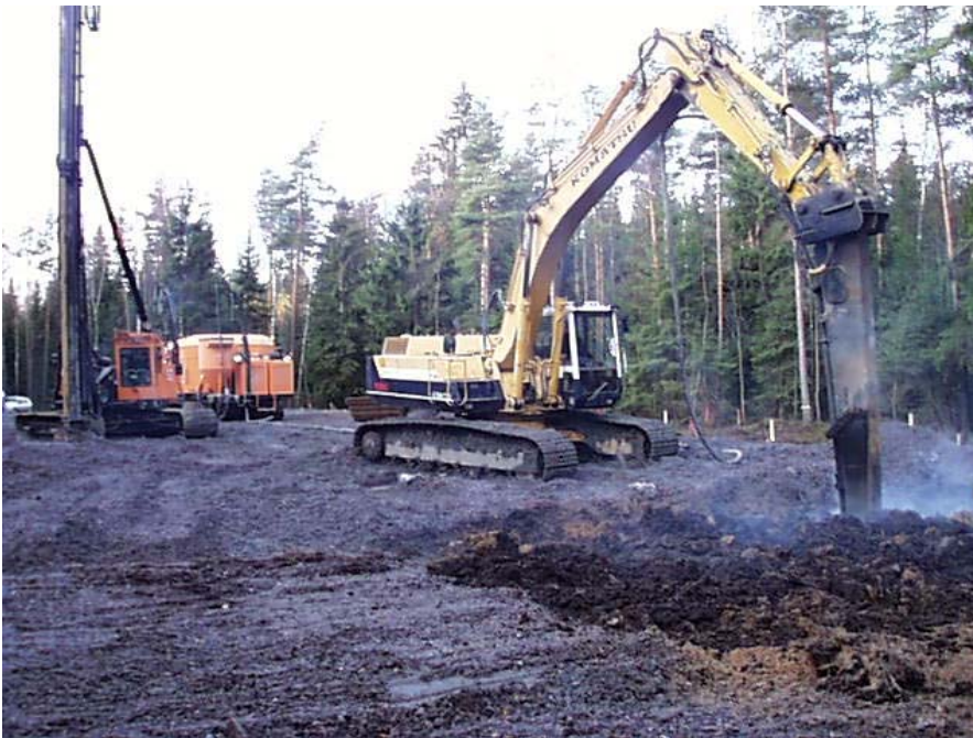
Kuva 5.5. Kivikko. ESS-koerakenteet. Etualalla massastabilointilaitteisto. Taustalla sideaineensyöttölaitteisto ja pilaristabilointikone.
