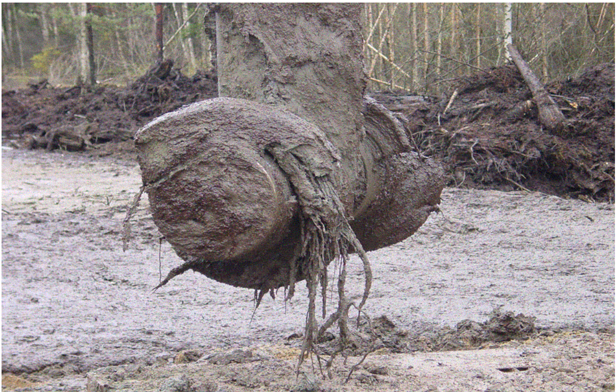
Kuva 5.9. Massastabiloinnissa käytetty ruuvimallinen sekoitusrumpu. Sekoitusrumpu osittain peittynyt stabiloitavassa turpeessa ja liejussa oleviin juuriin.
