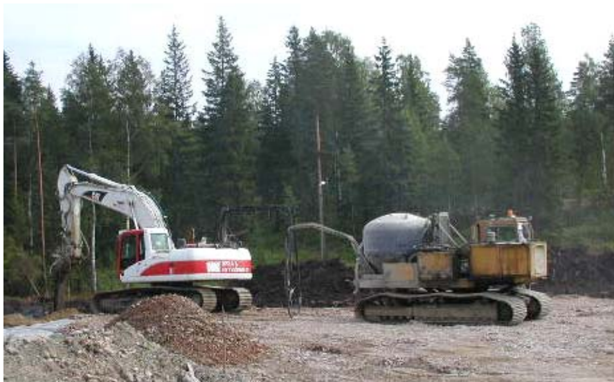
Kuva 5.13. Kivikon massastabiloinnissa käytetty laitteisto urakka-alueella 4.
