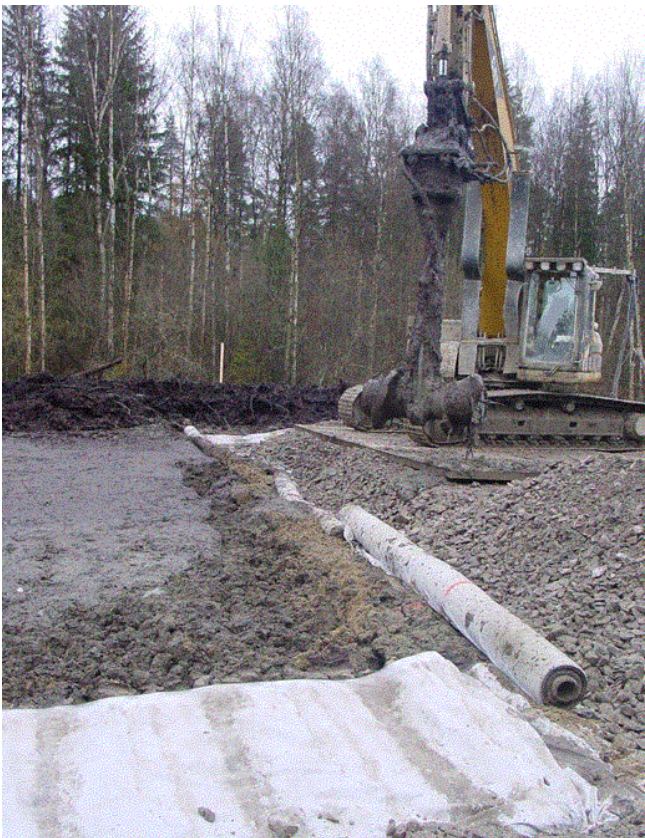
Kuva 5.8. Nykyaikainen massastabilointilaitteisto. Massastabilointi käynnissä Kivikossa. Suodatinkangas ja työpenger levitettynä stabiloidun turpeen päälle.
