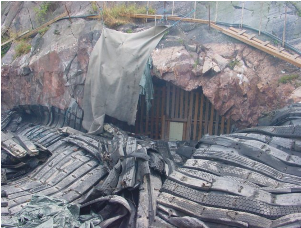
Kuva 21: Tunneliyhteys Kanavakadun kalliosuojaan, edessä räjäytysmatoilla peitetty yhteiskäyttötunnelin pystykuilu
