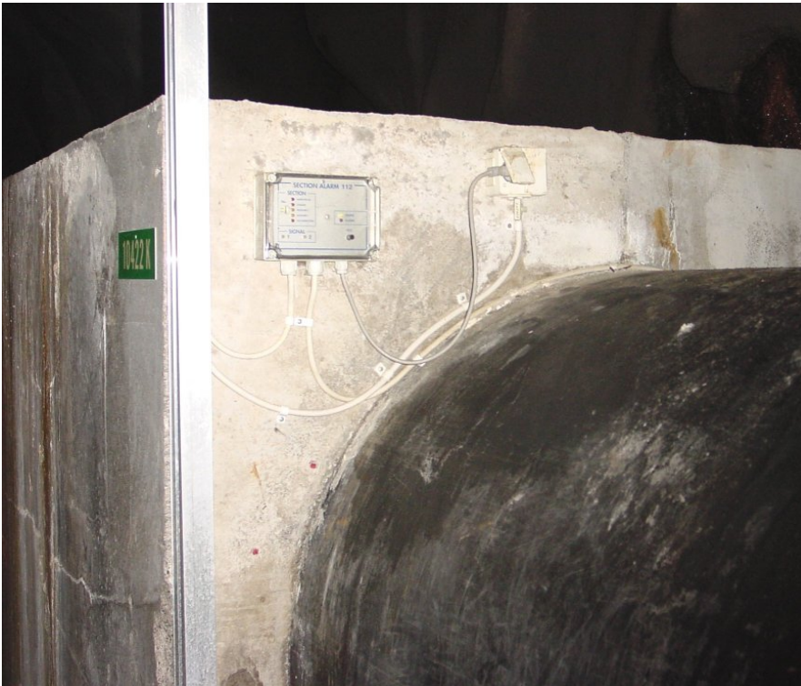
Kuva 32: Kaukolämpöputken eristeen kosteusmittari
