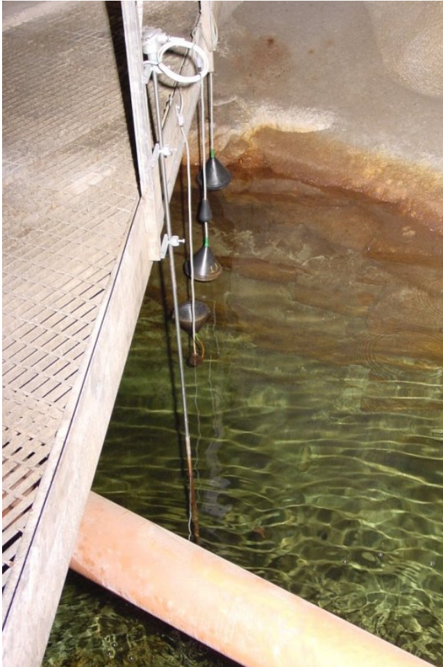
Kuva 33: Vuotovesipumppaamon tulva-anturit
