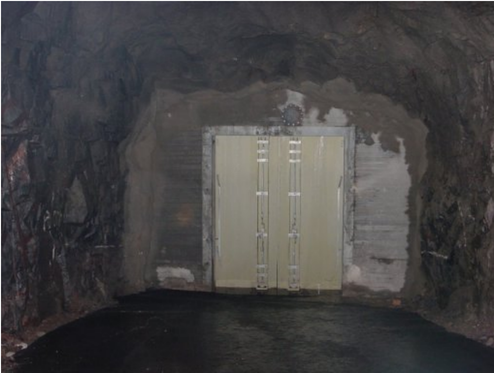
Kuva 31: Paineovi Salmisaari – Kamppi – Ruskeasuo yhteiskäyttötunnelin ja Raja-saaren viemäritunnelin välillä
