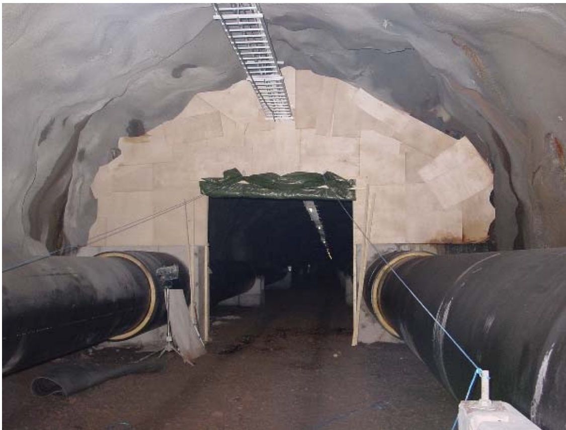
Kuva 37: Savuseinä 1 Myllypuron ja Malmin välillä
