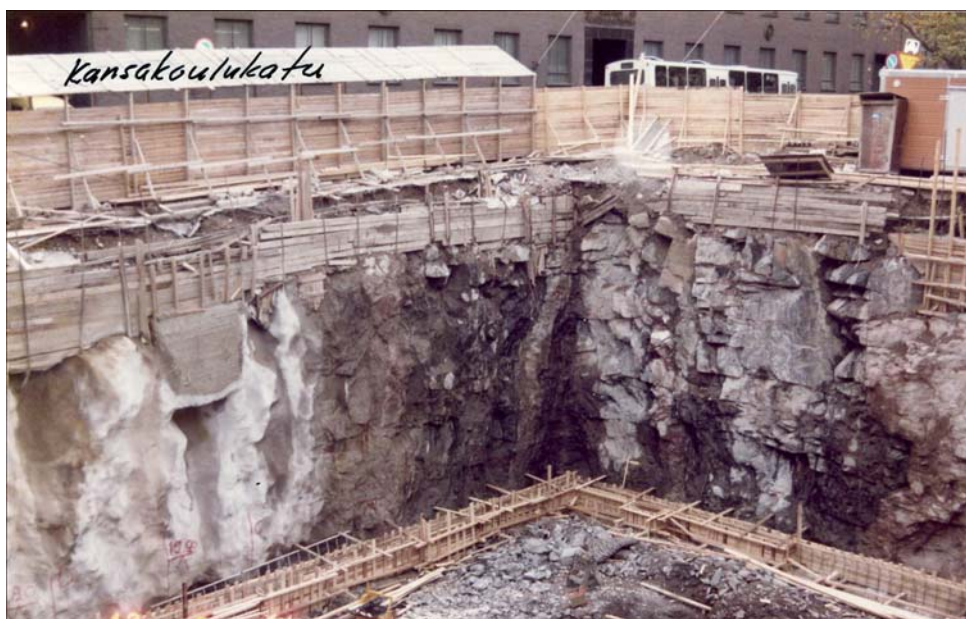
Kuva 7. Kansakoulukadun ruhje leikkaa rakennuskaivantoa, ruhjeen heikoin kohta on ruiskubetonoitu. (Martti Terrihauta 1985)
