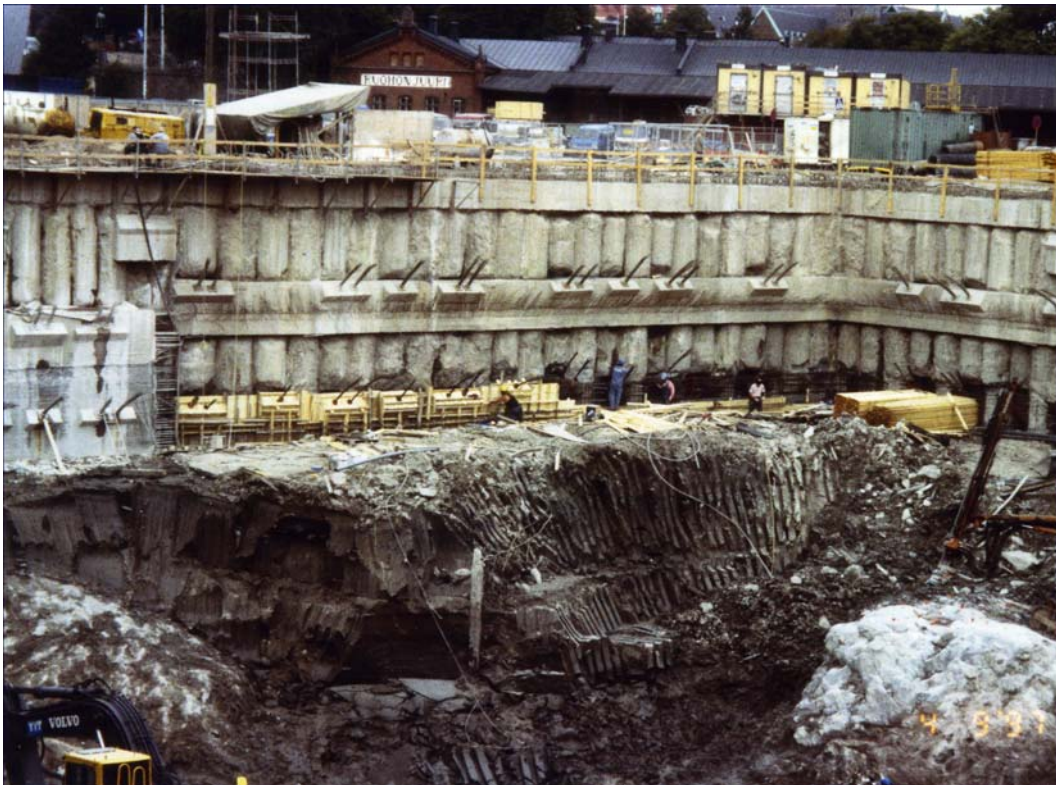
Kuva 16. Kluuvin ruhje Sanomatalon kaivannossa. Kuvan alakulmissa näkyvät kalliomäet, joiden välissä savitäytteinen painanne. (Martti Terrihauta 1997)
