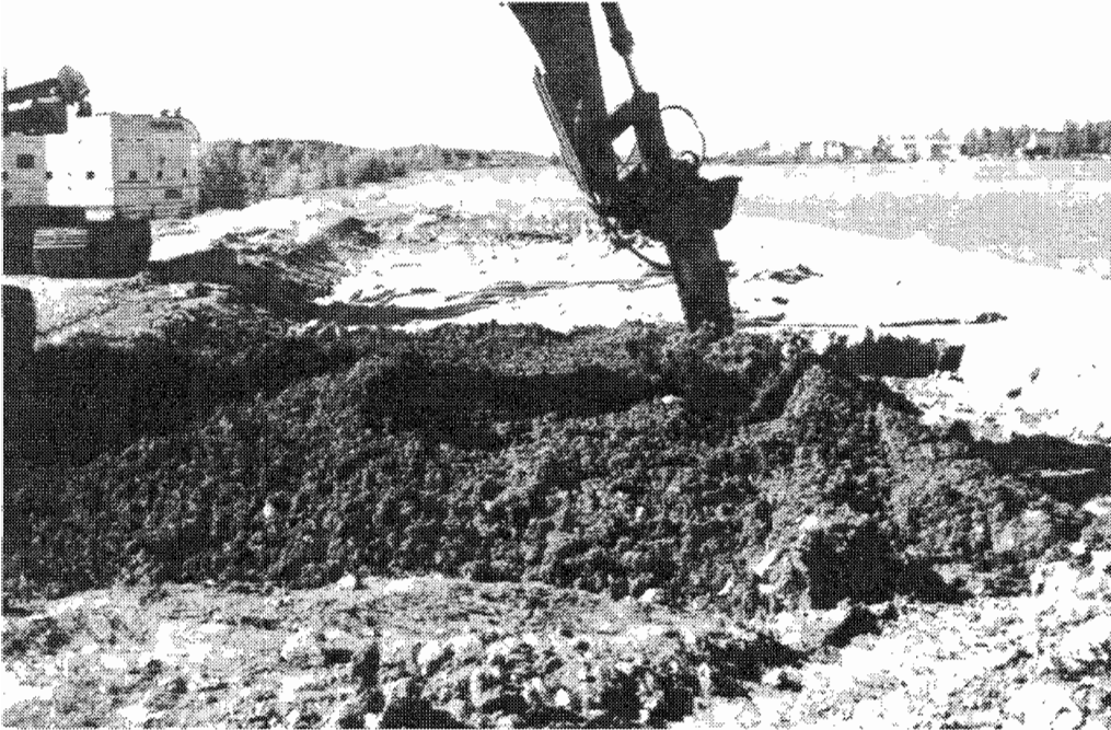
Kuva 13. Saven massastabilointia in situ kaivannossa.
