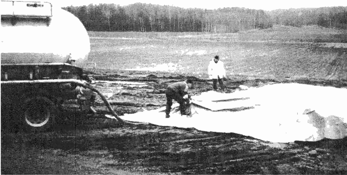
Kuva 10. Sideaine puhallettiin suojapeitteen alle pölyämisen estämiseksi.
