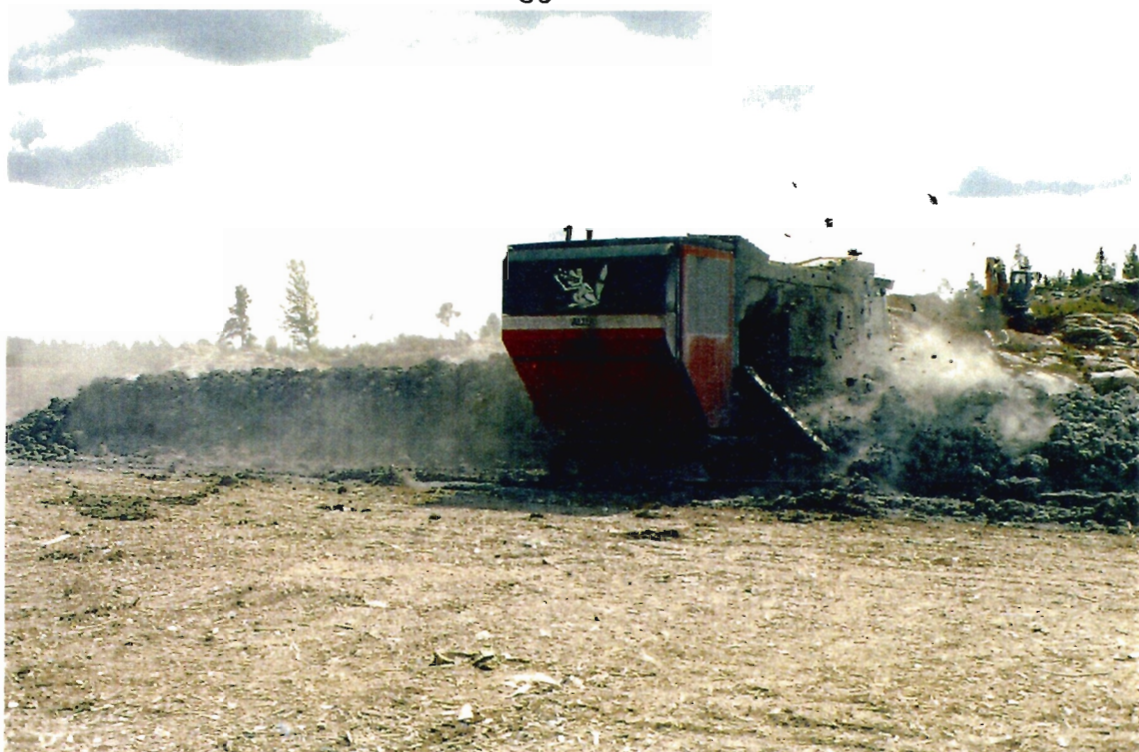
Kuva 25. Saven stabilointikokeilu Allu AS -tyyppisellä aumasekoittimella Vantaan Pitkäsuolla.
