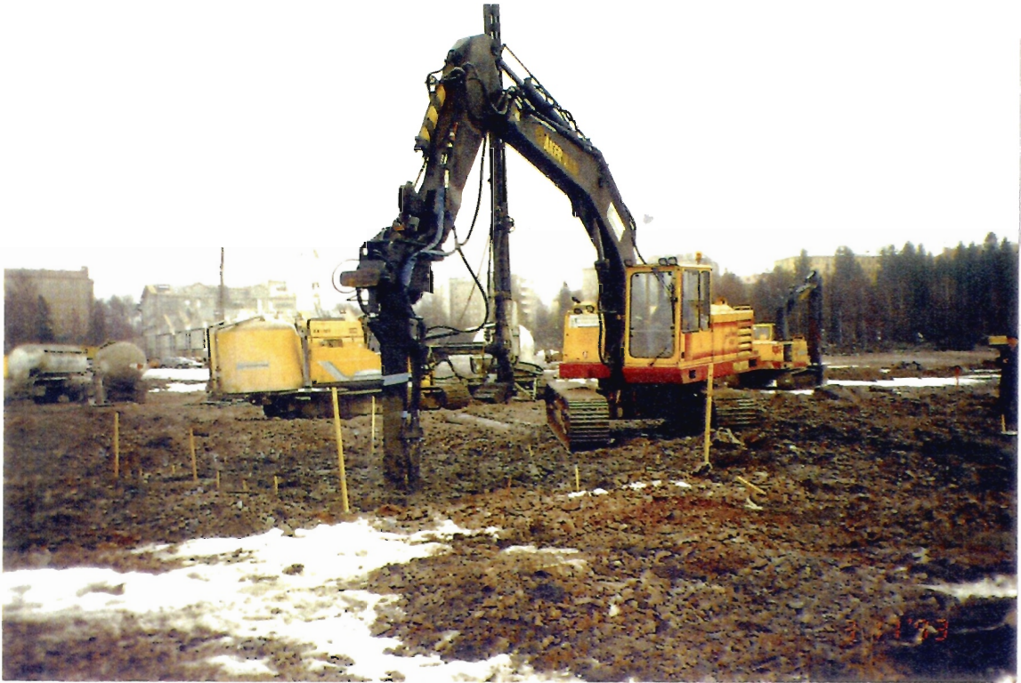
Kuva 27. Saven stabilointikokeilu aktivaattorilla Pikku-Huopalahdessa.
