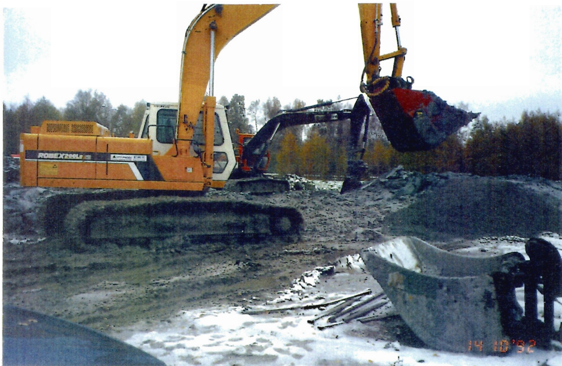
Kuva 22. Tattarisuon saven stabilointikokeilu Allu SM -tyyppisellä seulamurskaimella.
