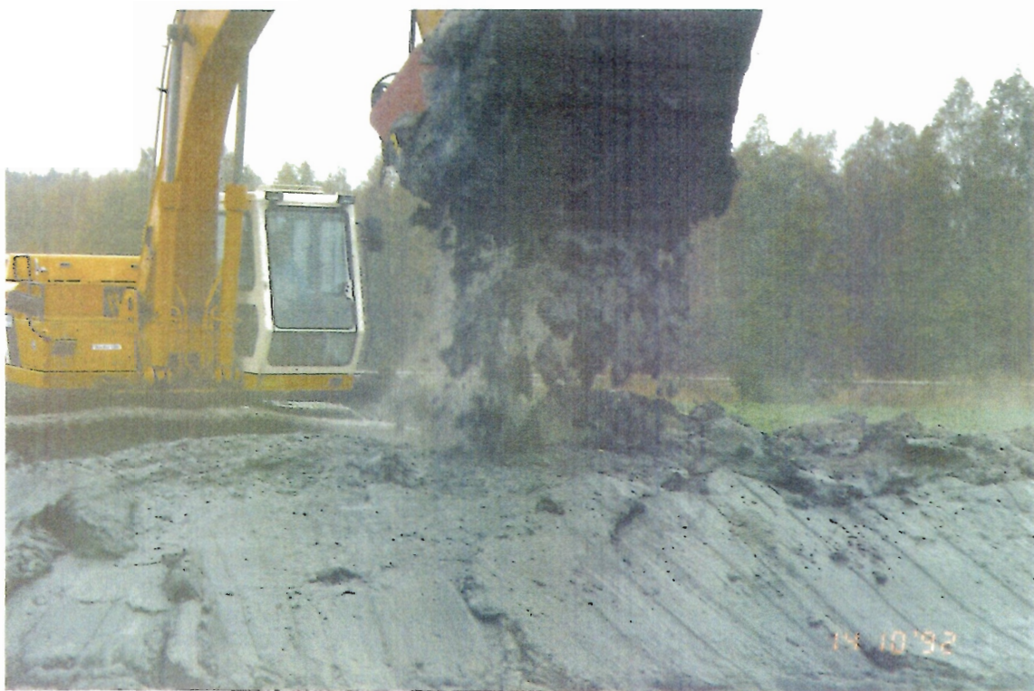
Kuva 23. Lähikuva saven ja sideaineen sekoittamisesta seulamurskaimella.
