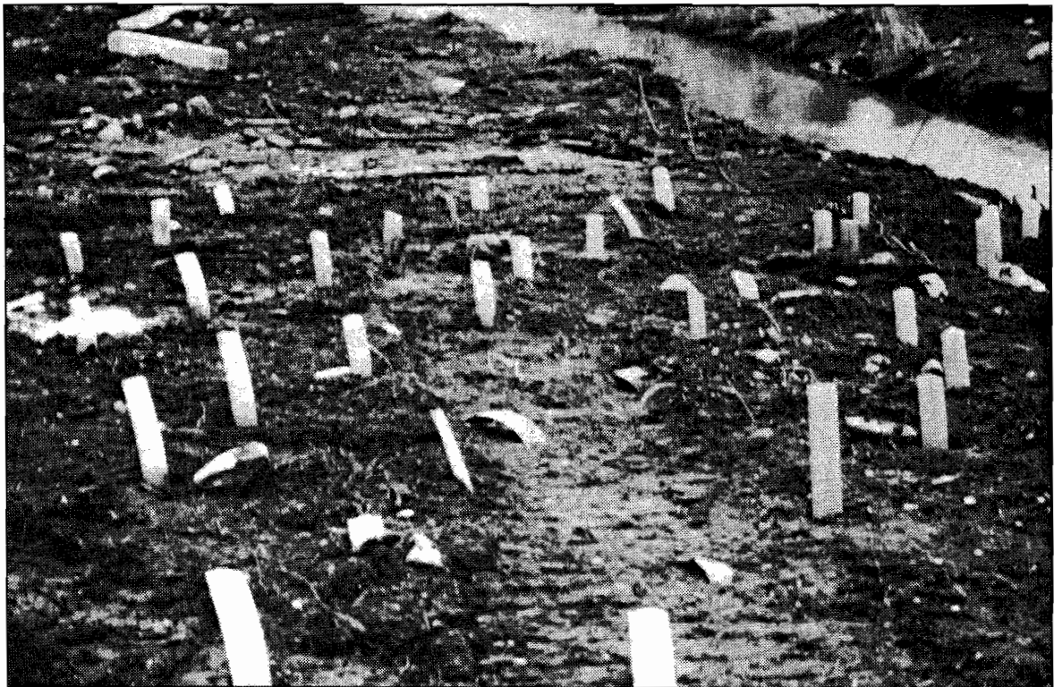
Kuva 20. Asennettuja pystyoja Korppaanmäentien pohjoispuolella. Taustalla Mätänpuro.
