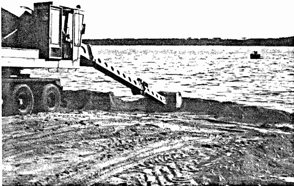
Kuva 45. Suojahiekan levittäminen kesäoloissa teleskoop- pipuomisella luiskakoneella.
