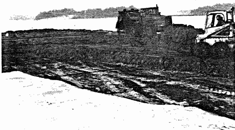
Kuva 46. Suojahiekan levittäminen talvioloissa pyöräkuor- maajalla.
