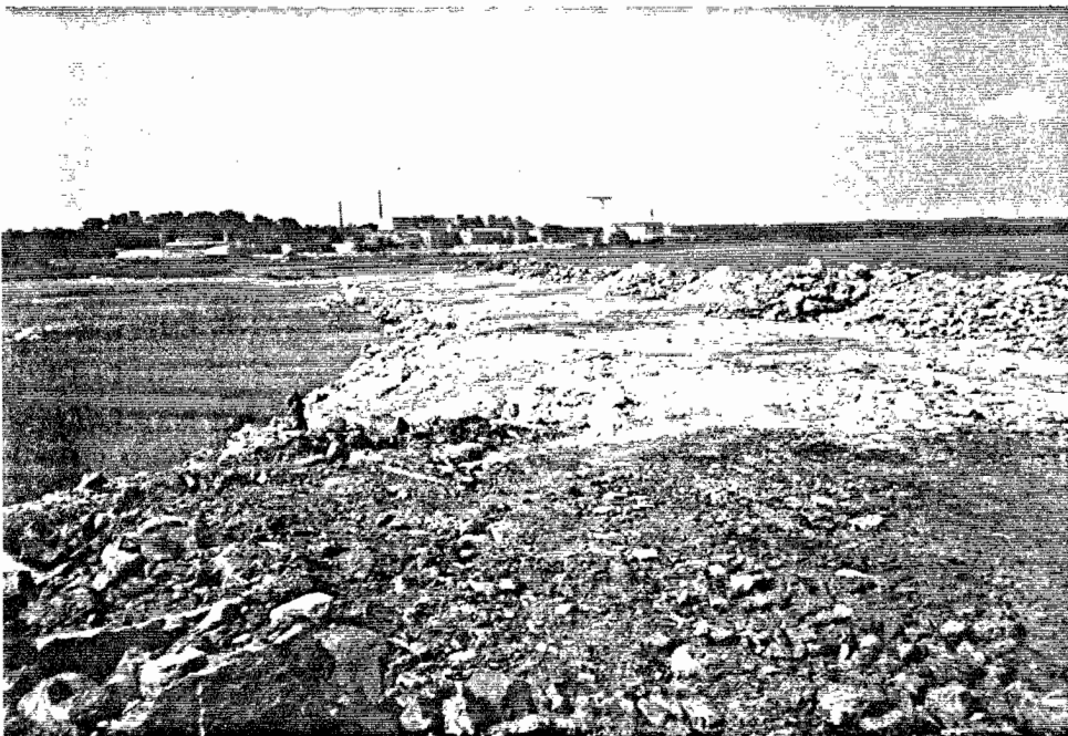
Kuva 47. Louheesta rakennettu vastapenger.
