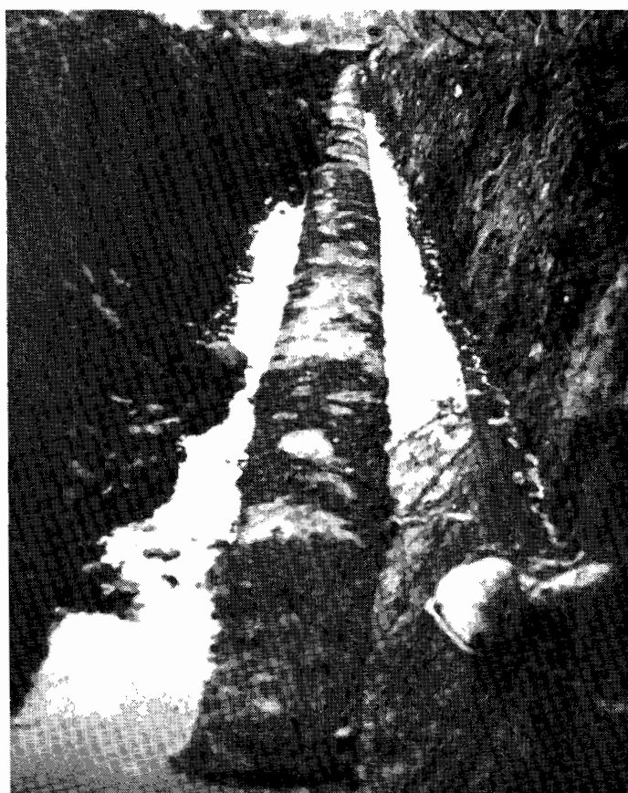
Kuva 42. Vaurioitunut kaukolämpöjohto.
