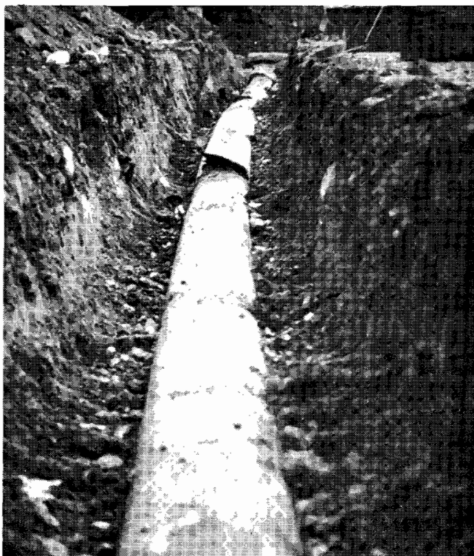
Kuva 40. Vaurioitunut kaukolämpöjohto.
