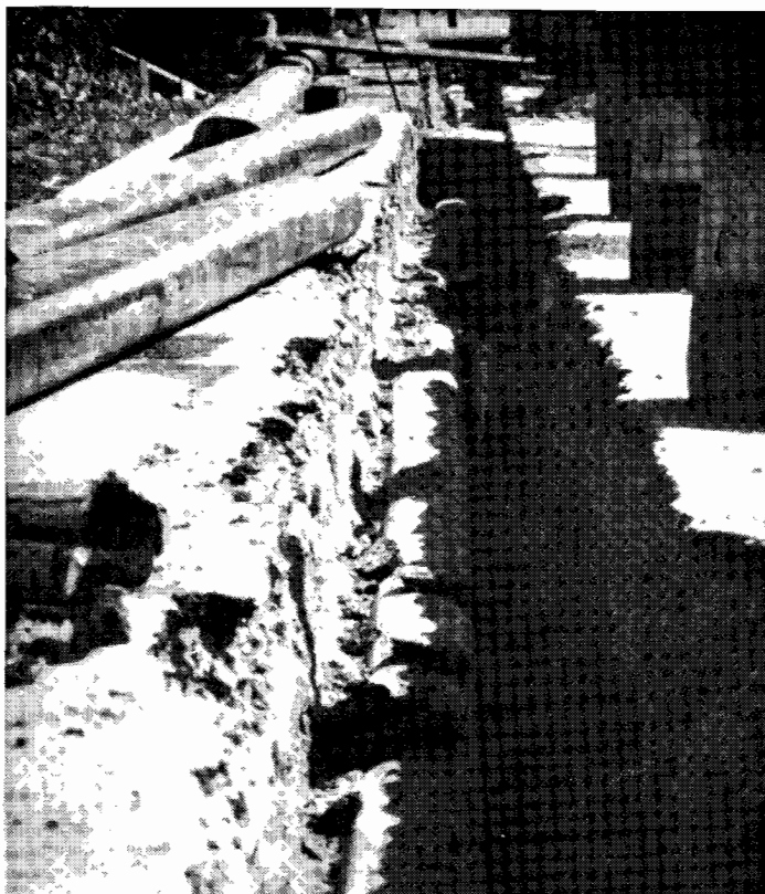
Kuva 39. Vaurioitunut kaukolämpöjohto.
