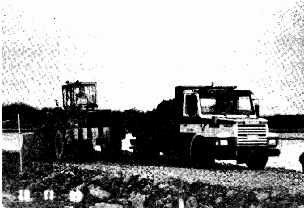
Kuva 37. Penkereen rakentamisessa käytettyjä työkoneita.
