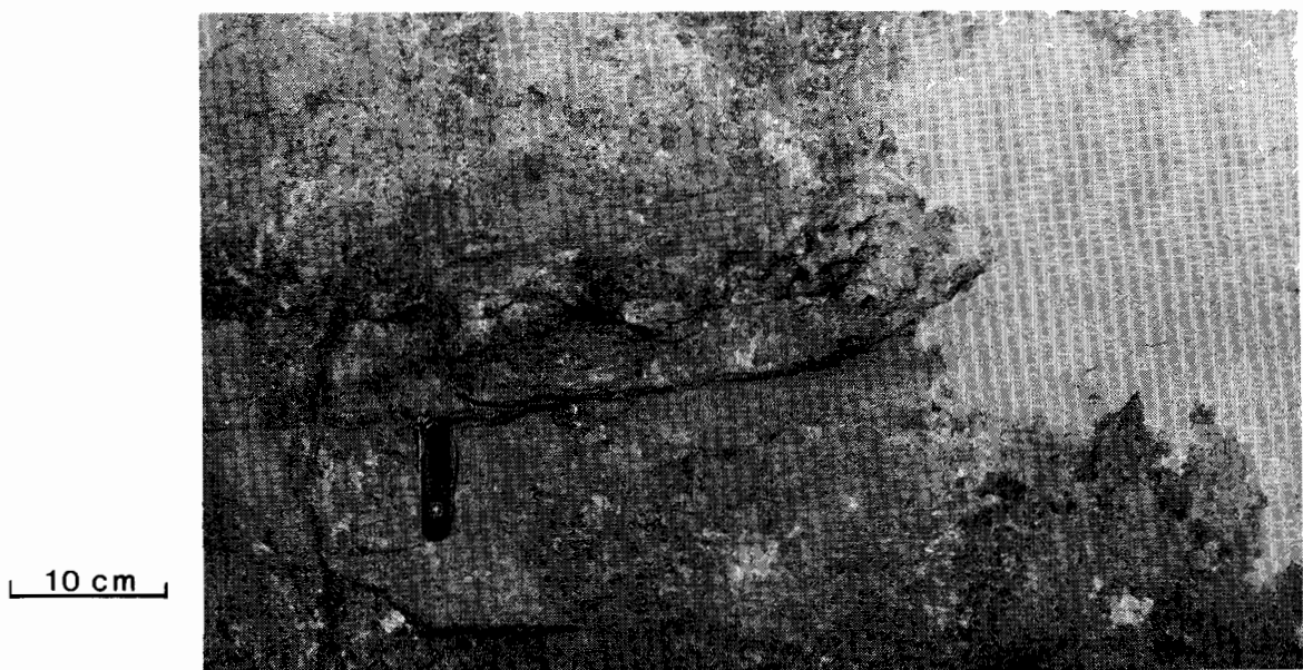
Kuva 55. Betoni-indikaattori raossa säiliön I länsipäässä.
