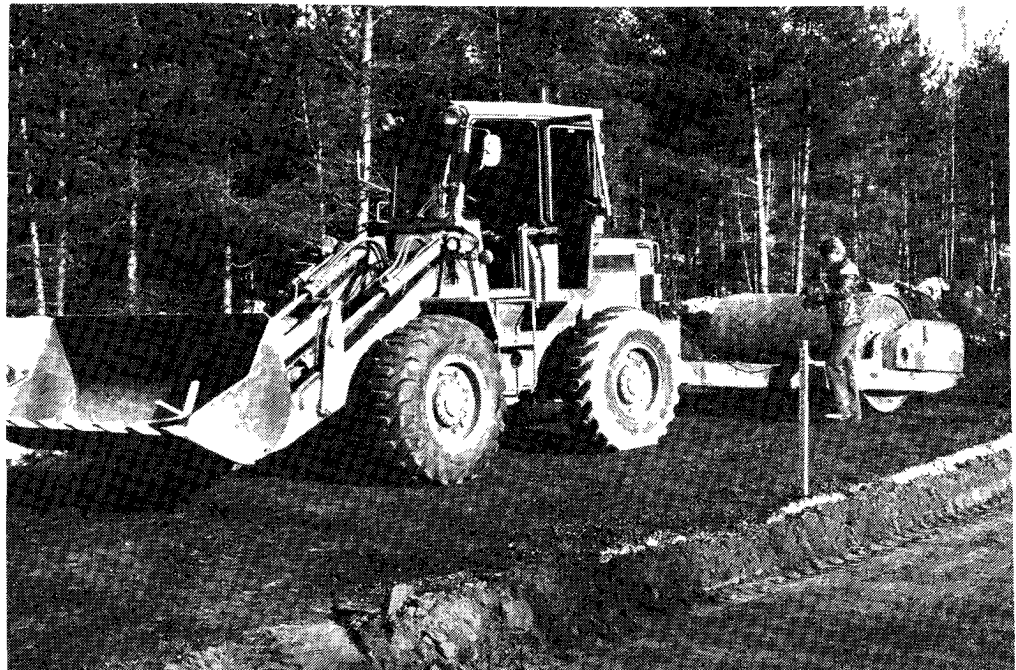
Kuva 6. Lentotuhka voidaan levittää ja tiivistää vakiokalustoa käyttäen.
