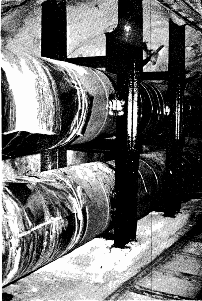
Kuva 11. Kaukolämpöjohdot kaksikerroksisen tunnelin yläkerrassa. Johtojen päälle oli laitettu muovipeitteitä, jotta päälle valuva vesi ei aiheuttaisi vaurioita.
