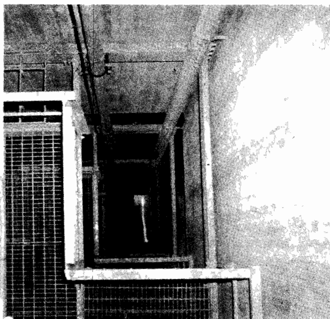
Kuva 22. Tavaroiden kuljetusaukko kuilussa.
