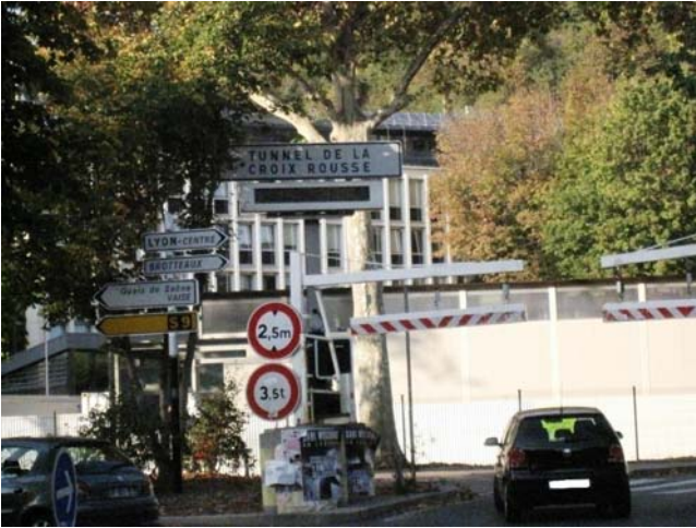
Olemassa olevan tunnelin läntinen suuaukko 17.10.2011
