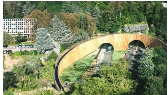
Läntinen suuaukko vuonna 2014 (vas. Pehmeän tavan tunneli ja oikealla vuonna 1952 käyttöönotettu tunneli)
