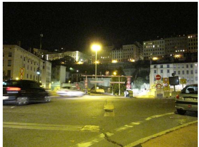
Olemassa olevan tunnelin itäinen suuaukko 16.10.2011
