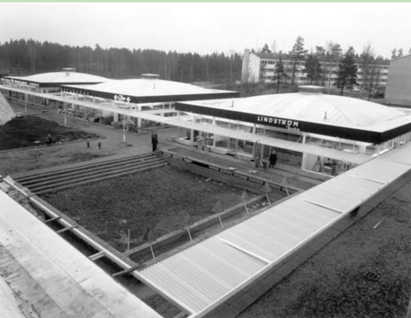
Munkkivuoren ostoskeskus rakennusvaiheessa.
