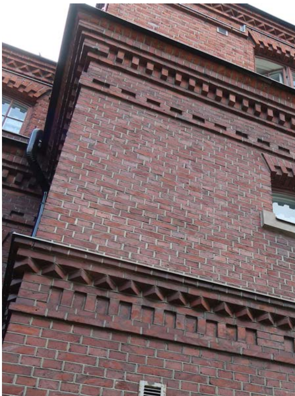
↑ Muureja jäsentävät, tiilestä muuratut jakolistat vaihtelevat kerroksittain. amoy 2024
