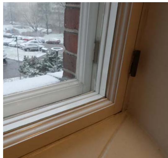
↑ Vuoden 1994 korjausvaiheessa uusitut ikkunat mukailevat alkuperäistä ikkunaa profiloinniltaan ja toistavat sen puitejakoa. Y-uralliset ikkunapenkit ovat rakennuksen valmistumisajalta amoy 2024
