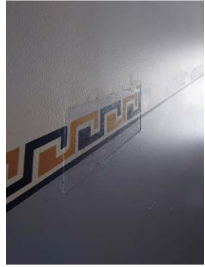
↑ Porrashuoneen vanhan värityksen esiinotto ja sen mukaan maalattu seinä. amoy 2024
