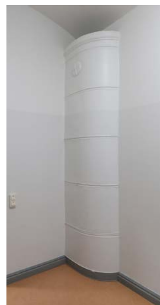
↑ Useisiin huoneisiin on jätetty – ilmei- sesti siksi, että uuni on muurattu sei- nään – sairaalan alkuperäiseen läm- mitysratkaisuun kuulunut, käytävältä lämmitettävä pystyuuni. Uunin pel- litetty takakaari huoneen puolelta nähtynä. amoy 2024
