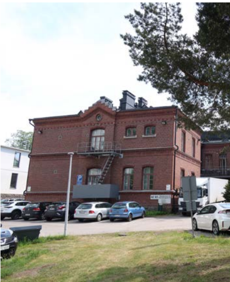
↑ Pohjoisjulkisivua, vasemmalla itäsiipeen vuonna 1959 tehty varapoistumistie. amoy 2024
