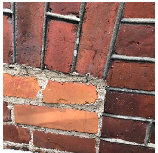
↑ Kellarikerroksen ikkunat ja halkoluukut on vuosien saatossa muurattu tai betonoitu umpeen. amoy 2024
