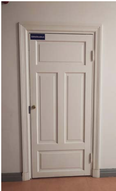
↑ Uusittu yksilehtinen peiliovi alkuperäisillä saranoilla. amoy 2024
