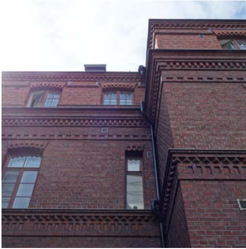
↑ Pohjoispuolta ullakkokorotukseen. amoy 2024
