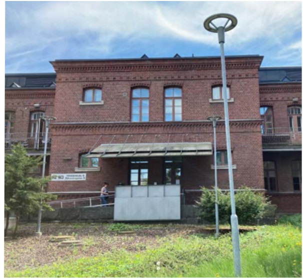
↑ Vuoden 1994 muutoksessa toteutettu pääsisäänkäynti katoksineen ja luiskineen. amoy 2024
