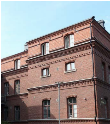
↑ Vuonna 1907 ja 1923 tehty korotusosat muurattiin värisävyltään vaaleammista tiilistä. Muureja jäsennettiin jakolistoilla. Uutena koristeaiheena tehtiin länsisiiven ullakkokohuoneiden ikkunoiden yli kiertävä sakaranauha, joka on pellitetty. amoy 2024
