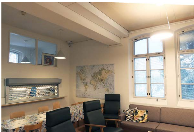
← Potilasosaston 2. kerroksen länsipäässä on ruokailutila ja keittiö, joka sijaitsee alun perin potilashuoneina toimineissa tiloissa. Nykyinen keittiö uusine väliseinineen, yläikkunoineen ja tarjoilutiskeineen on ajalta 1994 korjausvaiheen jälkeen. amoy 2024
