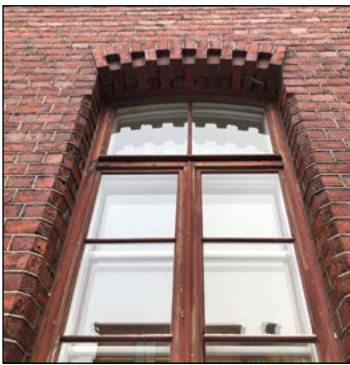
↑ 1. ja 2. kerroksen ikkuna-aukoissa on tiilestä muurattu, alareunastaan hammastettu segmenttikaari, ja ikkuna-aukon reunoja koristaa viiste. amoy 2024
