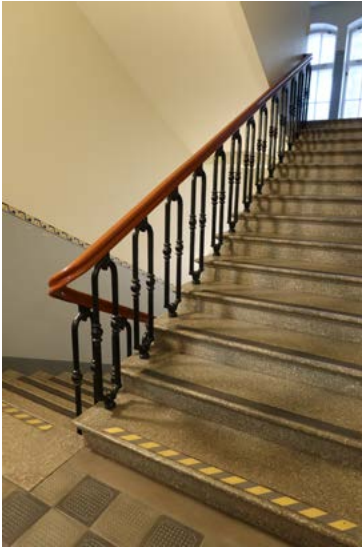
↑ Porrashuoneen mosaiikkibetoniaskelmisiä ja kaunis kaide. amoy 2024
