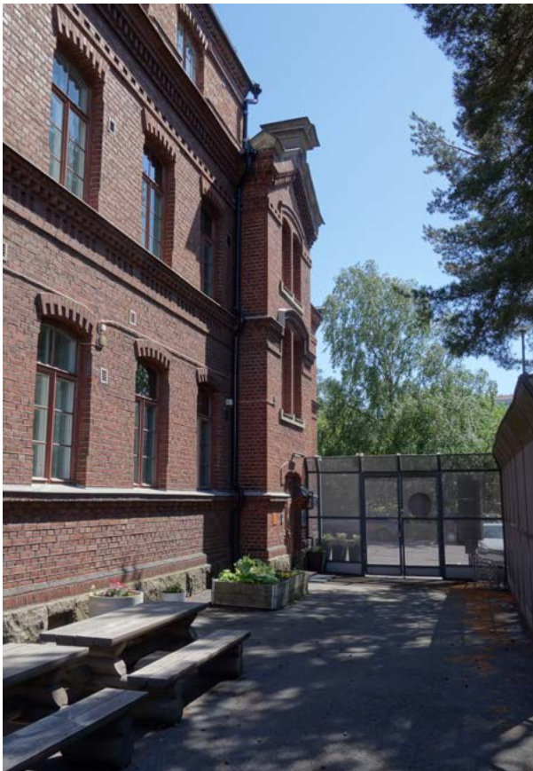
↑ Länsisiiven ulostyöntyvä porrashuone ja entinen pääsisäänkäynti, josta nyt käynti potilaiden aidatulle ulkoilupihalle. amoy 2024
