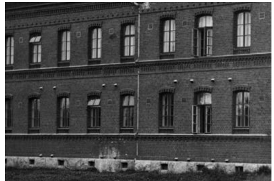
↑ Eteläjulkisivun lipallisia ja lipattomia tuloilmäsäleikköjä. Kuva aikaväliltä 1923–1929 (rajattu). HKM
