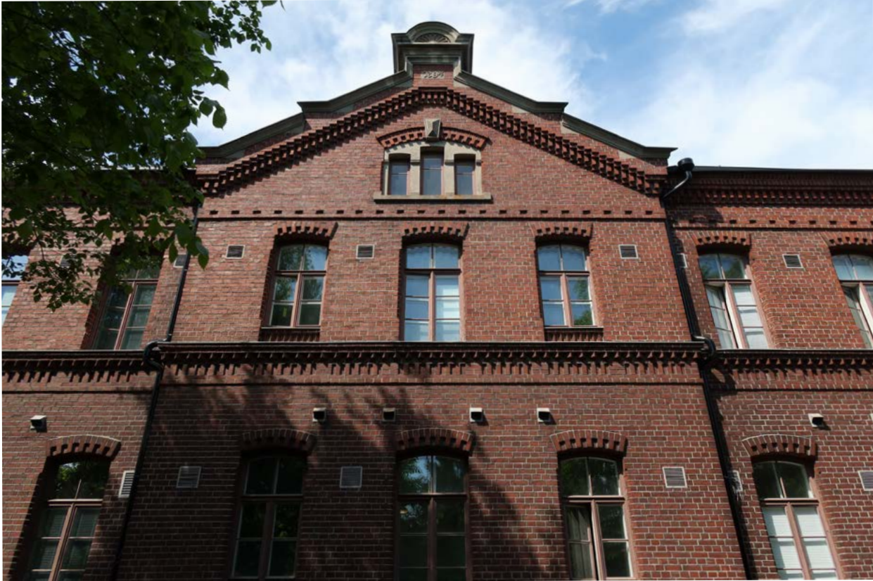
↑ Eteläisen julkisivun keskirisaliitti. amoy 2024
