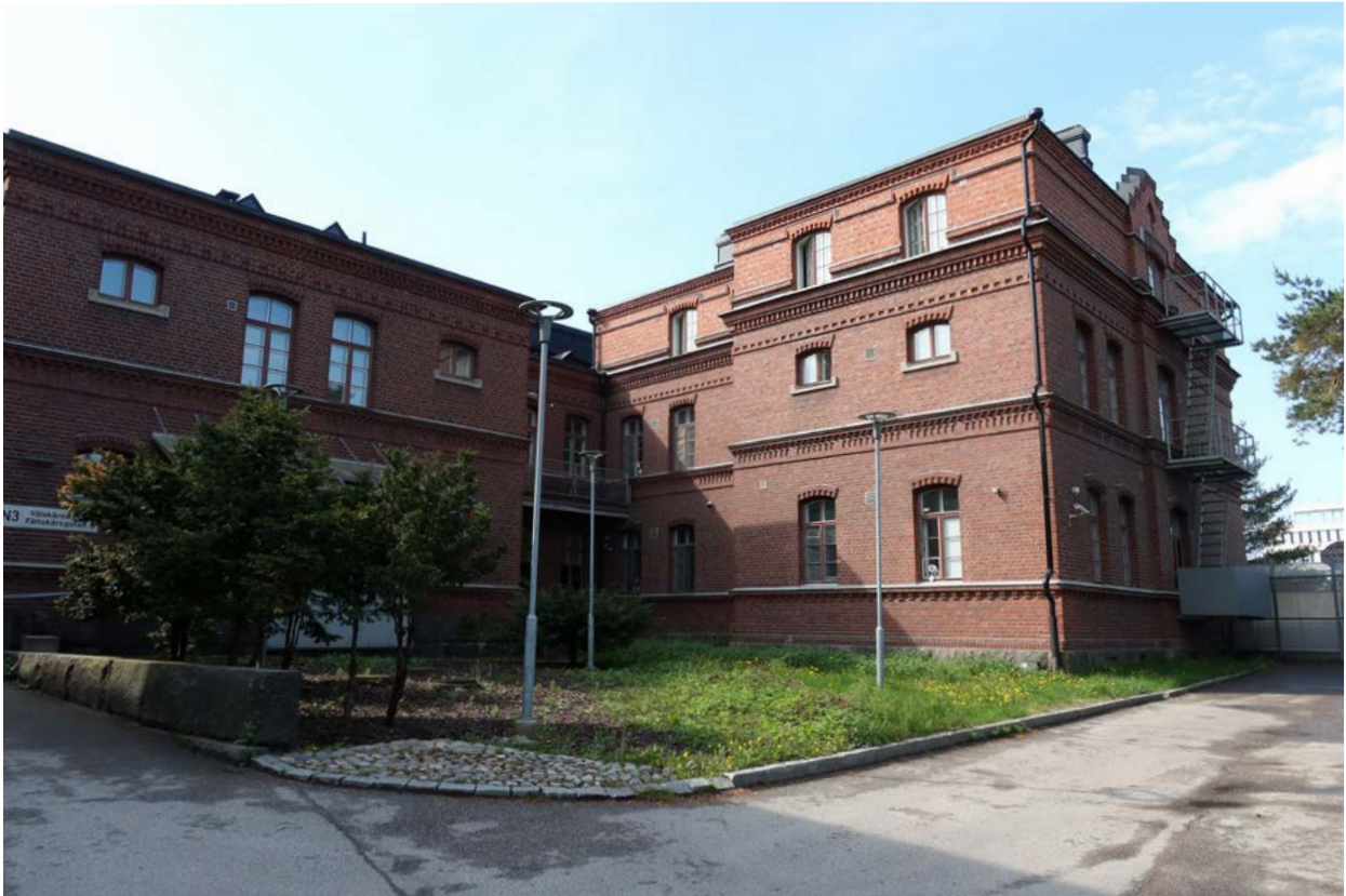
↑ Näkymä pohjoispuolelta, jossa näkyvillä vuoden 2007 varapoistumisreitti. Vuoden 1922 ullakon korotus erottuu hyvin alkuperäisestä muurauksesta. Keskisakaraan vuonna 1994 puhkaistu uusi pääsisäänkäynti jää puiden taa. amoy 2024
