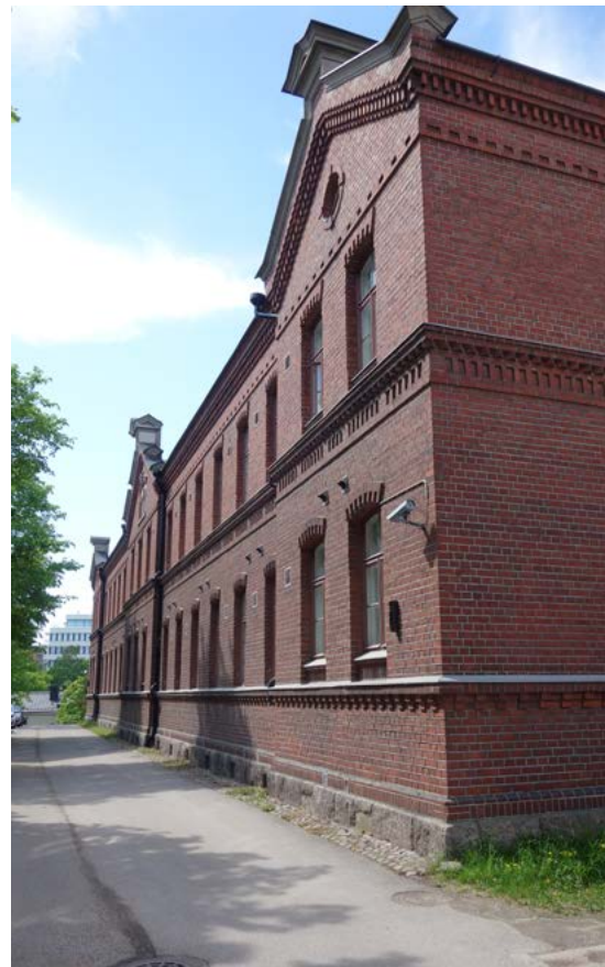
↑ Eteläjulkisivua idästä päin kuvattuna. amoy 2024
