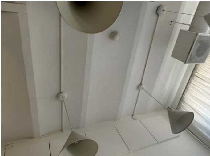
↑ Sairaalakoulun luokkahuoneen eteistilan kappaholvit ovat rakennuksen valmistumisajalta. amoy 2024
