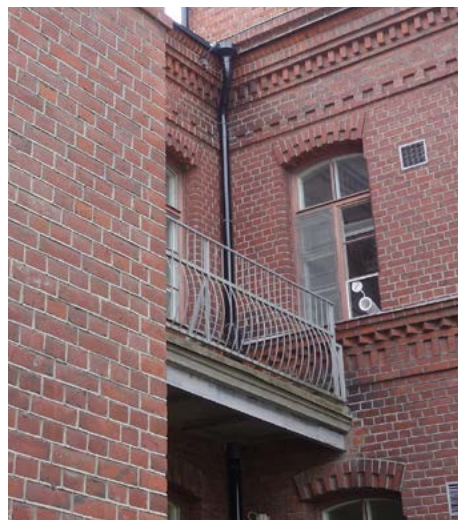
↑ Toisen kerroksen sivukäytävän parvekke. Parvekkeet lienee lisätty jo vuosina 1894...1900. amoy 2024
