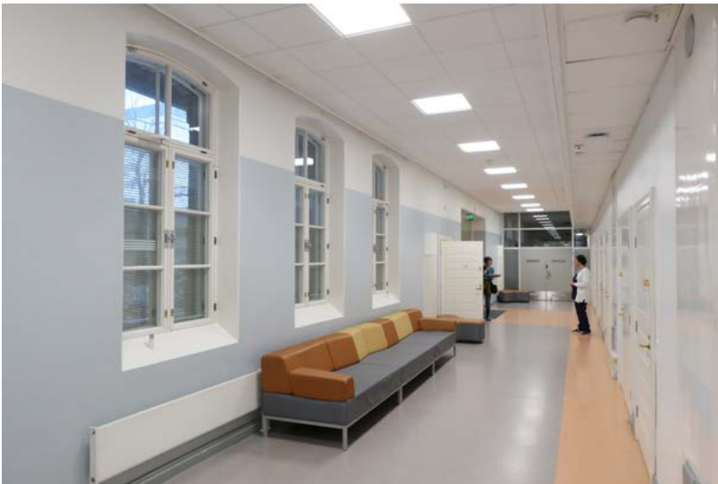
← Potilasosaston käytävän katkaiseva, kevytrakenteinen seinä on pystytetty vuoden 1994 muutostyössä. Vanhoja ikkunoita mukauttavat ikkunat ovat samasta korjausvaiheesta. amoy 2024
