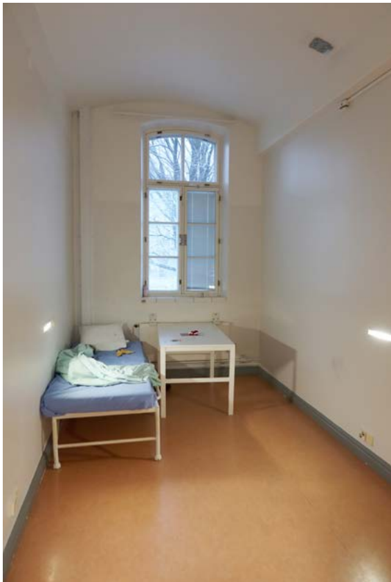
↑ Holvattu potilashuone, jonka ikkuna-aukkoa on 1990-luvulla jatkettu alaspäin. Tällaisissa suurenne- tuissa eteläjulkisivun ikkuna-aukoissa ikkunapenkki on suora ja laatoitettu. amoy 2024
