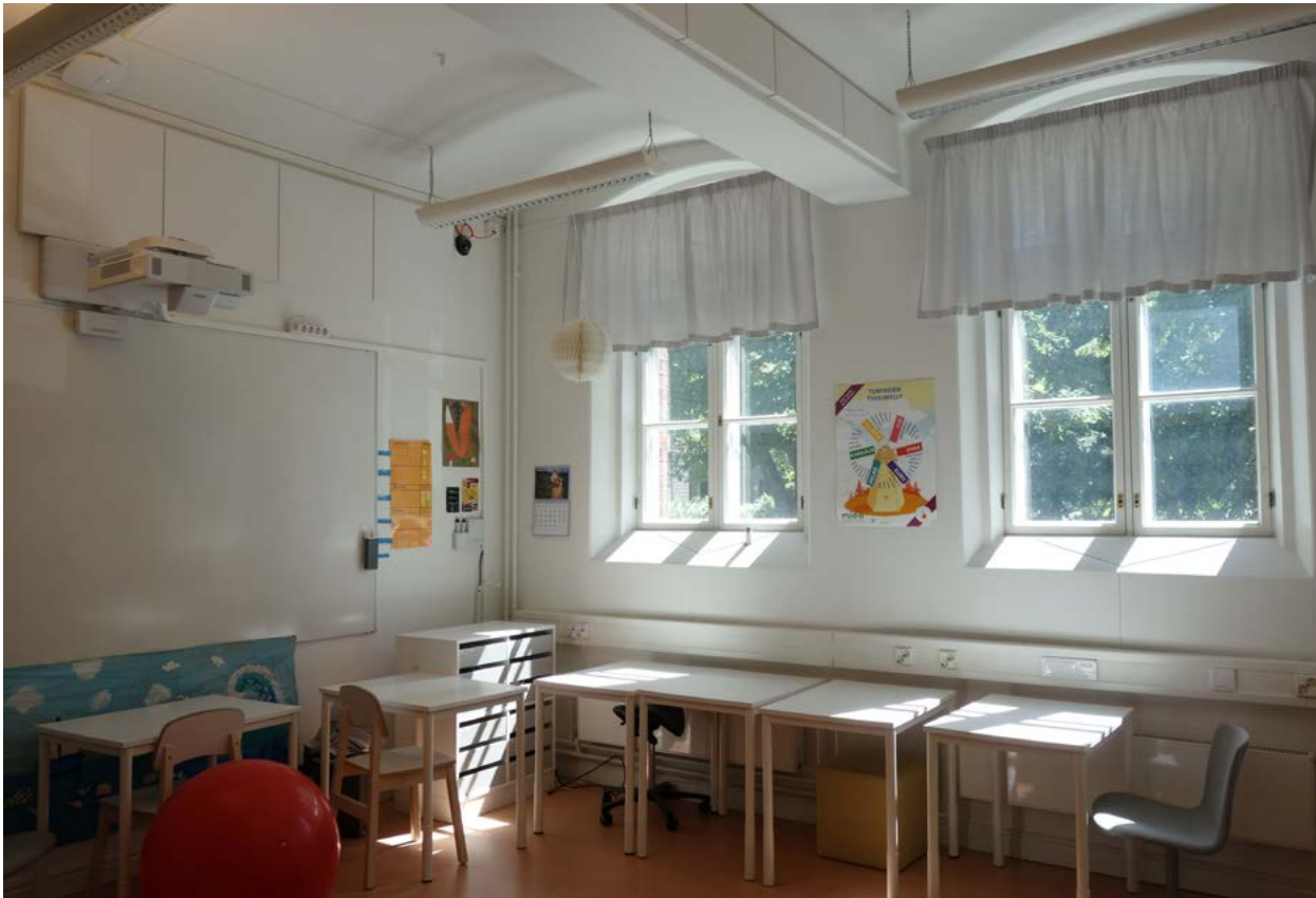
↑ Potilasosaston kaakkoisnurkassa eli risaliitin kohdalla on 1. kerroksessa nykyisin sairaalakoulun luokkahuone. Tilana se muodostui, kun 1990-luvun muutoksessa purettiin muurattu väliseinä kuvassa näkyvän palkin kohdalta. amoy 2024
