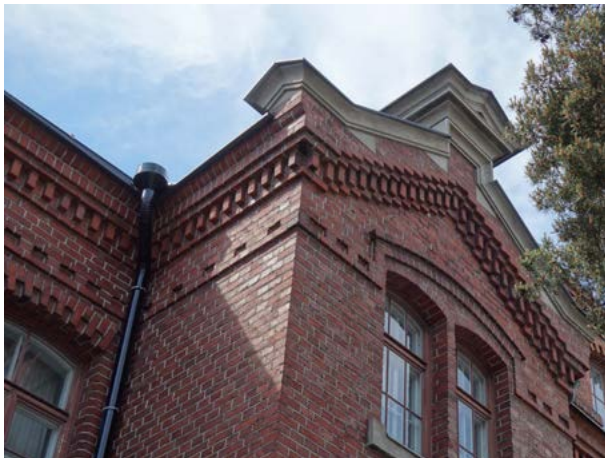
↑ Itäjulkisivun porrashuoneen pääty ja edicula. amoy 2024
