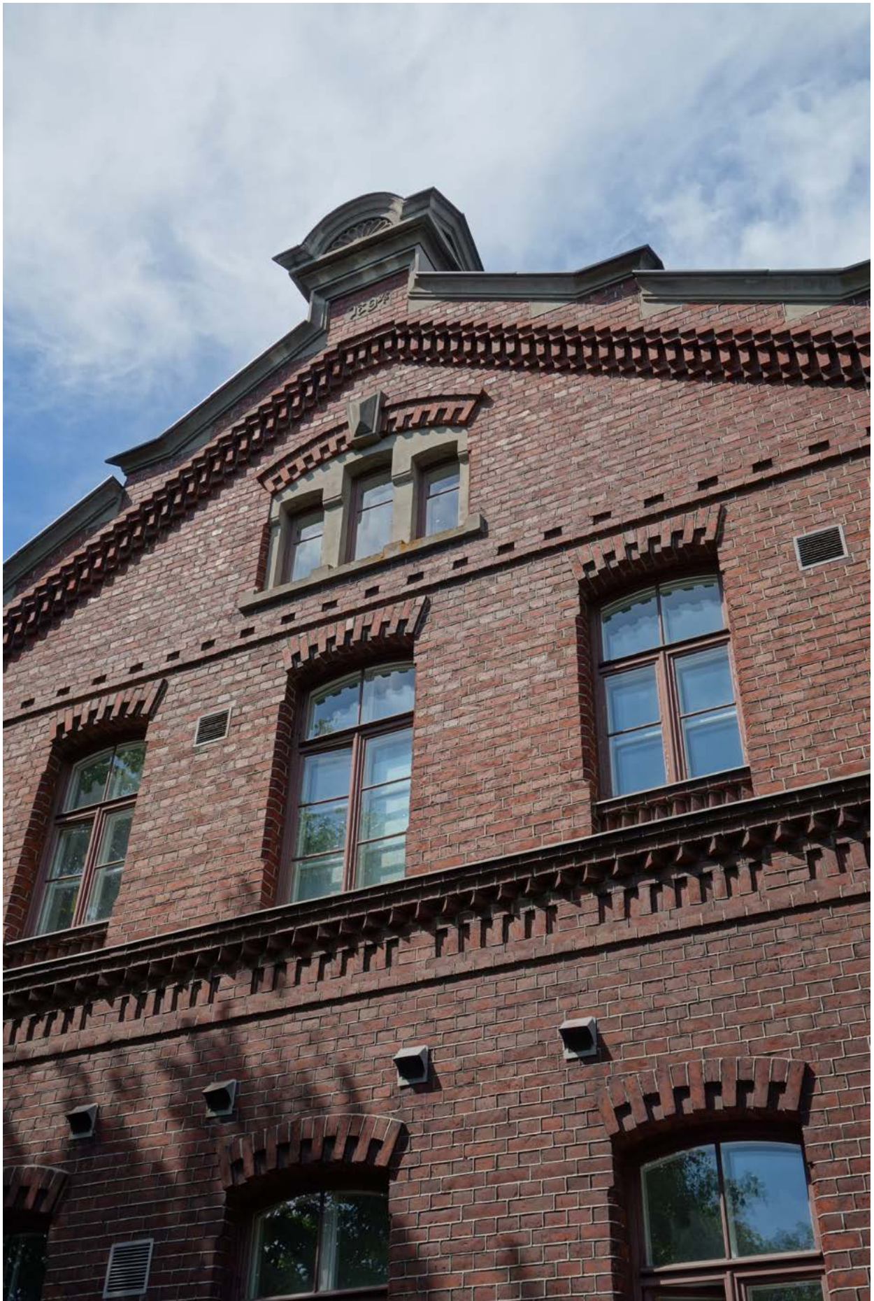
↑ Keskirisaliitin ullakon ikkunassa on kivinen kehys ja segmenttikaaren keskellä suuri holvikivi. amoy 2024
