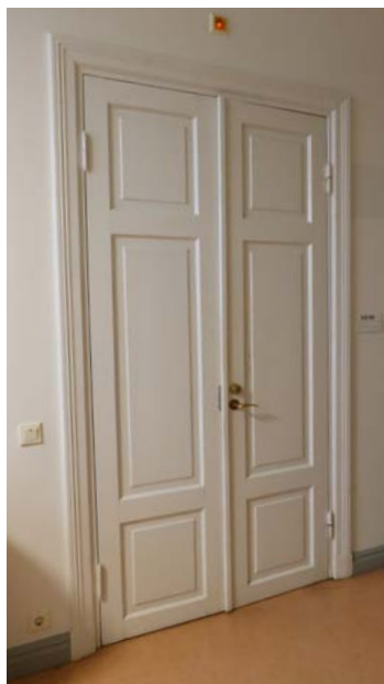
↑ ↗ Itä- ja länsisiiven keskikäytävän ovet ovat malliltaan vanhoja peiliovia, joita on kahta päätyyppiä. Yksilehtisissä ovissa on ylhäällä ja alhaalla vaakapeili, keskellä kaksi korkeaa pystypeiliä. Kaksilehtisissä eli parioivissa on kummassakin ovilehdessä neliömäiset ylä- ja alapeili ja yksi korkea pystypeili. Ainakin osa ovista näyttää olevan vanhoja, mahdollisesti 1920-luvulta. Osassa on uudet, vanhoja mukailevat karmilistoitukset. Oikealla länsisiiven 1. kerroksen keskikäytävää ja sosiaalitalan pariovi. amoy 2024
