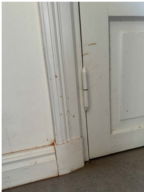
↑ Ullakkokerroksen profiloitua jalkalistaa ja ovenkarmia, jotka lienevät aikaisintaan 1920-luvulta. amoy 2024
