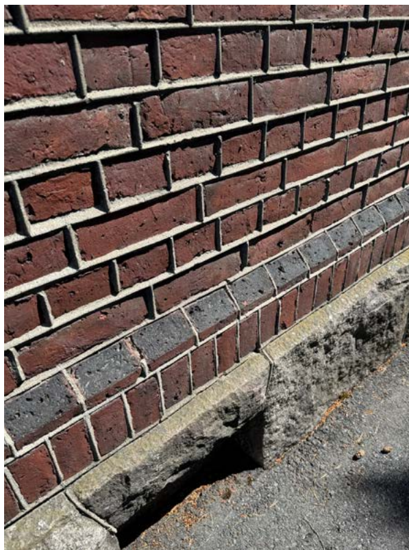
↑ Kellarin harmaakivimuuria ja punatiilimuuria, joka on saumattu "makkarasaumoin". amoy 2024
