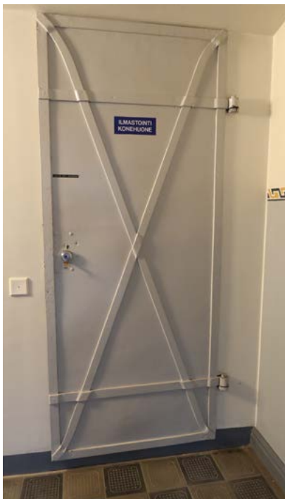
↑ Länsisiiven ullakolle johtava teräsovi taidokkaasti toteutettuine x-vahvikkeineen. amoy 2024
