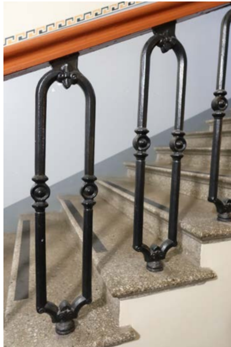
↑ Portaikon valurautakaide kauniisti kaartuvine puisine käsijohteineen on alkuperäinen vuoden 1894 detalji. amoy 2024
