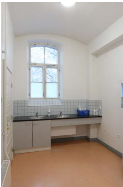
↑ Potilasosaston keskellä oleva käsi- pesutila, jonka ikkunapenkki on edel- leen viistetty ja laatoitettu. Vanha hol- vimuoto on näkyvissä, samoin oikeal- la seinässä kohta, johon 1990-luvulla palautettiin väliseinä. amoy 2024
