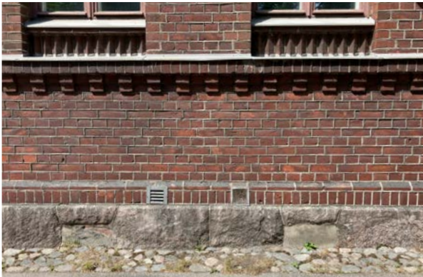
↑ Umpeen pantuja kellarin ikkunoita. Ensimmäisen kerroksen ikkunoiden alla näkyy koristeellisesti muurattu kenttä, jonka välityksellä ikkuna liittyy jakolistaan. amoy 2024
