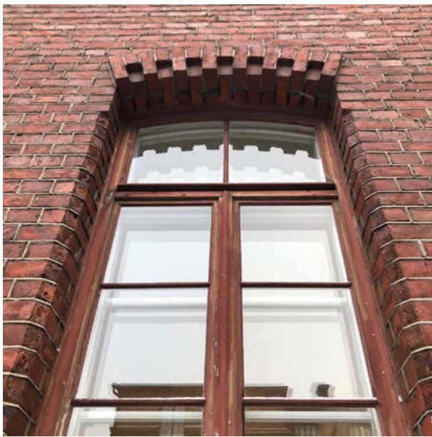
↑ Tiiliseinän käsittelyä alkuperäisen ikkuna-aukon ympärillä. Ikkuna on 1990-luvulta. amoy 2024
