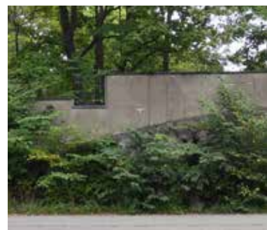
Ragnar Ypyän suunnittelema muuri vuodelta 1961. Muuri on vanerimuotettiin valettu, raudoitettu, maastoon porrastuksin sijoittuva betonimuuri. Kulttuurihistoriallisesti, maisemallisesti ja katukuvallisesti arvokas mutta huonokuntainen.
