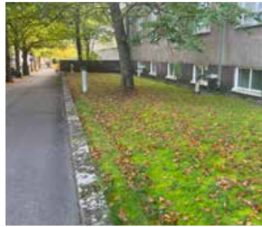
Gunnar Taucherin suunnittelema muuri vuodelta 1932. Paasikivitukimuuri. Kulttuurihistoriallisesti merkittävä muuri osana rakennuksen sokkelin kokonaisuutta.
