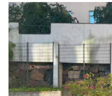
2011 jälkeen uudistettu muuri. Uudistettu Ragnar Ypyän v. 1955 suunnitteleman muurin mukaan. Paikalla valettu raudoitettu pinnoittamaton betonimuuri. Kulttuurihistoriallisesti, maisemallisesti ja katukuvallisesti arvokas. Huom. muuria ei ole uusittu tornitalojen tontin ulkopuolella.
