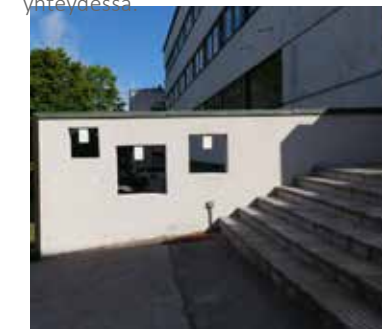
Suunnittelija Ragnar Ypyä, toteutettu n. vuonna 1960. Raudoitettu, vanerimuotittiin valettu tasakorkuinen betonimuuri, valupinnassa näkyy muotikuvio. Osa on kunnostettu Hesperian sairaalan peruskorjauksen yhteydessä ja pinnoitettu valkoiseksi. Muurit ovat osa rakennuksen kokonaisuutta, kulttuurihistoriallisesti, maisemallisesti ja katukuvallisesti merkittäviä.
