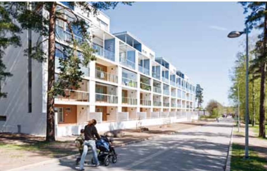
→ Myllypuron länsireunan uudempaa rakentamista Hallainvuorentiellä. Kuva Simo Karisalo.
