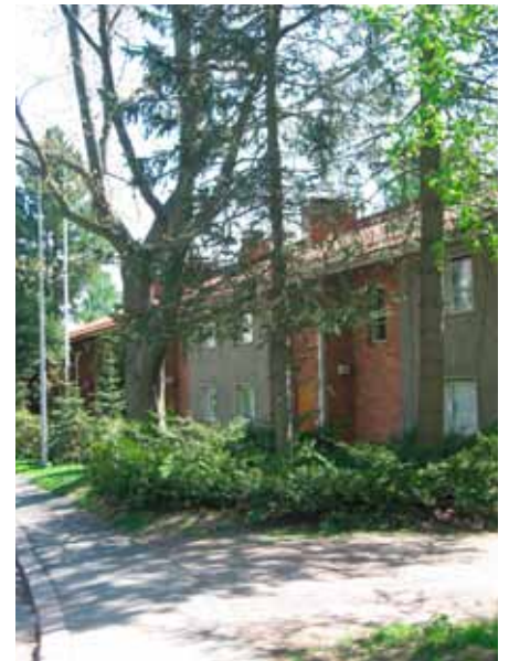
30. As Oy Ohjaajantie 30:n etupiha.
