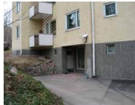
As Oy Pohjois-Haagan Pistetalot I:ssä on sokkeleissa käytetty uritettua mosaikkibetonia.
