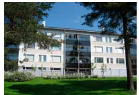
12. As Oy Näyttelijäntie 24:n parvekkeitaiteet on uusittu.
