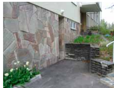
Akateeminen As Oy Ohjaajantie 22-24. Sokkelit on julkisivukorjauksen yhteydessä päällystetty liuskekivillä, joiden väri on Pohjois-Haagalle epätypillinen.
