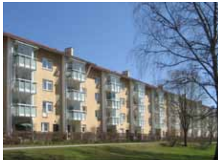
Pohjois-Haagan Kiinteistöt Oy / Ohjaajantie 11, uusitut parvekkeet.
