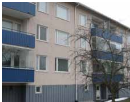
As Oy Näyttelijäntie 20. Maalattut, pystyuritettut sokkelit, rapatut massiivitiilijulkisivut, valkoiset parvekeovet ja puuikkunat tuuletusikkunoineen sekä ulokeparvekkeet profiilipeltikaiteineen ovat Pohjois-Haagalle tyypillisiä.
