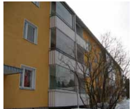
As Oy Aiton osittain sisäänvedetyt parvekkeet. Kaikki osakkaat eivät ole halunneet parvekelasitusta.
