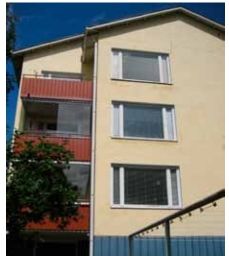
Näyttelijäntien lamellitaloissa ylimmän kerroksen parvekkeita ei ole lasitettu eikä katettu. Katoksen rakentaminen olisi vaikuttanut rakennuksen arkkitehtoniseen ilmeeseen voimakkaasti.
