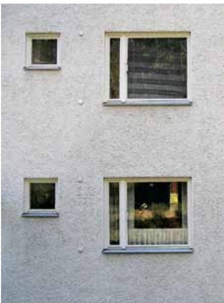
As Oy Poutamäentie 11:n säilyneet 1950-luvulle tyypilliset puuikkunat.
