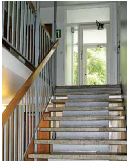
As Oy Pajamäen valoisa porrashuone, josta on käynti tuuletusparvekkeelle.
