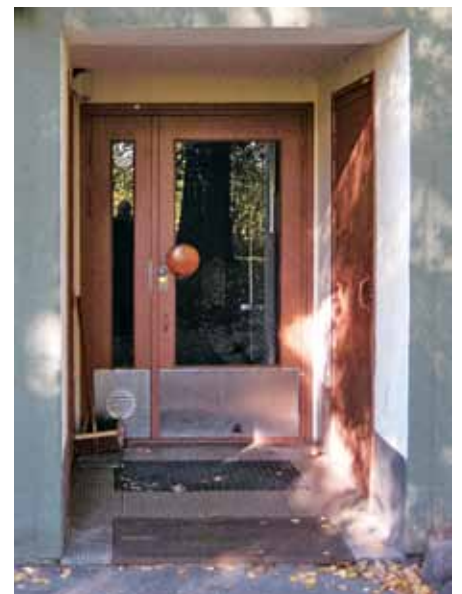
As Oy Poutamäentie 6, peittomaalattu lasiaukollinen ulko-ovi ja kellarin pystypaneloitu ovi.
