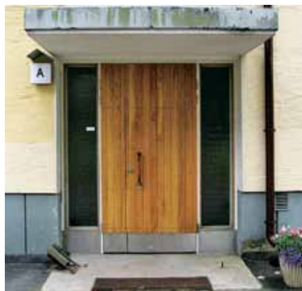
Ylimpänä As Oy Pajamäentie 11:n, keskellä As Oy Pajamäentie 7:n ja alimpana As Oy Poutamäentie 5:n alkuperäisinä säilyneet ulko-ovet.
