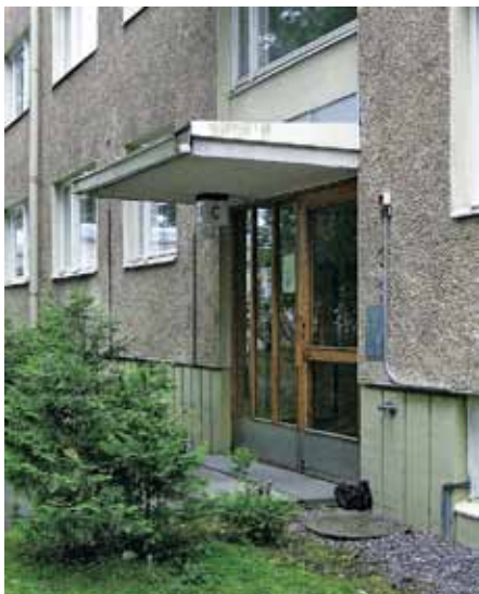
As Oy Pajamäentie 14:n sisäänkäyntikatokas on eleetön ulokelippa.
