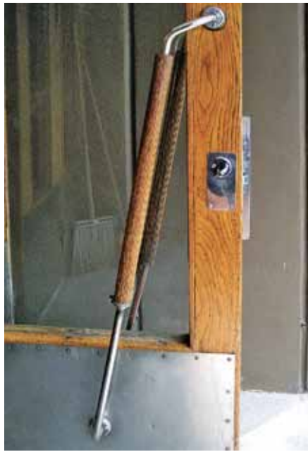
Vasemmalla As Oy Poutamäentie 15:n alkuperäinen vedin ja alla As Oy Pajamäen lasiaukollinen lakattu ovi ja puurunkoinen lasiseinä.
