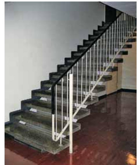
As Oy Poutamäentie 15:n tornitalon yksivartinen porras ja punaiset vinyyllilaatat väljän ala-aulan lattiassa.
