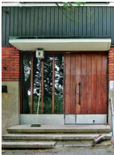
As Oy Poutamäentie 4, lakattu pystypaneloitu umpiovi ja puurunkoinen lasiseinä.
