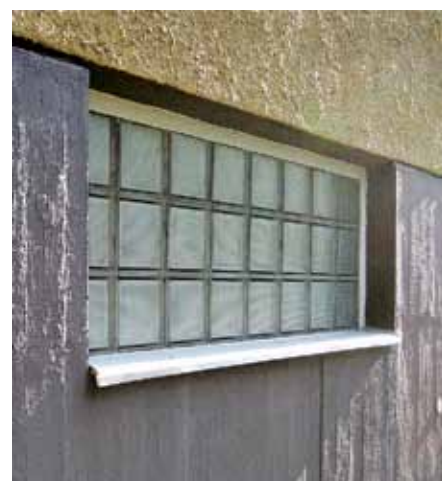
As Oy Pajamäentie 11:n betonisokkelissa on nähtävillä pystylautoitetun valumuotun kuvio. Kellarin ikkunat ovat poikkeuksellisesti lasitiiltä.
