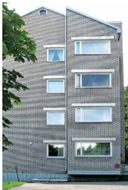
Vasemmalla As Oy Poutamäentie 4:n puhtaaksi muurattua punatiilijulkisivua, oikealla As Oy Poutamäentie 3:n puhtaaksi muurattu kalkkihiiekkatiilipääty.
