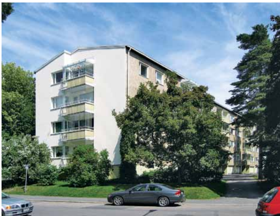
13. As Oy Pajamäentie 14. Rakennukset päädyt on eristerapattu, rappauspinta on sileä ja vaalea. Yimmän kerroksen parvekkeille on rakennettu katokset.
