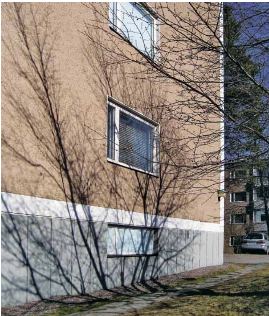
As Oy Pajamäentie 11:n betonisokkelissa on nähtävillä pystylautoitetun valumuotun kuvio. Kellarin ikkunat ovat poikkeuksellisesti lasitiiltä.
