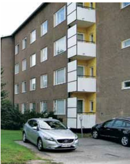
15. As Oy Helsingin Pajamäentie 6 / Sato. Alla puretun piipun tilalle rakennetut alkuperäisestä arkkitehtuurista poikkeavat suojaseinäkkeet.
