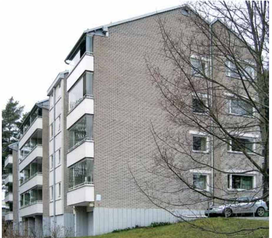
17. As Oy Poutamäentie 3:n päädyt ovat puhtaaksi muurattua kalkkiahkatiiltä ja lounaissivun massiivitiiliseinät on alueelle poikkeuksellisesti päällystetty osittain sileillä ja osittain profiloituilla asbestisementtilevyillä.
