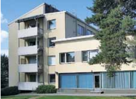
14. As Oy Poutamäentie 7:n pätyyn rakennetut uudet parvekkeet ja liikesiipi C.
