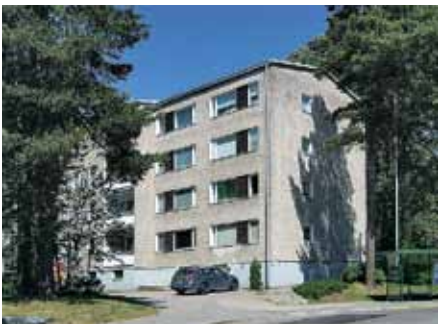
5. As Oy Pajamäentie 9, alkuperäisiä julkisivuja, joissa on karkea roiskerappaus.
