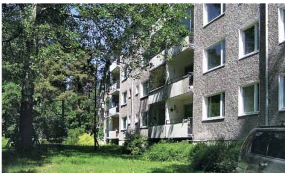
11. As Oy Poutamäentie 14, alkuperäisenä säilynyttä elävää roiskerappauspintaa.
