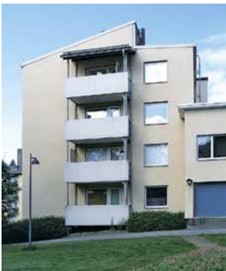
As Oy Helsingin Poutamäentie 14:n päätyyn rakennetut kokonaan uudet parvekkeet.
