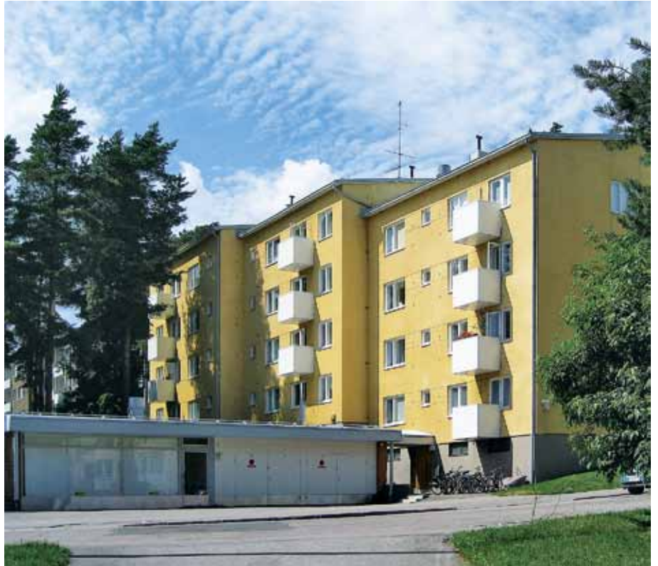
16. Pajamäentie 4 / Keskinäinen eläkevakuutusyhtiö Varma. Etualalla liikesiipi G. Parvekkeet on uusittu vanhan mallisina, eikä niitä ole lasitettu.
