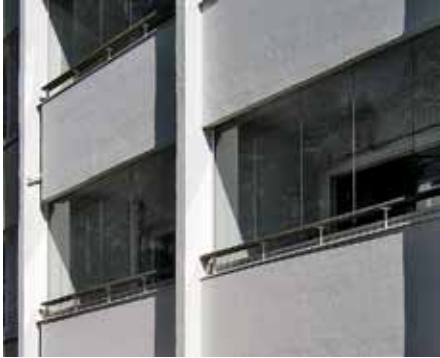
As Oy Pajamäentie 7:n betonikaiteet.
