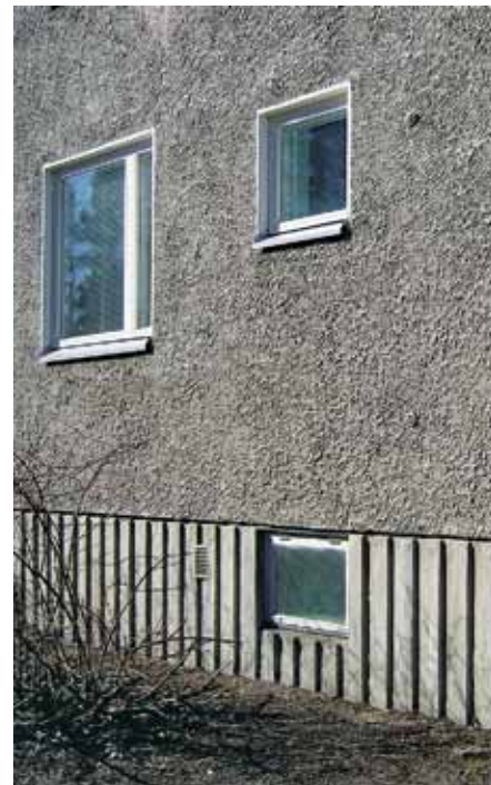
As Oy Poutamäentie 14:n betonisokkelissa on paikalla-valettu pystysuuntainen kokokuvaio.
