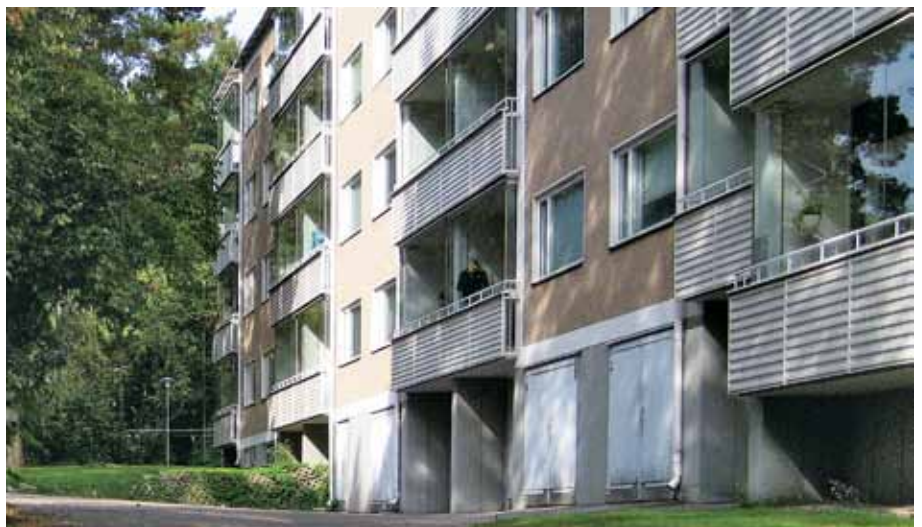
As Oy Pajamäentie 5, betonikaiteet on muutettu profiilipeltikaiteiksi.
