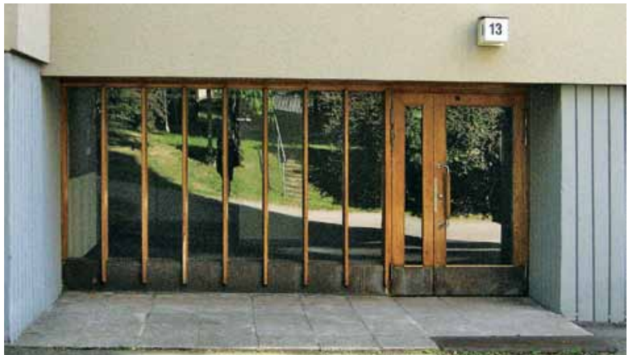
As Oy Poutamäentie 4, lakattu pystypaneloitu umpiovi ja puurunkoinen lasiseinä.
