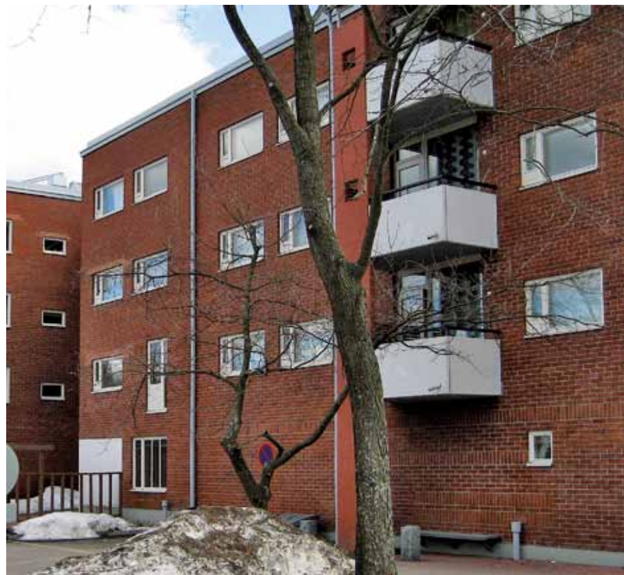
Koy Kartanonkaaren ikkunat ovat tyypillisiä 1980-luvun pienehköjä ikkunoita tuuletusluukkuineen.
