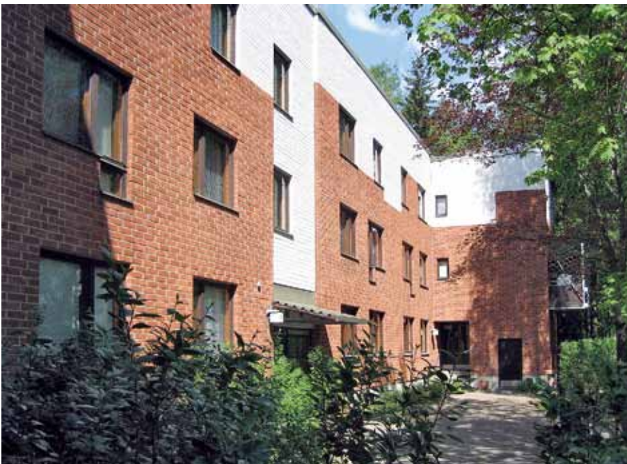
Alla As Oy Puustellinpolku 7:n pihasisvua, joka on paikalla muurattua punaista ja vaaleaa tiiltä.
