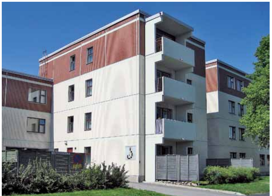
Alla Koy Pehtoorintie 2, jossa julkisivuissa on käytetty klinkkerilaattaa ja värisävyt ovat päinvastoin; yläosa on punaista ja alaosaa vaaleaa laattaa.
