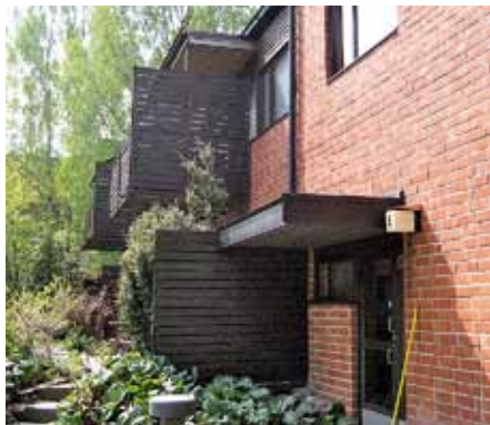
As Oy Arentikuja 4:n tyypillinen pellitetty ulokelippa.
