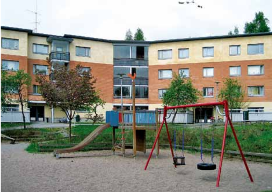
Yllä Koy Arentitie 8, jonka julkisivut on kokonaan uusittu kaikkine rakennusosineen ja julkisivujen ilme on muutunut täysin.
