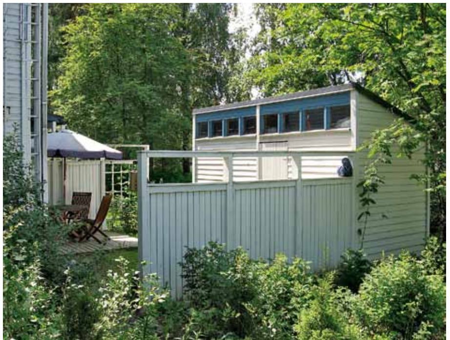
Alla As Oy Toiskantien pihaa.
