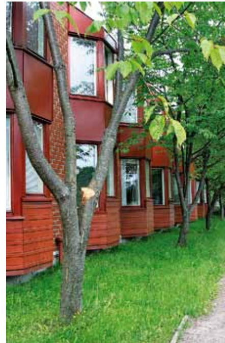
Joissakin taloyhtiöissä puuta on alun perin istutettu liian lähelle rakennuksia. Puuta ei tulisi istuttaa kolme metriä lähemmäs seinää, lajista ja kasvutavasta riippuen etäisyys voisi mielellään olla vieläkin suurempi. Rakennuksen routa- ja kosteusvaikutukset tulevat huomioida myös muita istutuksia tehtäessä.
