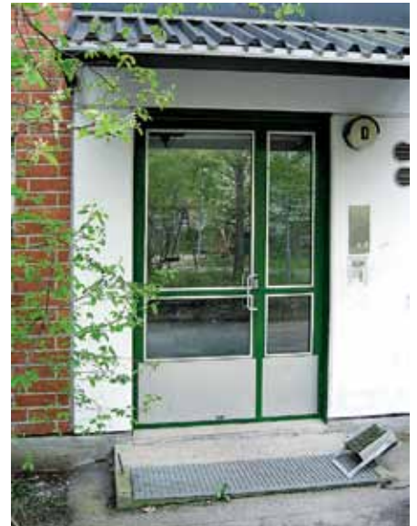
As Oy Kruununpuustelli, porrashuoneen teräsprofiili-ulkovi.
