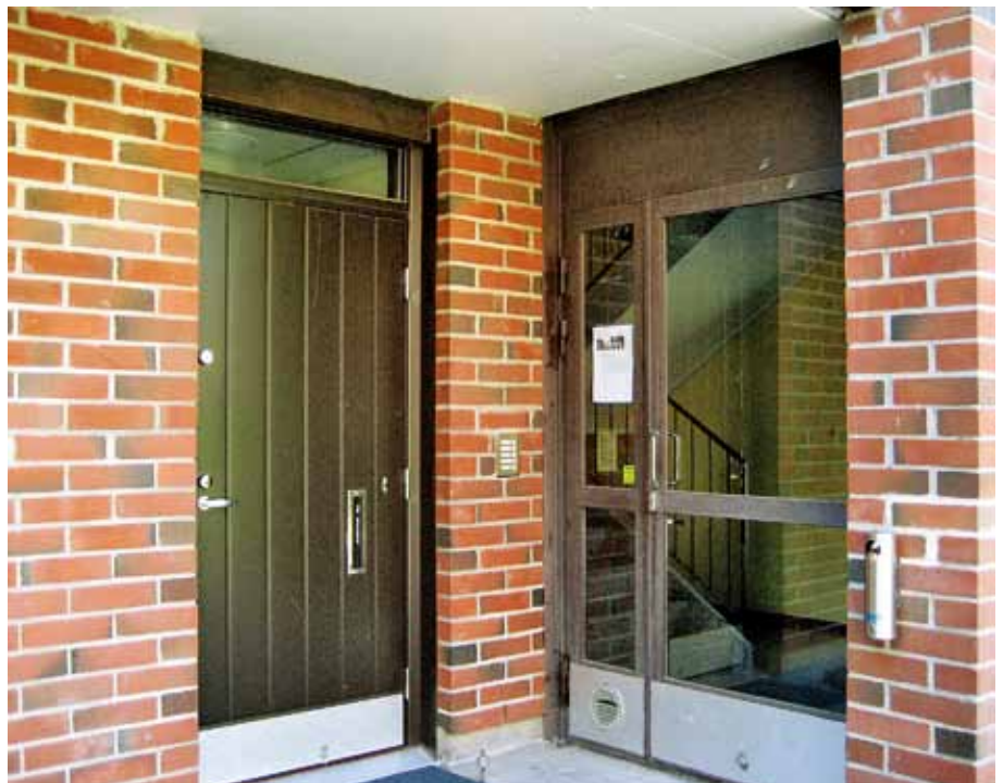
Koy Rautakartanon uusi HDF-pintainen ulko-ovi sekä alkuperäinen teräsprofiiliovi.
