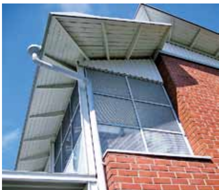
As Oy Pienkartanon kattoa uusittaessa on rakennettu myös näyttävät räystäät, jotka eivät kuulu alkuperäiseen arkkitehtuuriin.
