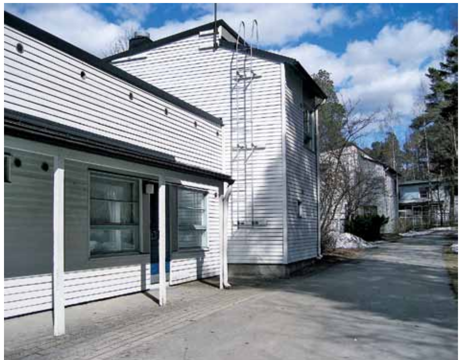
As Oy Toiskantien puuverhoiltuja julkisivuja. Pitkien sivujen rakenne on kevyt puurankainen ulkoseinä, päädysissä kantavana rakenteena on betoni.
