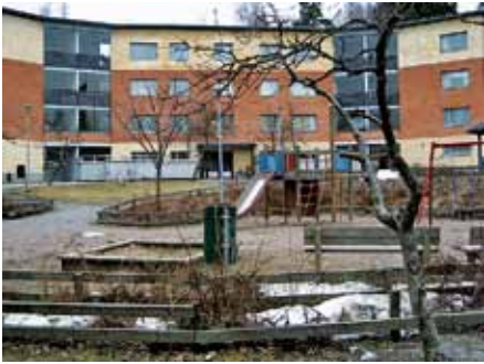
Painekyllästetystä puusta tehdyt suoja-aidat on yleensä tarkoitettu väliaikaisiksi, mutta ne jäävät varsin usein poistamatta. Niiden pihaa rumentava vaikutus on merkittävä. Istutusten suojaamisen tarve tulee tarkasti harkita. Jos tarve jatkuvaan suojaamiseen on olemassa, tulee suoja-aidat suunnitella huolellisesti pysyväksi ja kauniiksi osaksi pihatilaa. Suojausten tulisi olla luonteeltaan ilmavia ja huomaamattomia.
