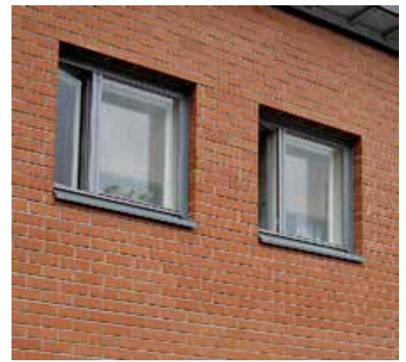
Koy Arentitien uusitut ikkunat.
