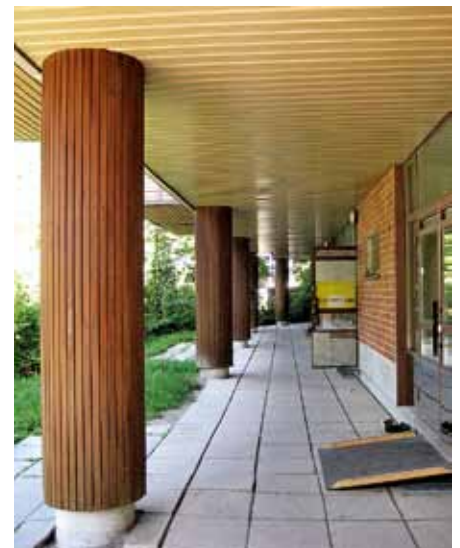
As Oy Puustellinaukion arkadikäytävän pilarit on päällystetty puulla. Ulko-oven kohdalle on maanpinnan painumisen vuoksi syntyneen korkeuseron vuoksi asennettu tilapäiseltä näyttävä luiska.
