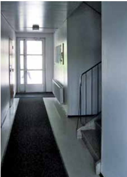
As Oy Renginkujan tyypillinen tiukasti mitoitettu porrashuone.
