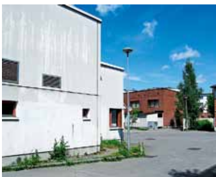
Vaikeasti hoidettavilla kapeilla kaistoilla rakennusten ja katualueen välissä olisi perusteltua käyttää istutusten sijasta esimerkiksi kiveä. Jos tilaa on riittävästi, tulisi istutukset toteuttaa ja hoitaa niin, että niillä on menestymisen mahdollisuudet. Toiskantien lähiympäristön suunnitteluohjeessa vastaavat kapeat alueet on esitetty kivettäväksi mukulakivin.
