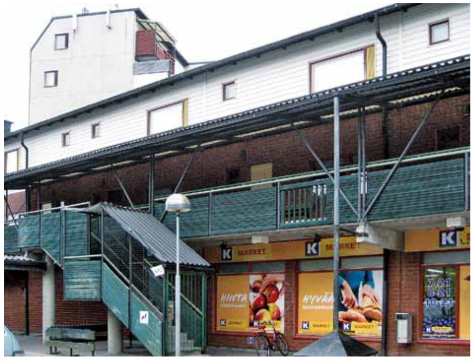
As Oy Hopeakartanon luhtikäytäväalojen ylimmän kerroksen kadun puoleinen julkisivu on verhoiltu valkoisella, vaakasuuntaisella profiilipeltillä ja terrassitalon ylimpien kerrosten julkisivut radan puolella pystysuuntaisella profiilipeltillä.
