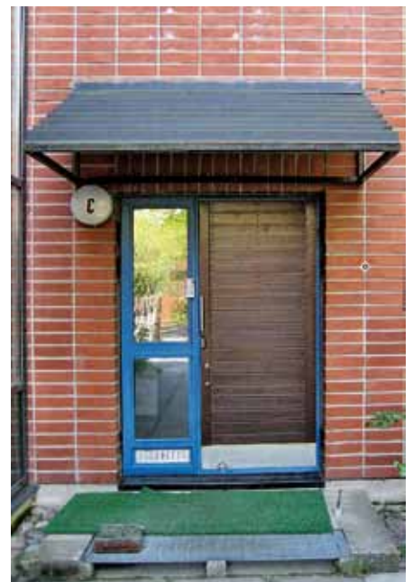
Alla As Oy Tallinmäen teräsprofiili-ikkuna ja paneloitu ulko-ovi.
