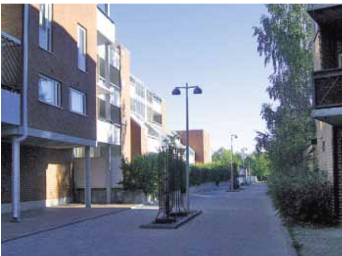
Tollinpolun katukiveys, valaisimet ja istutusalueet uusittiin syksyllä 2010.
