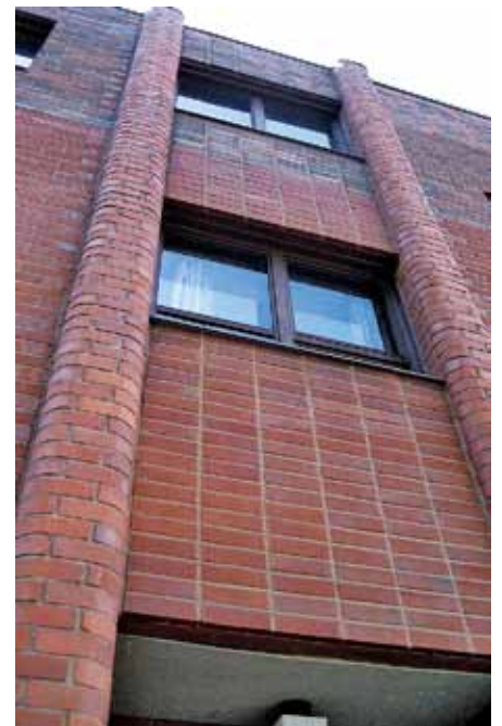
As Oy Vellikellontie 3:n paikalla muuratuissa julkisivuissa on käytetty myös muototiiliä
