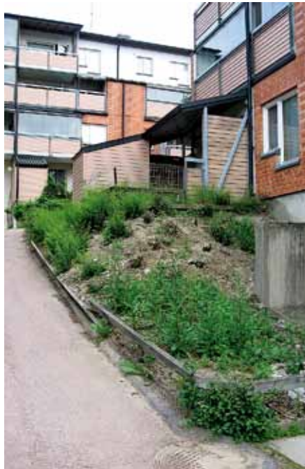
Rikkoutuneet rakenteet, rikkaruohot ja sotkuisuus vähentävät merkittävästi asumisen miellyttävyyttä ja sitä kautta asukkaiden hyvinvointia. Kuvan kaltainen tilanne myös lisää ilkeämielisyyttä. Tilanne tulisikin välittömästi korjata.
