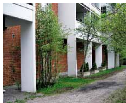
Pihan kunnostuksen yhteydessä tulee väärin paikkoihin istutetut puut jättää uusimatta. Seinän vierustojen istutukset tulee kokonaisuutena suunnitella ja uusia siten, ettei rakennukselle aiheuteta haittaa.
