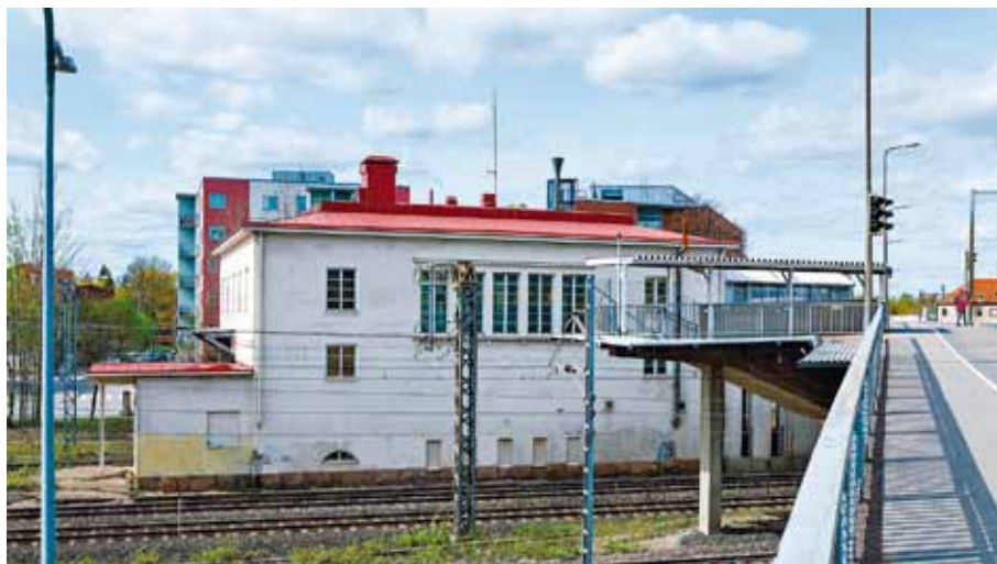
Malmin vanha asemarakennus. Kuva: Simo Karisalo
