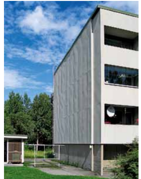
Riihipellontie 3:n ikkunat on uusittu. Levyjen vaakasaumoissa on tippalistat. Alkuperäiset autotallien ovet ja ulko-ovet ovat säilyneet.
