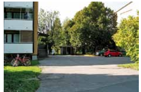
Paikoitukseen osoitettu tila on hyvin monessa yhtiössä lähtökohtaisesti tarpeettoman laaja. Koko alueen asfaltointi on lisännyt hulevesien pintavirtausta pihoilla ja antanut pihojen sisääntuloille karun leiman. Kuva Käärtipolku 8:sta.
