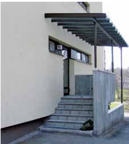
Lasikatteen katos. Seinän viereltä on poistettu alkuperäinen kaide. Porras ja tukimuurri on uusittu, samoin alkuperäisen teräsprofiilioven vedin.
