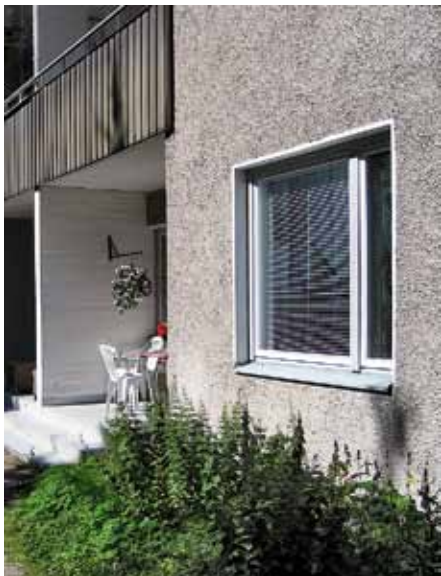
As Oy Konalanrinne 1–2:n säilynyt puuikkuna. Aittatiellä ikkunat ovat 1950-luvulle tyypillisiä, maltillisen kokoisia ja tuuletusikkunallisia.
