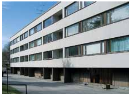
Riihipellontie 3:n ikkunat on uusittu. Levyjen vaakasaumoissa on tippalistat. Alkuperäiset autotallien ovet ja ulko-ovet ovat säilyneet.
