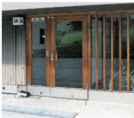
As Oy Riihipellontie 3:n ulko-ovet ja puulasiseinät ovat säilyneet alkuperäisinä.
