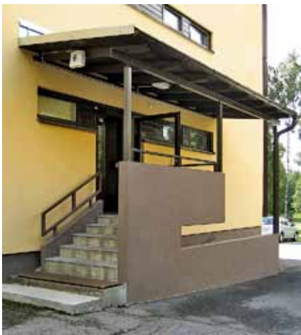
Vuonna 2008 rakennettu sisäänkäyntikatos. Väriksi on valittu ruskea. Valaisimet on uusittu alkuperäiseen arkkitehtuuriin sopiviksi.
