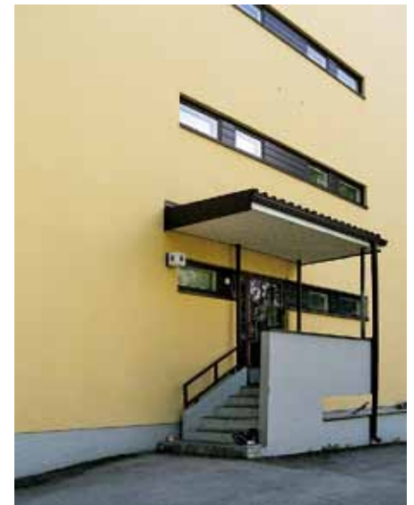
As Oy Riihipellontie 8:n sileää rappauspintaa.
