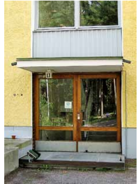
Alkuperäinen tammi-lasiovi ja puuikkunat ovat säilyneet. Porrashuoneen ikkunoiden väliset profiilipellit on uusittu.
