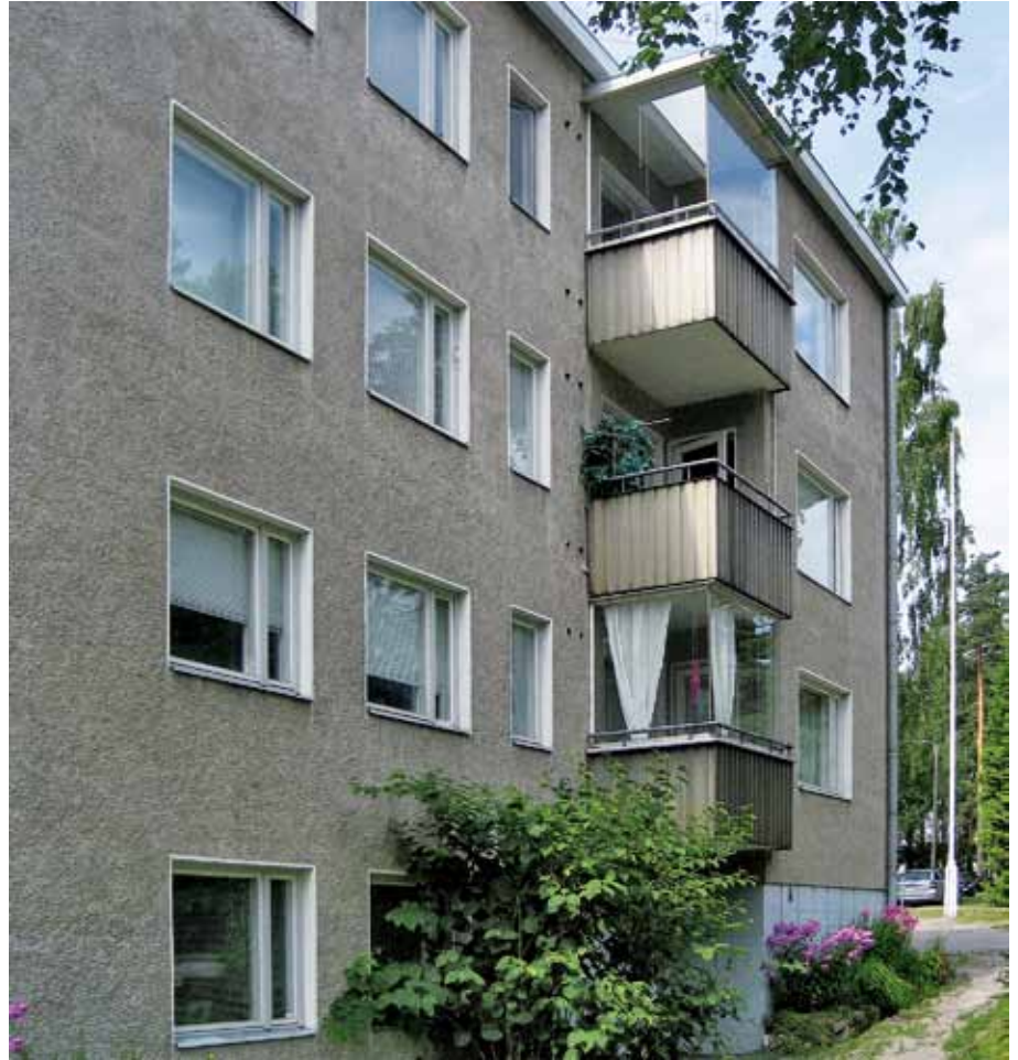
As Oy Käärtipolku 6:n parvekkeet on uusittu vanhan mallin mukaisina. Etukaiteet ovat betonielementtejä ja parvekeksivujen puuritolat on uusittu entisenlaisina.
