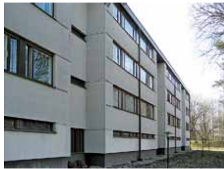
Riihipellontie 3:n ikkunat on uusittu. Levyjen vaakasaumoissa on tippalistat. Alkuperäiset autotallien ovet ja ulko-ovet ovat säilyneet.
