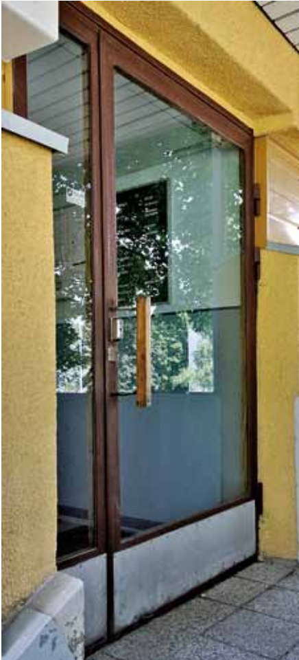
As Oy Konalanvuoren osoitteessa Riihipellontie 6 teräsprofiilivoi on säilynyt vetimiseen alkuperäisenä. Ovi on nykyisiä alumiiniprofiiliovina huomattavasti sirompi.
