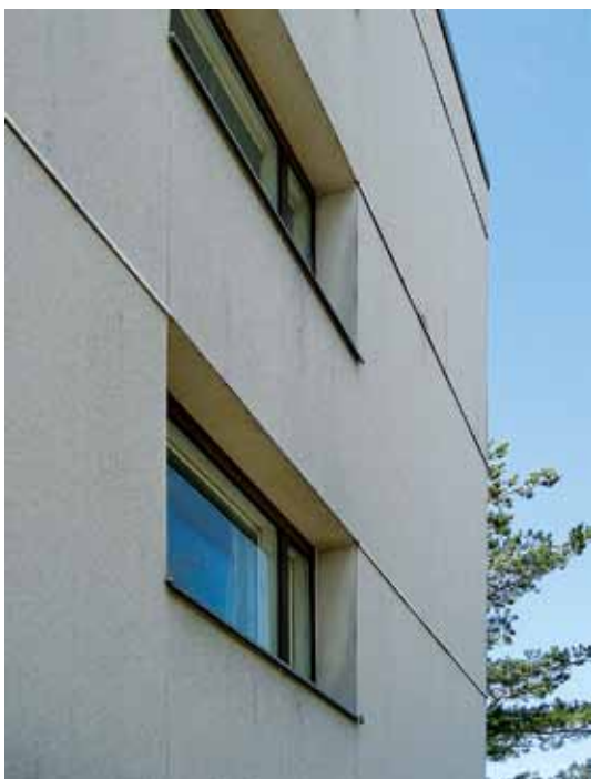
Vasemmalla As Oy Riihipellontie 3:n Ija oikealla As Oy Riihipellontie 5:n levyverhoiltua julkisivupintaa. Riihipellontie 3:n päädyssä listoitettujen vaakasaumojen korostuvat ja ikkunat ovat epäonnistuneen sovituksen vuoksi jääneet kuoppiin. Riihipellontie 5:n puurankaan kiinnitettyjen levyjen kiinnityskohdat ovat tulleet näkyviin ja pääty näyttää epätasaiselta.
