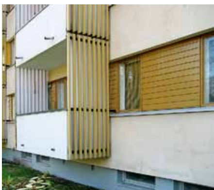
As Oy Käärtipolku 10:n keltaiset puualumiini-ikkunat ja profiilipelti.
