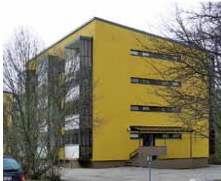
Rakennuksen päädyt on eristerapattu, mutta räystäät on tehty alkuperäisen mallisina eikä ulokeräystäinä.
