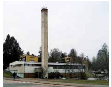
Julkisivu Konalantielle nykytilassaan.
