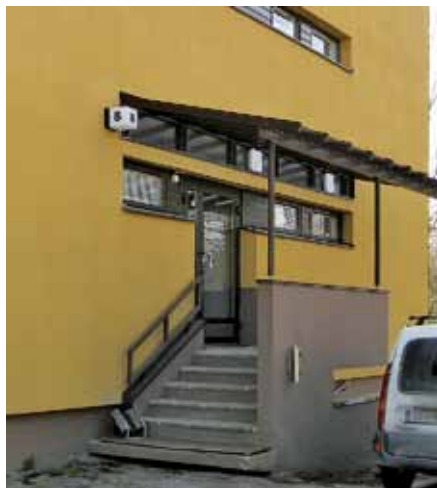
Alun perin luvatta rakennettu sisäänkäyntikatos. Väri on sama ruskea kuin naapuritalossa, mutta katemateriaalina on lasi.
