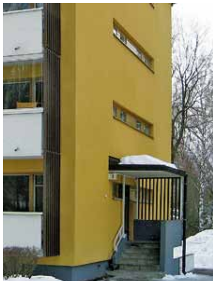
Vuonna 2000 rakennettuun sisäänkäyntikatokseen on lisätty ritiläseinä vuonna 2004.
