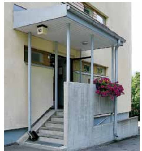
Vuonna 2002 julkisivukorjauksen yhteydessä rakennettu sisäänkäyntikatos moderneine valaisimineen. Seinän viereltä on poistettu alkuperäinen kaide. Katos on turhan massiivinen, eivätkä katos ja valaisimet sovi rakennuksen alkuperäiseen arkkitehtuuriin.
