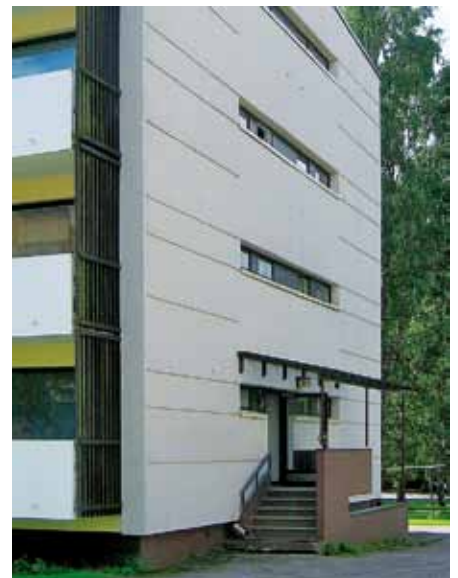
Uusi sisäänkäyntikatokseksi on lasikatteinen ja poikkeaa täysin naapuritalon katoksesta.
