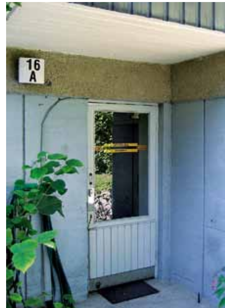
As Oy Konalanrinne 1–2:n ja 3:n kellaritilojen sekä maantasasuuntojen ulko-ovet ovat lasiaukollisia, alaosat on pystypaneloitu.
