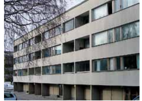
Riihipellontie 5:ssä on alkuperäiset puuilkkunat ja -ikkunaovet sekä ulko-ovet ja autotallien ovet. Päädyn levytyksen kiinnityskohdat ovat tulleet näkyviin.
