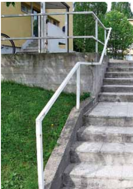
Paikalla rakennetut tukimuurit ja sirot metallikaiteet ovat säilyttämisen ja kunnostamisen arvoisia. Uudet muurit ja kaiteet tulisi suunnitella samalla periaatteella paikalle sovitusti. Kuva As Oy Konalanvuoren pihalta.
