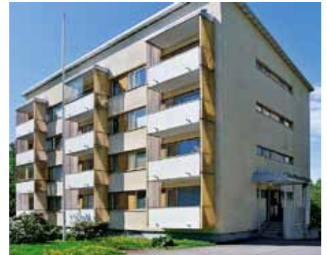
Julkisivukorjauksessa rakennuksen alkuperäinen väritys on muutettu alkuperäiselle vieraaksi.
