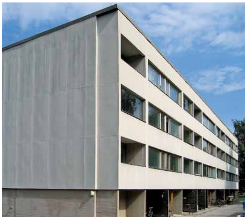
Vasemmalla As Oy Riihipellontie 3:n Ija oikealla As Oy Riihipellontie 5:n levyverhoiltua julkisivupintaa. Riihipellontie 3:n päädyssä listoitettujen vaakasaumojen korostuvat ja ikkunat ovat epäonnistuneen sovituksen vuoksi jääneet kuoppiin. Riihipellontie 5:n puurankaan kiinnitettyjen levyjen kiinnityskohdat ovat tulleet näkyviin ja pääty näyttää epätasaiselta.
