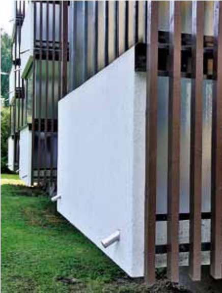
As Oy Käärtipolku 6:n parvekkeet on uusittu vanhan mallin mukaisina. Etukaiteet ovat betonielementtejä ja parvekeksivujen puuritolat on uusittu entisenlaisina.
