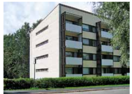
Levytetyn päädyn vaakasaumojen välissä on muovipinnoitetusta pellistä tehty tippalista.
