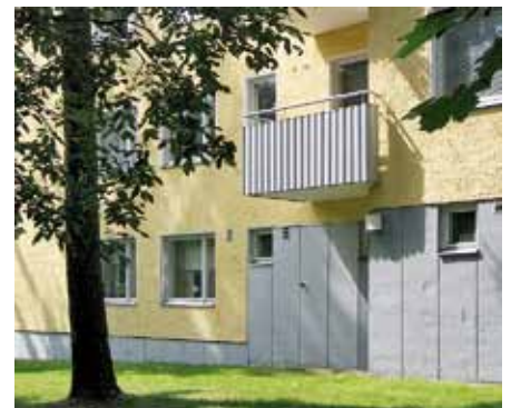
Aittatien asuintalon uritettua betonisokkeliä.
