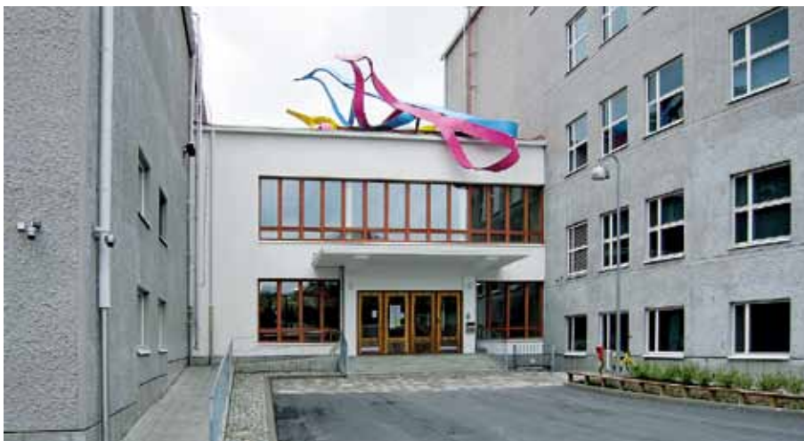
Käpylän peruskoulun energiatohokkaassa korjauksessa on onnistuttu säilyttämään alkuperäinen 1950-luvun arkitehtuuri. Kuva Pirjo Pekkarinen-Kanerva.
