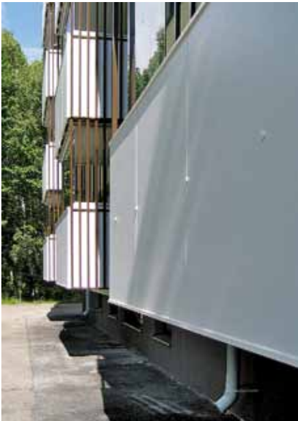
As Oy Käärtipolku 12:n parvekkeet on myös uusittu kokonaan. Koko on säilynyt, mutta etukaiteet on muutettu levyrakenteisiksi ja puuritoloiden sijaan on vaihdettu alumiiniputket. Parvekkeiden ilme on muuttunut alkuperäisestä.
