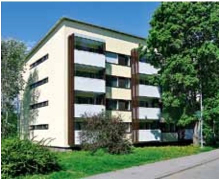
Parvekkeiden levytetty etuseinä ja puuritiilöiden vaihtu alumiiniputkiksi on muuttanut julkisivua. Tontti rajautuu katuun ilman aitaa.
