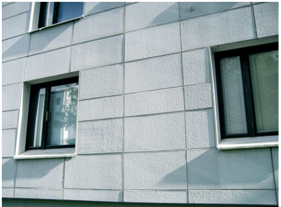
Fastighets Ab Babord. Ohutkuorielementtien asennus on epäonnistunut.
