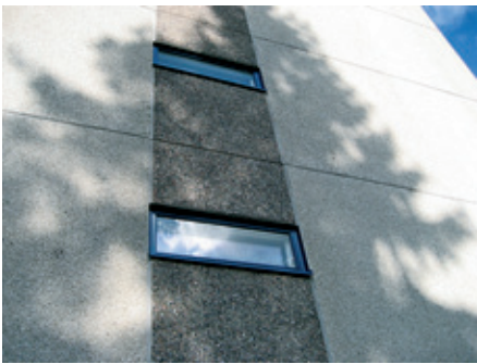
As Oy Merikorttitie 14, 1970-luvun alun pesubetonijulkisivua.
