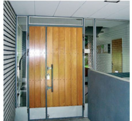
As Oy Säästökannas , ulko-ovi liittyy teräslasiseinään.
