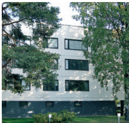
As Oy Säästöluodon sisäpihatalojen alkuperäisiä puuikkunoita.
