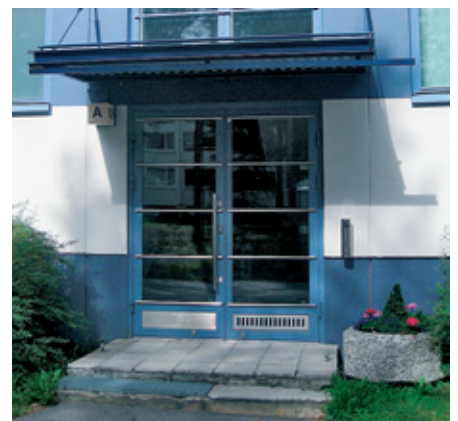
As Oy Kivisaarentien uusitut teräsprofiiliovet.
