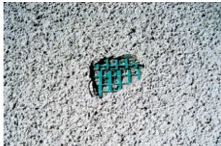
Ohutrappauksen tullutta vauriota on mahdotonta korjata huomaamattomasti.
