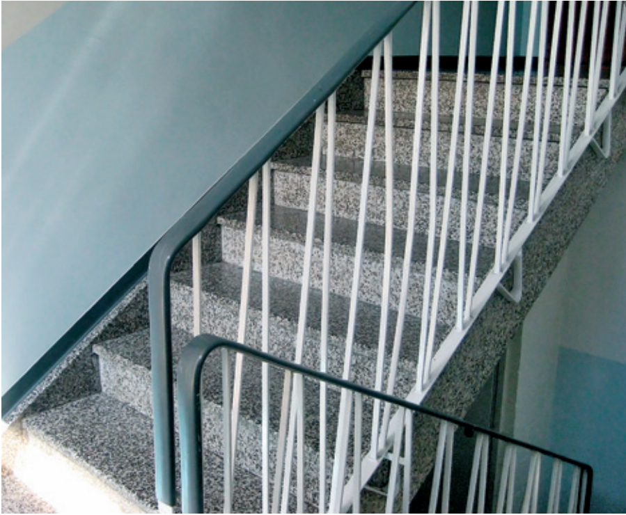
As Oy Helsingin Neitsytsaarentien alkuperäinen porraskaide. Yksinkertaisten porrashuoneiden tyylikkäästä yksityiskohdista ovat tärkeitä ja niitä tulisi vaalia. Mikäli kaitahissi sijoitettaisiin porrassyöksyjen väliin, katoaisivat kauniit alkuperäiset kaitteet.
