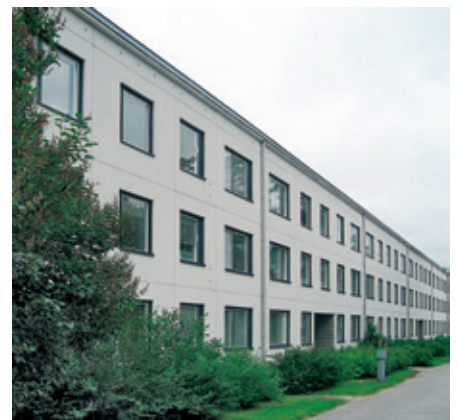
As Oy Säästökannaksen uudet puualumiini-ikkunat. Ikkunoiden ulkopinnan suhde julkisivupintaan on oikea, mutta ikkunajako on muuttunut.
