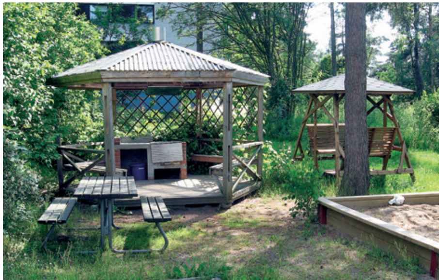
Valmisrakenteet tulisi vähintään maalata.
