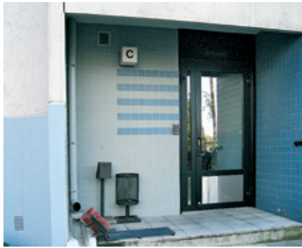
As Oy Vuosaaren Ulappa 8, sisäänkäyntisyvennys on päällystetty alkuperäiselle arkkitehtuurille vieraila pastellivärisillä laatoilla. Ulko-ovi on uusi vakioprofiiliovi.
