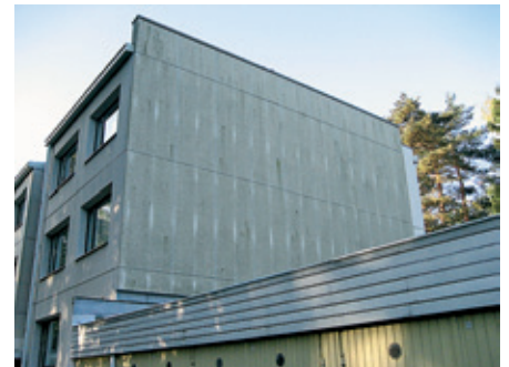
As Oy Säästöluodon alkuperäinen betonipääty ja As Oy Lokkisaarentien levytetty pääty.
