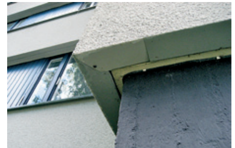
As Oy Säästöpurjeen pistetalojen päädyt on kolmikerrosrapattu. Kuvassa liittymä lisälämmöneristämättömään sokkeliin.
