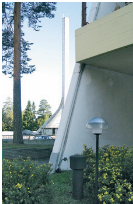
As Oy Säästöniemi. Terrassiparvekkeiden hallittu vedenpoisto on huomioitu jo alkuperäisissä suunnitelmissa.
