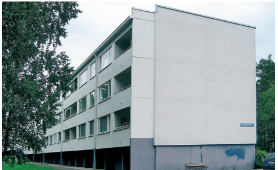
As Oy Kivisaarentie lamellien päädyt on ohutrappattu.
