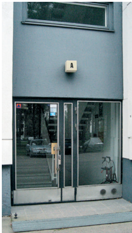
As Oy Säästöluodon alkuperäiset teräsprofiiliovet.
