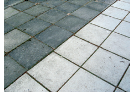
Paikkaamalla uusittu laatoitus. Vanhan ja uuden laatoituksen väriero on huomattava.
