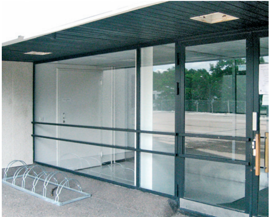
As Oy Säästömaston alkuperäiset teräslasiovet ja teräsprofiili-ikkunat.
