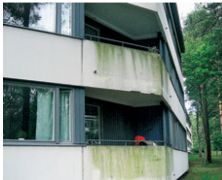
As Oy Säästöpurje. Valumaveden kirjavoittamat betonikaiteet. Parvekkeiden muoto tekee vedenpoiston hallinnasta haasteellisen.
