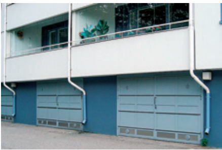
As Oy Kivisaarentien uudet autotallien ulko-ovet.
