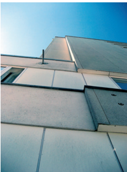
As Oy Ulappasaarentie 10, lämpörapatun siporex-päädyn liittyminen matalan liikesiiven lämpörappaamattomaan julkisivuun. Liittymien suunnittelu on tärkeää hallitun kokonaisuuden synnyttämiseksi.
