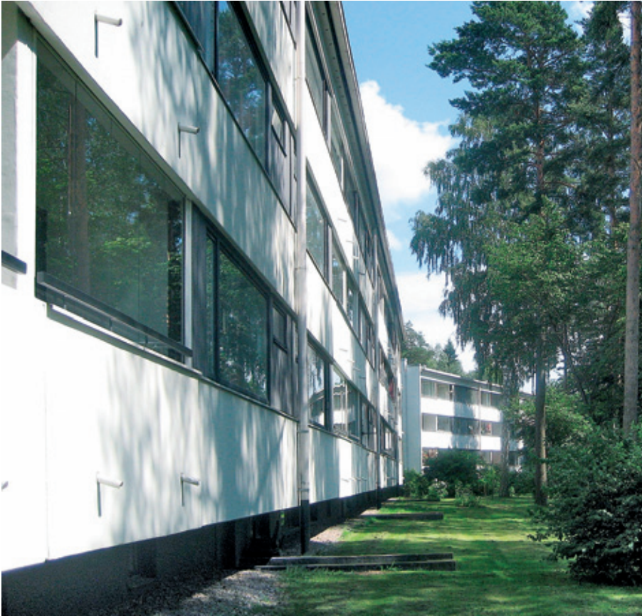
As Oy Säästöluodon julkisivut on korjattu säilyttävällä tavalla.
