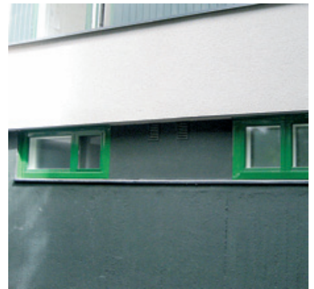
As Oy Säästöpurjeen uusia puualumiini-ikkunoita ja profiilipellitys. Molemmissa väri on väärä.
