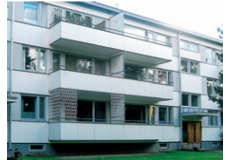
As Oy Pieni villasaarentie 1:n alkuperäiset siporex-julkisivut.
