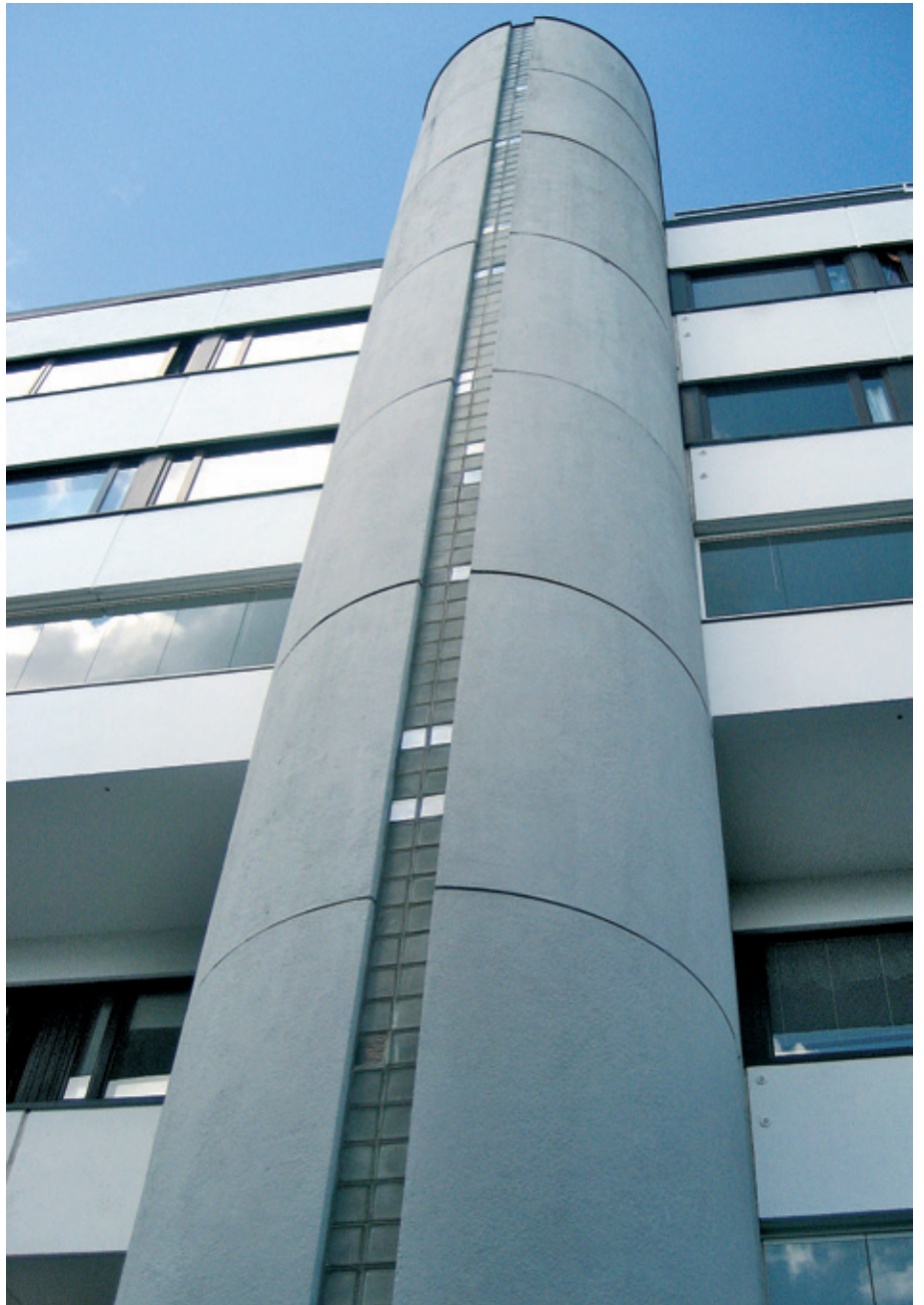
As Oy Säästöniemen hissikuilu.
