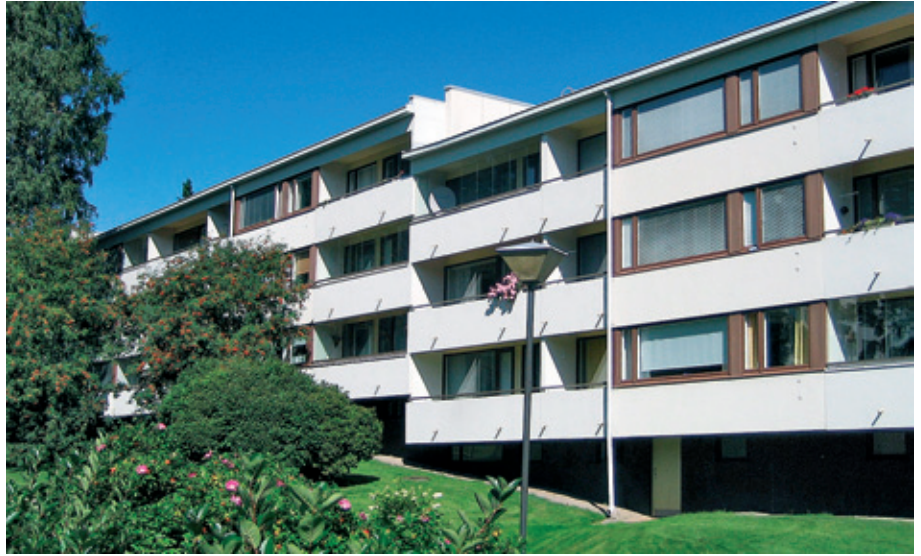
As Oy Lokkisaarentien lamellin pitkällä sivuilla alkuperäiset betonipinnat ovat säilyneet.
