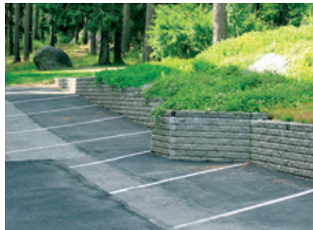
Ladottavista muurikivistä tehdyt tuennat eivät sovi alueen yleisilmeeseen.
