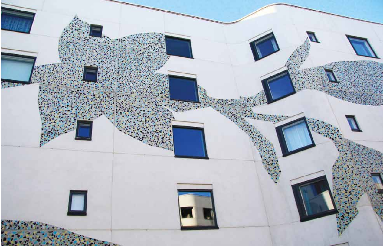
Hekan vuokrakohde Arabianrannassa. Att:n rakennuttama ja vuosina 2011–2012 valmistunut korttelikokonaisuus palkittiin vuoden 2011 betonirakenteena. Kuva: Annina Ala-Outinen.
