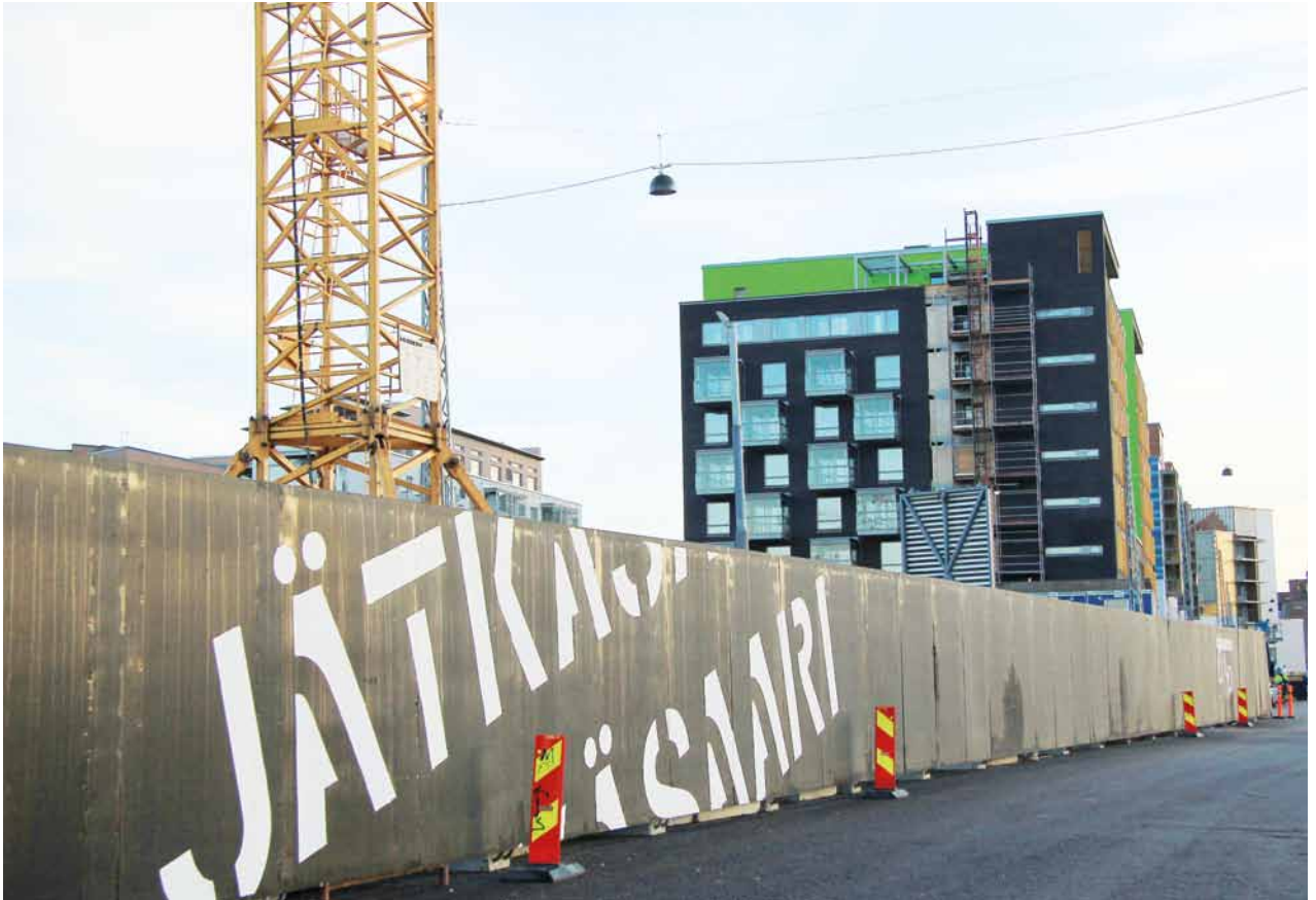
Länsisataman projektialueelle on jo valmistunut 570 asuntoa, ja rakentaminen alueella jatkuu aktiivisena uusien tontinvarausten myötä. Kuva: Annina Ala-Outinen
