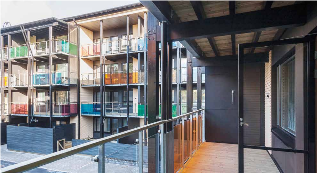
Att:n rakennuttama asumisoikeuskohde Omenapuisto Vuosaarella. Kuva: Att.
