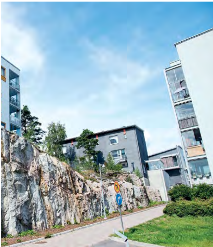
Viikiniemessä alkaa 2017 viiden uuden asuntohankkeen ja niitä palvelevan pysäköintitalon rakentaminen. Lisäksi alueelle rakennetaan pieni päivittäistavarakauppa.
