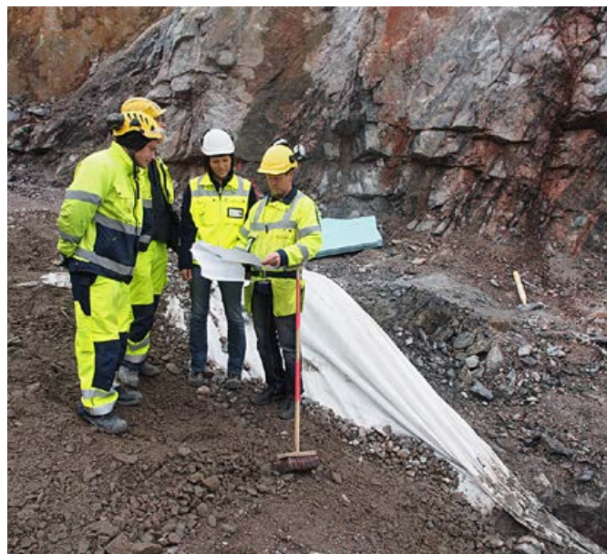
Byggnadsarbeten på Viksbacka.
