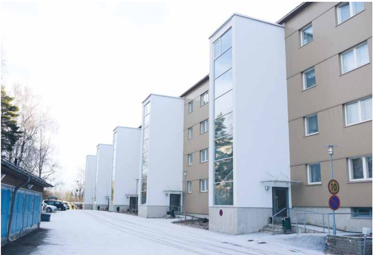
Hekan taloon jälkiasennettuja hissejä Siilitiellä. Kuva: Simo Merilä.
