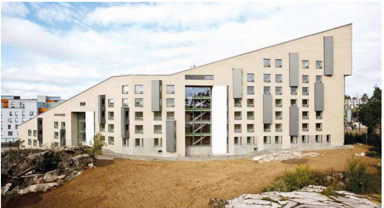
Att:n rakennuttama vuokra-asuntokohde Heka Harjannetie. Kuva: Pertti Nisonen.
