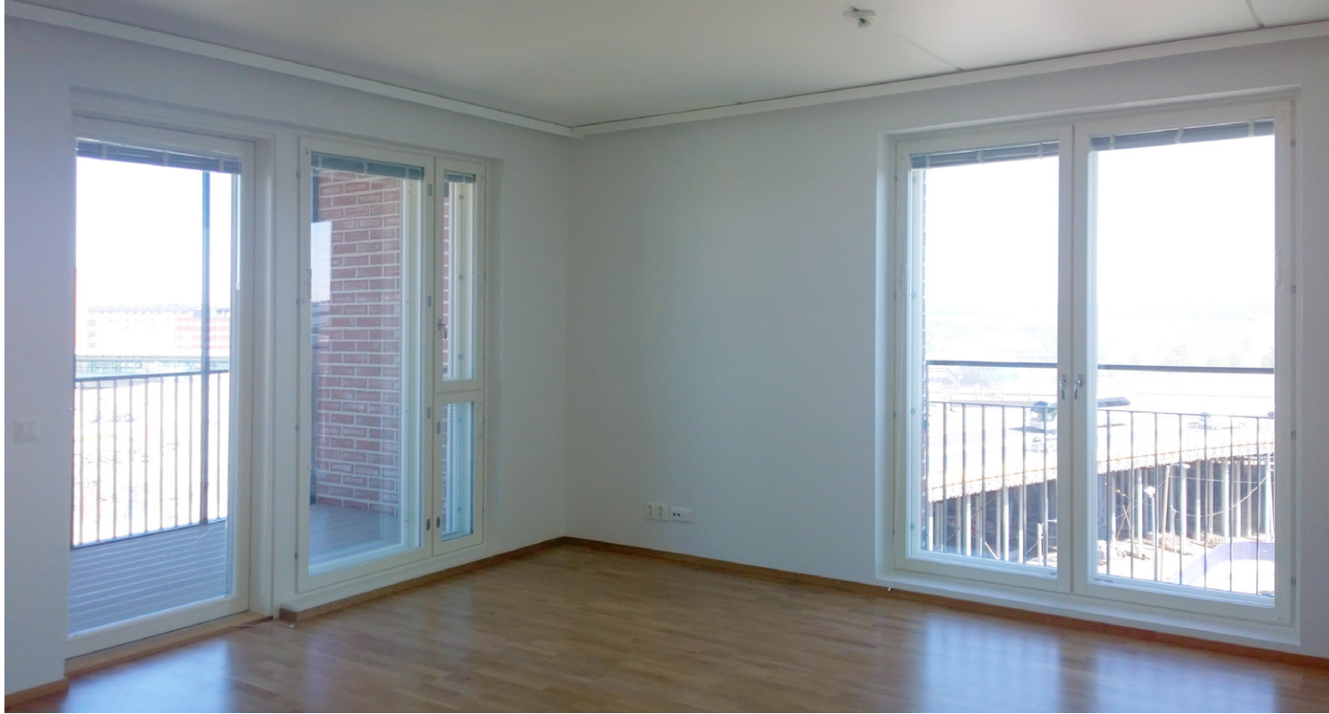
Kohde 14. Asunto Oy Helsingin Leonsatama 2012. Lattialämmitys mahdollistaa lattiaan asti ulottuvat ikkunat sekä siistin ikkunaseinän asunnoissa.
