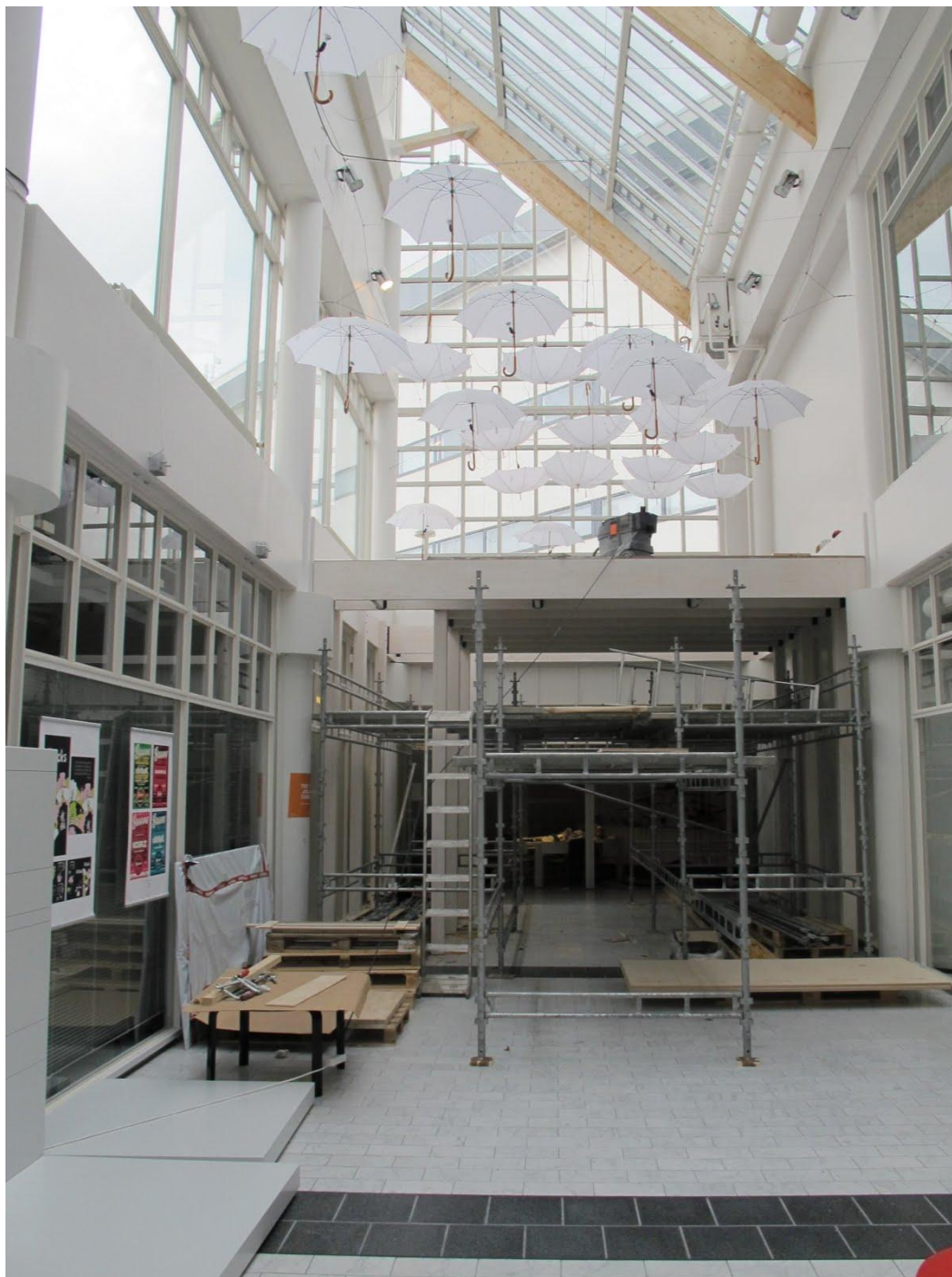
Parvi tuo lisätilaa Lummetien aulaan. Se mahdollistaa kohtaamisia ja yhteistyötä luoden aulaa viihtyisän, monipuolisen ja helposti muokattavan tilakokonaisuuden. Parven on suunnitellut ja rakentanut Metropolian muotoilun opiskelijat.
