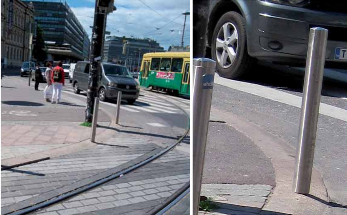
Kuva 25. Esimerkki sekä pyöräilyn sujuvuuden että esteettömyyden kannalta onnistuneesta luiskauksesta Helsingin Kaivokadulta. Luiskan tyyppiirustus on laadittu Helsinki kaikille -projektin yhteydessä ja löytyy verkkosivulta http://www.hel.fi/static/hkr/helsinkikaikille/tyyppiirustukset/29263_03_erotettu_jkpp.pdf .
