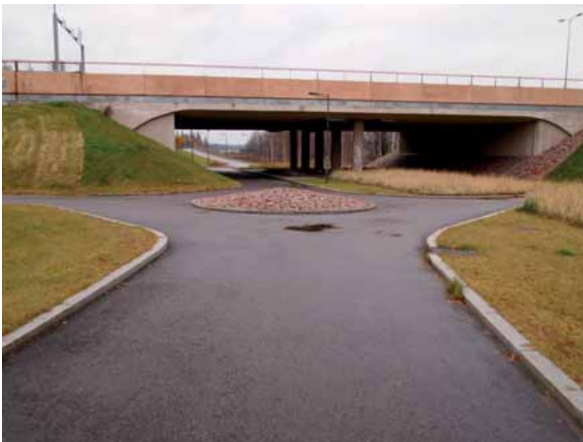
Kuva 30. Esimerkki pyörätien kiertoliittymästä, jolla varmistetaan risteävän liikenteen turvallisuus alikulun yhteydessä. Kuva Espoon Suurpellosta.
