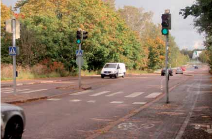
Kuva 27. Esimerkki liikennevalopylvään väärästä sijoittamisesta pyörätielle. Vilkkaalla pyöräreitillä pylvään väistäminen aiheuttaa yllättäviä vaaratilanteita kaksisuuntaisessa liikenteessä. Kuva Helsingistä.
