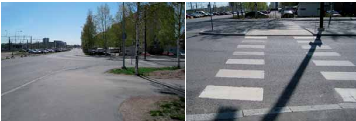
Kuva 24. Esimerkki nykyisen pyörätien heikosta jatkuvuudesta sekä sujuvuutta heikentävistä reunakivistä katuverkon liittymässä (kuva Teppo Pasanen/Vantaan kaupunki). Niin sanottu esteettömyysreunakivi muodostuu pyöräilijän kannalta esteeksi, mikäli se ulotetaan suojatien lisäksi myös pyörätien jatkeelle.
