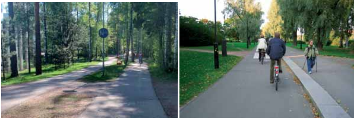
Kuva 20. Esimerkkejä pääpyöräreittien toteutuksesta kaupunkimaisessa puistoympäristössä, jossa on paljon jalankulkua. Oikeanpuoleinen kuva on Helsingin Töölönlahdelta (kuva Pyöräilykuntien verkosto).
