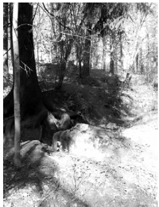
(ylin) Näkymä Vähäkasken ja Klaukkalantien kulmasta maalinnoiteluolan työmaalle. (keskellä) Ratsastusreitit ja kevyenliikenteen raitit sulassa sovussa. (alin) Mäen harjanteella on lukuisia maalinnoitekaivantoja.
