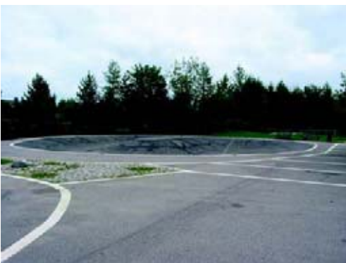
(ylin) Näkymä pohjoisesta. (alin) Leikkipuiston allas.
