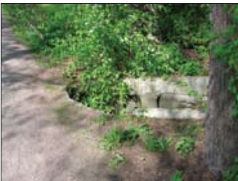
Yllä: Valkopaadentien betonipäällysteiset joukkoliikennekaistat
