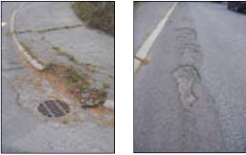
Rastilantiellä epätasaisuutta ja asfalttia puuttuu Isonvillasaarentieltä
