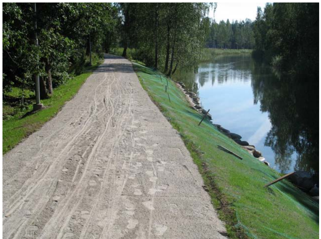
Kuva 23. Vanhanväylänpuiston kevyen liikenteen väylän kunnostus tulvapenkereeksi.
