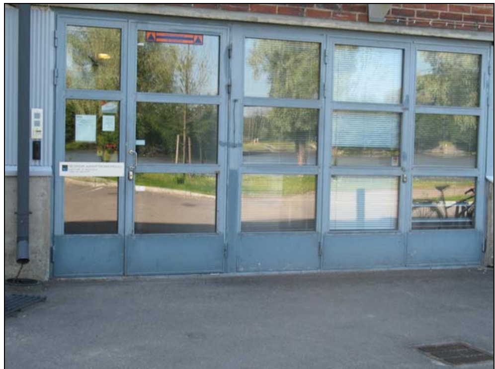
Kuva 12. Helsingin ammattikorkeakoulun kulttuuri ja palvelualan toimipisteelle Hämeentiellä saattaa aiheutua vesivahinkoja pihapiiriin nousevan tulvaveden seurauksena.
