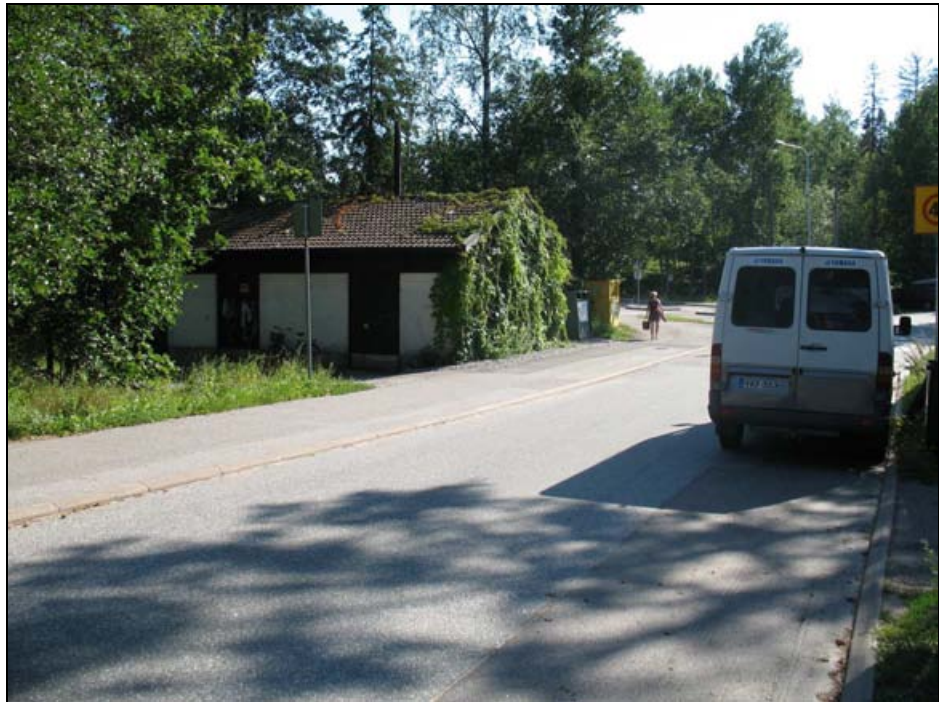
Kuva 27. Hevossalmentien ja Laajasalontien risteyksessä sijaitseva muuntaja.
