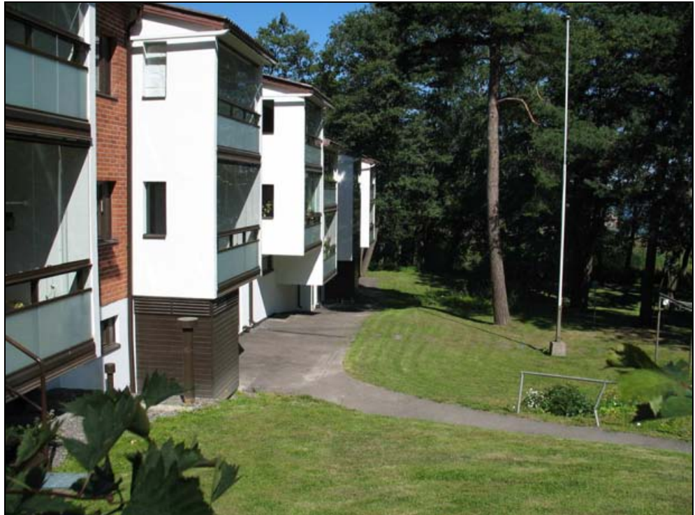
Kuva 5. Vesi pääsee Pohjoiskaari 29 kellarikerrokseen merenpuoleiselta alueelta.
