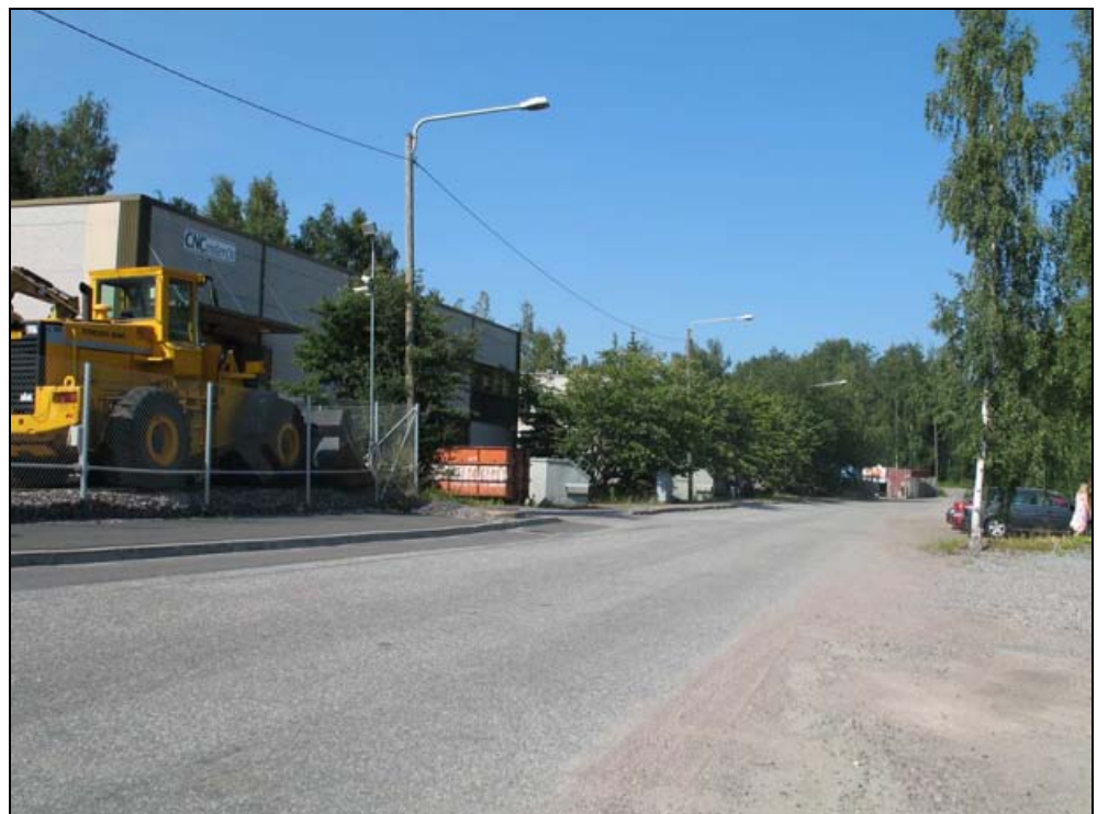
Kuva 13. Tulvatilanteessa vedenpinta nousisi Säynäslahdentien teollisuusrakennuksiin.
