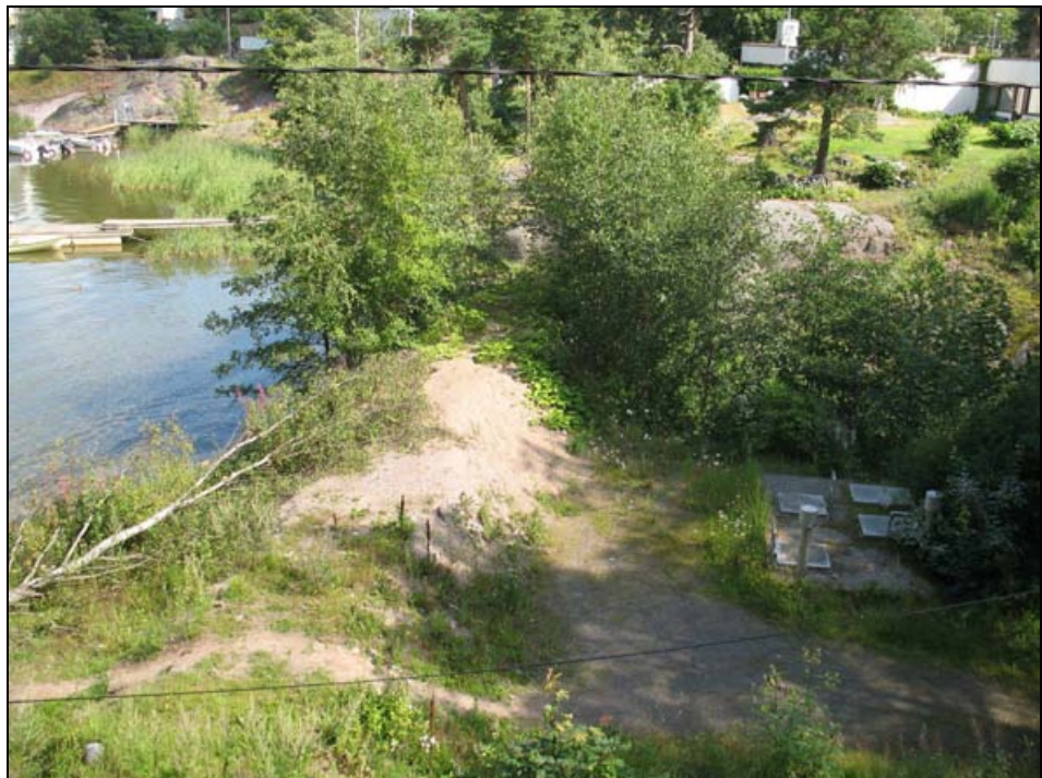
Kuva 26. Kaitalahden nykyinen pumppaamo ja sen maarakenteinen tulvapenger.
