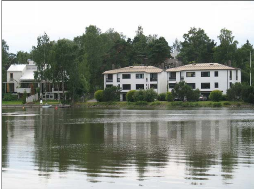
Kuva 17. Tulvatilanteessa vesi nousee rakennusten pihapiiriin (riskikohde 1).
