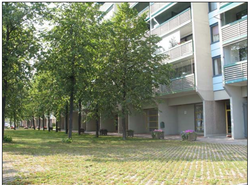
Kuva 10. Merihaassa sijaitsevat kaksi kerrostaloa (riskikohde 1) jäävät tulvatilanteessa saarroksiin.
