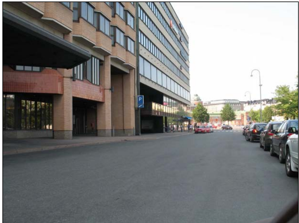
Kuva 9. Vesipinnan noustessa ajoradalle ovat kiinteistön maanalaiset pysäköintitilat vaarassa joutua veden alle. Vesi pääsee ajoluiskia pitkin mm. hotellin parkkihalliin.
