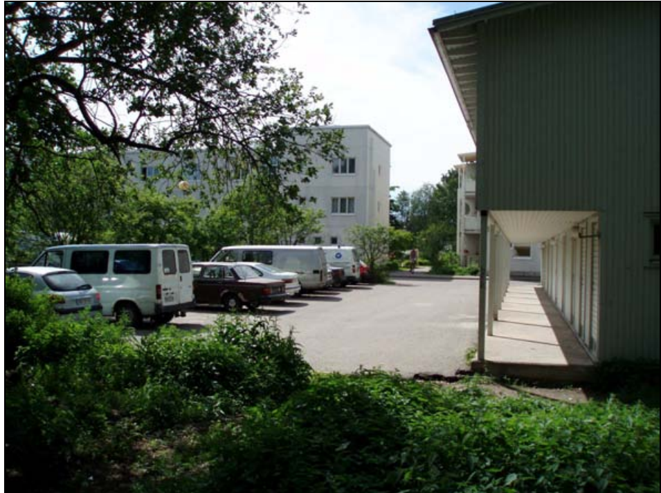
Kuva 22. Vesi nousee Abraham Wetterin tien varrella sijaitsevien kerrostalojen ja varastorakennuksen (riskikohde 7) pihapiiriin saakka.
