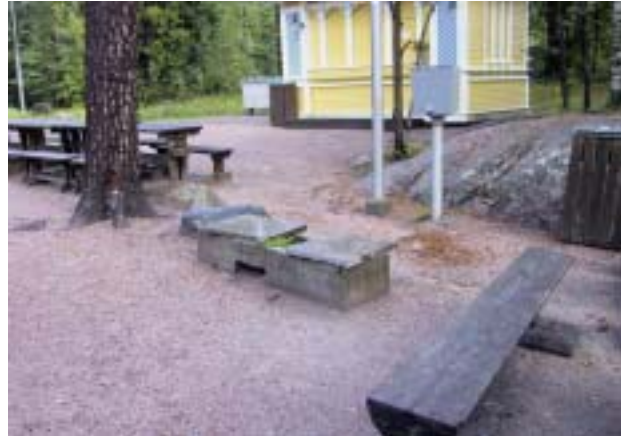
Puiset rakenteet ovat kuluneita ja kohta jopa vaarallisia. Viheralueet ovat kuluneita ja vanhojen puiden juuret paljastuvat.
