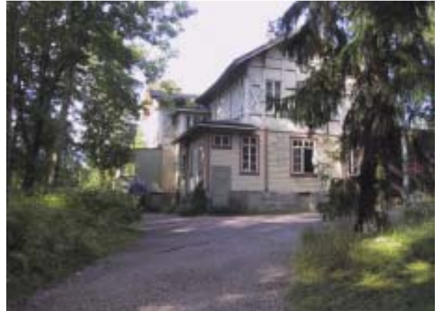
Ravintolan välitön lähiympäristö on villiintynyt ja ränsistynyt. Kivirakenteet, kuten muurit ja portaat, ovat huonokuntoisia.
