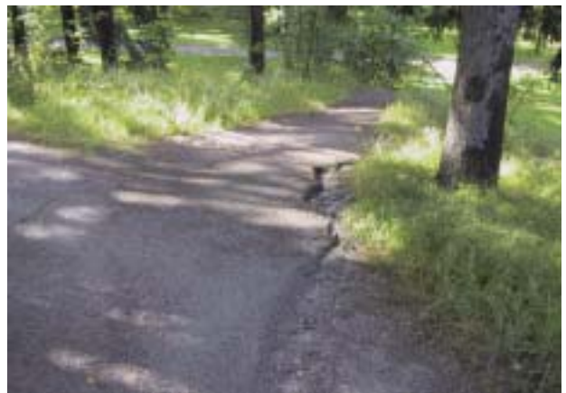
Sadevesi on syönyt syvät uurteet käytävän kivituhkاپintaan. Käytävien alusrakenne on tähän paikkaan väärtä. Kunnossapidon tarve kasvaa ja liikkuminen vaikeutuu.
