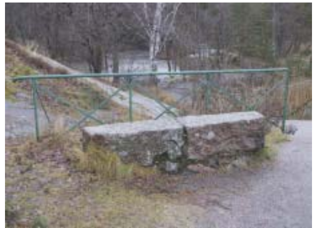
Kallioportaikon levähdystasanne. Alkuperäinen, hento metallikaide muistuttaa kansan- puistoajan kepeästä ulkoilmaelämästä.
