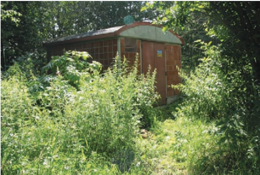
Muuntamo Immolantien ja Ollilantien kulmassa.
