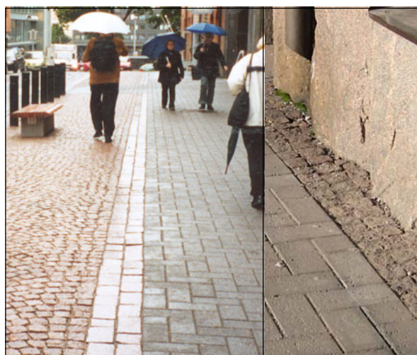
Noppakiveä, nupukiveä ja betonikiveä, noppakivellä tehty sokkeliliitos (Yrjönkatu).
