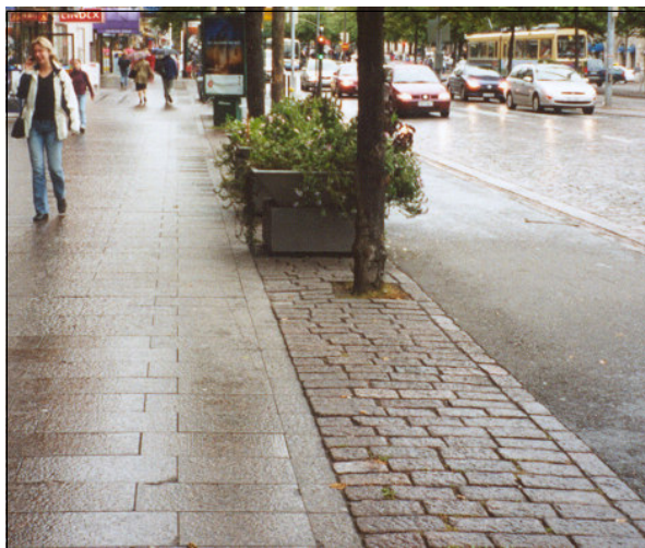
Graniittilaattaa, nupukiveä ja asfalttia (Mannerheimintie).
