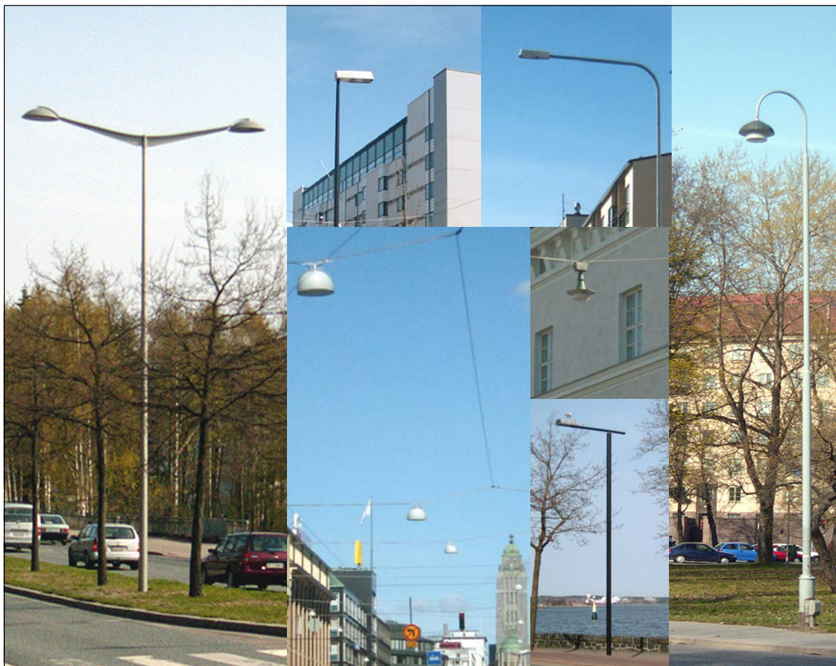
Helsingissä käytettyjä valaistuslaitteita.
