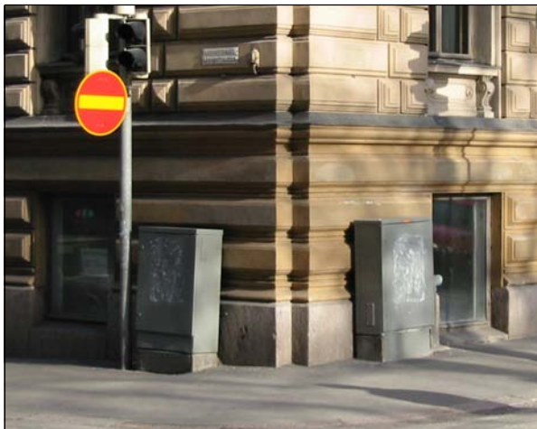
Kantakaupungissa jakokaapit tulisi sijoittaa rakennuksiin eikä rakennusten seinustoille (Yrjönkatu).
