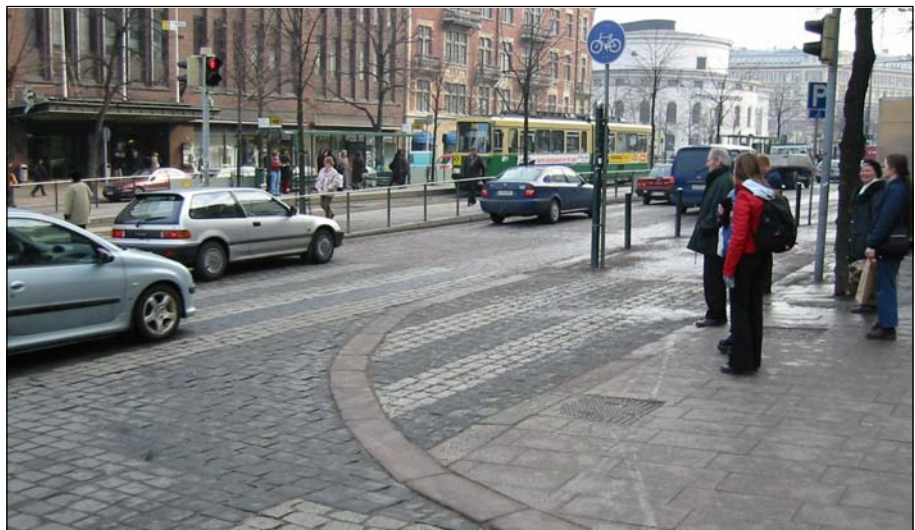
Kadun pinnan tasoon painetut reunakivet osoittavat kadun käyttäjäryhmien alueiden rajat. Suojatiekiveys pyörätiellä vahvistaa sanomaa (Mannerheimintie).
