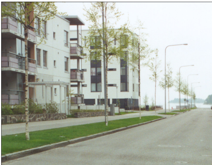
Leveä (3.25 m) istutettu välikaista (Hiekkalaiturintie).
