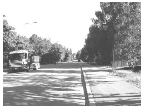
Isonnevantie koulujen kohdalta.
