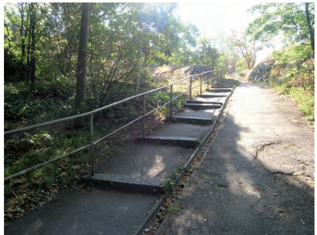
Rinteen pitkät ja vaaralliset maastoportaat peruskorjataan erillisen suunnitelman mukaan.
