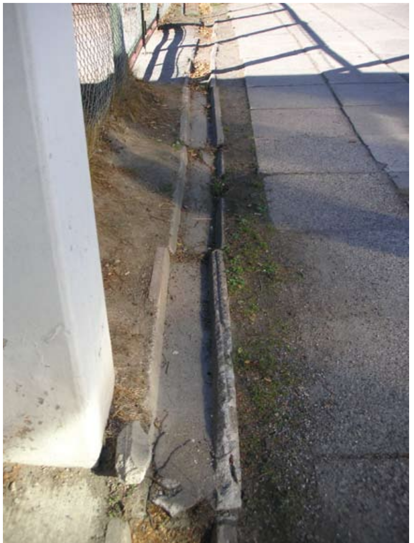
Kadun betonikouru on huonossa kunnossa.
