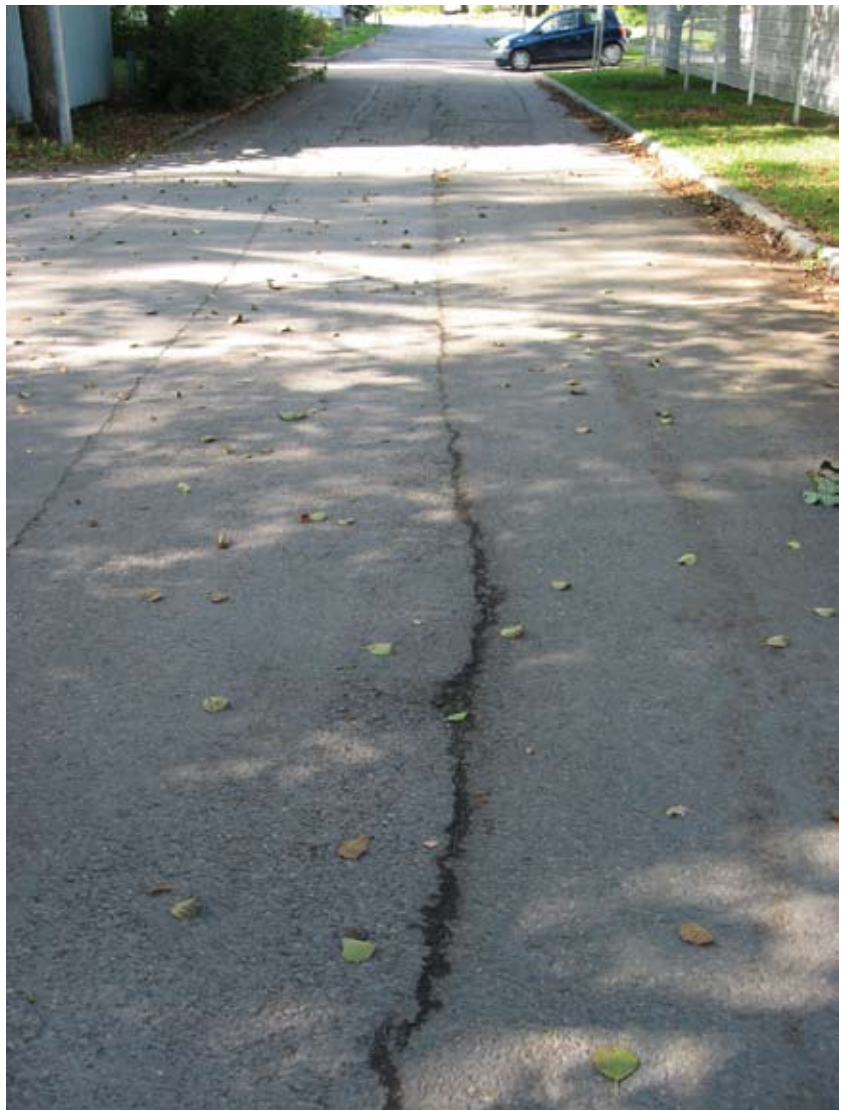
Pitkittäishalkeamia ja painumia kevyen liikenteen väylällä
