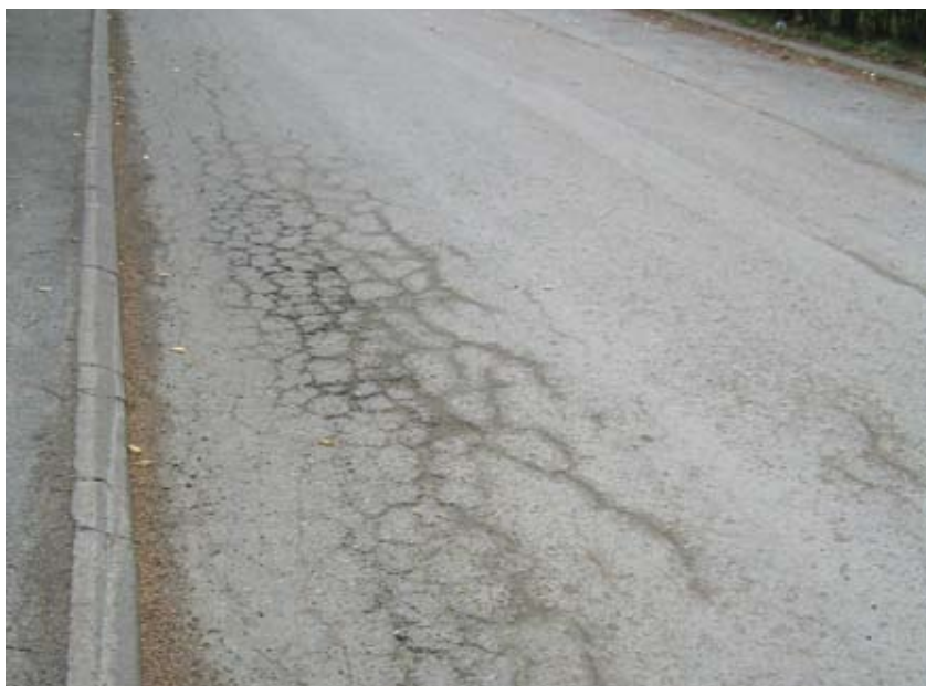
Ajoradalla on verkkohalkeamia.
