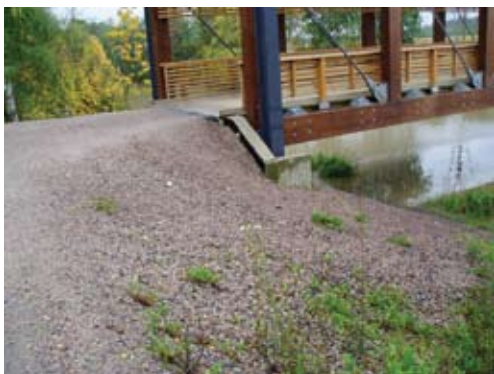
Sillan reunat ovat sorapintaisina eroosioherkkiä.
