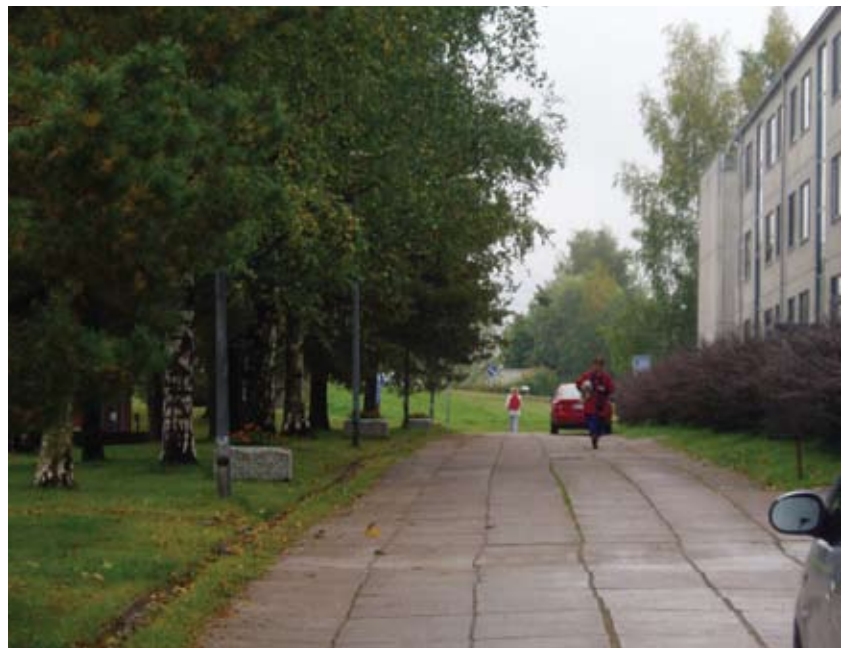
Betonilaatat ovat liikkuneet.
