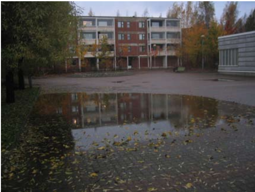
Maatullinkujalle muodostuu lammikoita kiveyksen painumisen johdosta.
