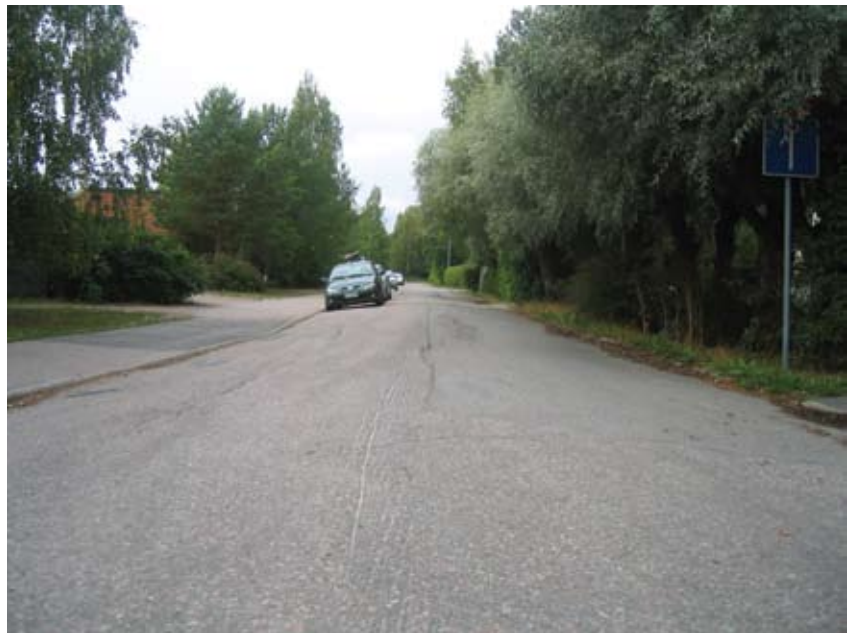
Katu on painunut ja routinut huonoon kuntoon.
