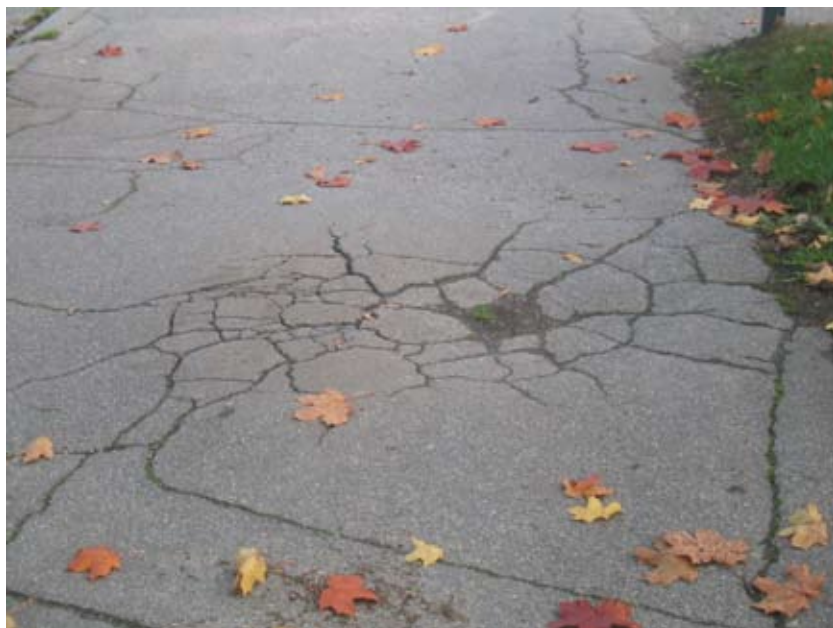
Kauriintiellä on paljon verkkohalkeamia.
