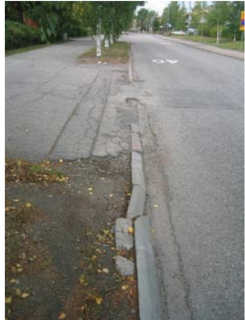
Liimattavat betonireunatuot irtoilevat helposti
